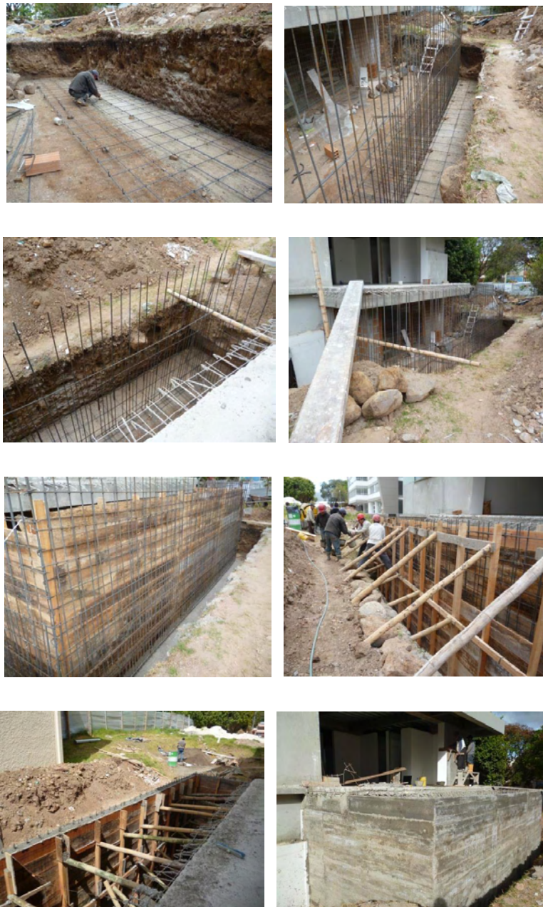
Figura 41. Construcción muro de contención.
