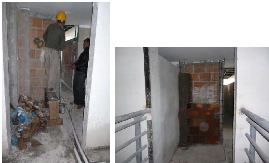
Figura 35. Instalación red contra incendios.
