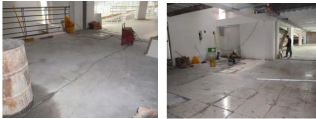
Figura 21. Enchape de piso en porcelanato.
