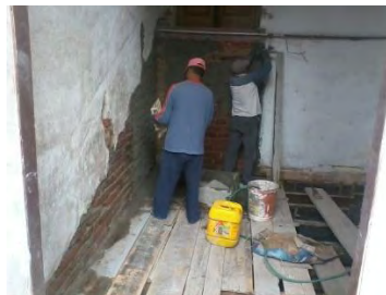
Figura 95. Pañete sobre muros interiores.
