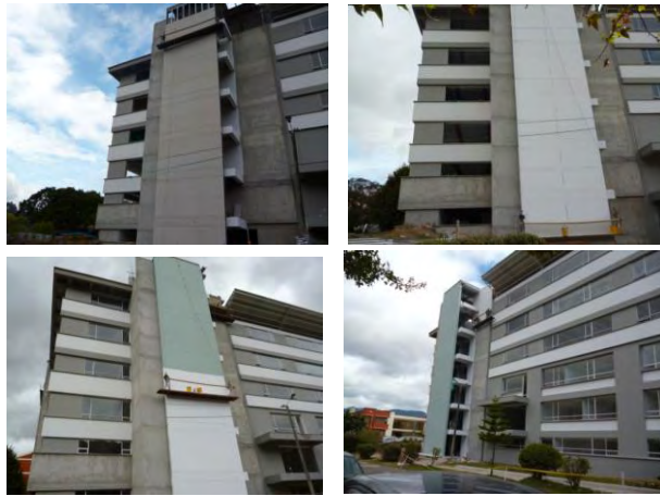
Figura 27. Muro en fibrocemento para fachada.
