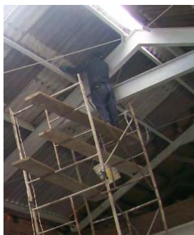
Figura 97. Instalación de caballetes.
