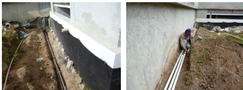
Figura 45. Instalación red hidráulica \phi=1\ 1/2'' .
