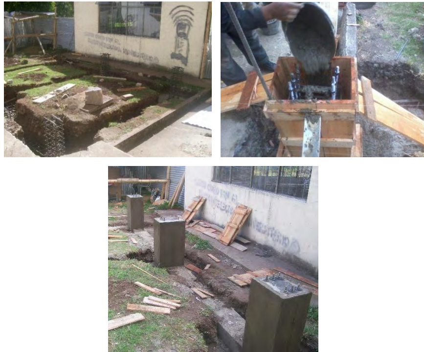
Figura 69. Construcción de pedestales en concreto.
