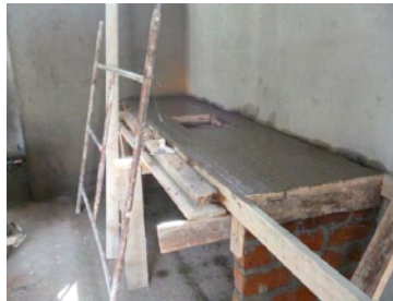
Figura 59. Construcción de mesones.
