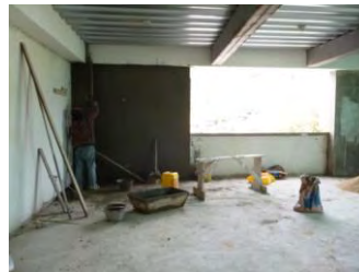
Figura 56. Pañete y estuco en columnas, pantallas, vigas y ventanas.
