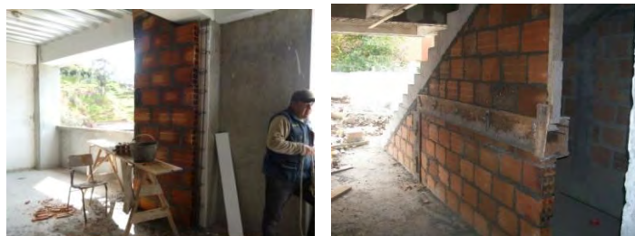
Figura 9. Construcción muro bloque No. 5.
