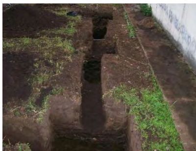
Figura 66. Excavación en material común.
