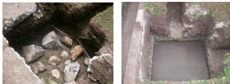
Figura 78. Mejoramiento concreto ciclópeo.
