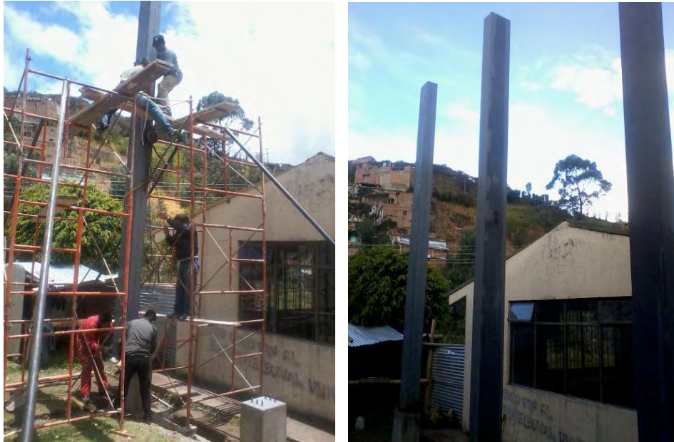
Figura 74. Instalación perfil PHR 355x220 calibre 3 mm.
