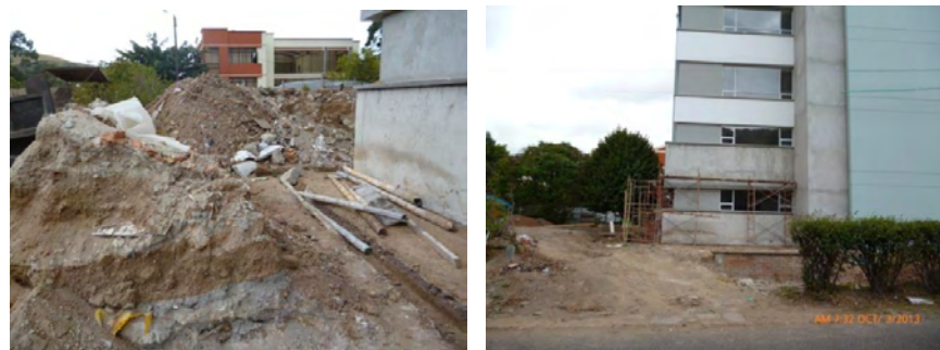
Figura 43. Desalojo de escombros.
