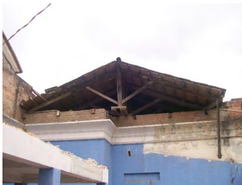
Figura 98. Instalación de vigas en madera.
