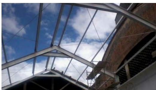
Figura 92. Instalación de templete \phi=5/8" .
