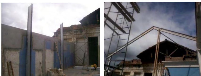
Figura 90. Instalación de perfiles IPE 270.
