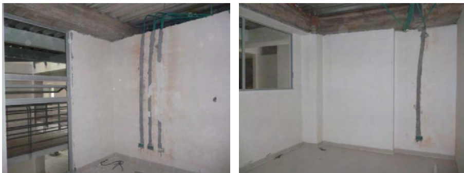
Figura 49. Instalación de ductos eléctricos.
