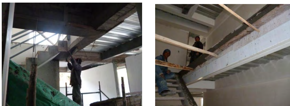
Figura 17. Pañete sobre vigas de escaleras.
