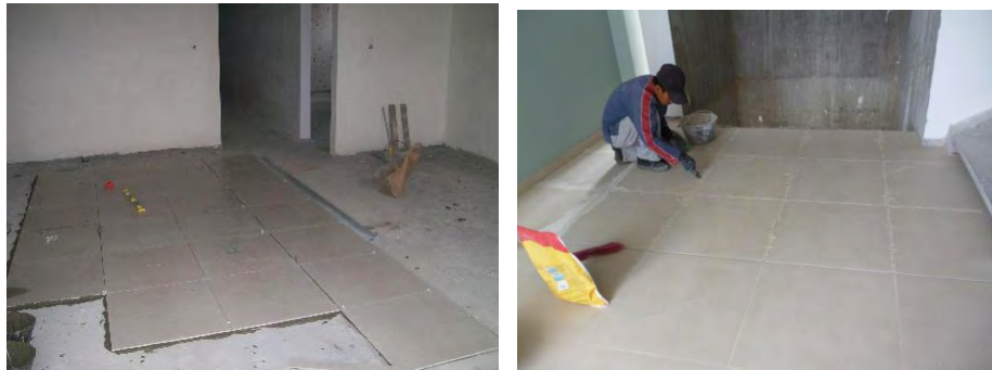
Figura 51. Enchape de piso en porcelanato.
