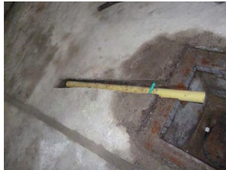
Figura 31. Instalación de sifón de piso.
