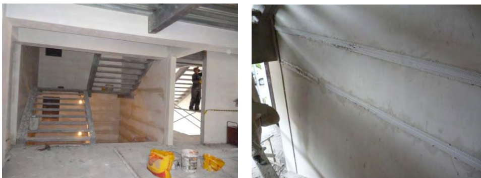
Figura 12. Instalación dilatación plástica.
