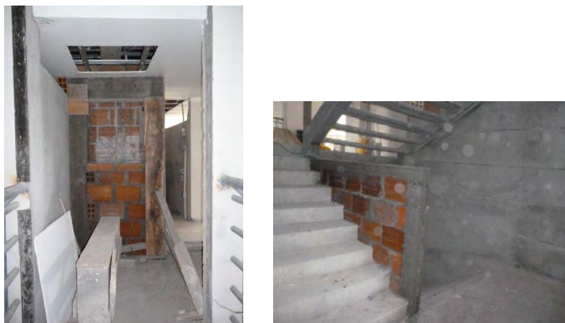
Figura 11. Construcción viguetas de confinamiento.
