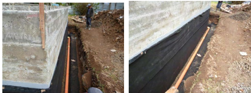
Figura 40. Construcción filtro en grava.
