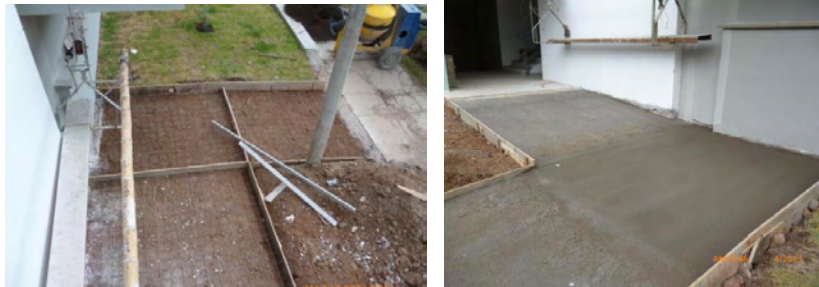
Figura 42. Fundición de andenes y rampa.
