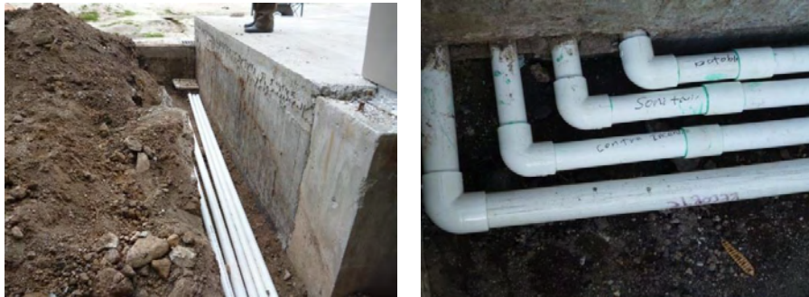
Figura 46. Instalación red hidráulica \phi=2'' .
