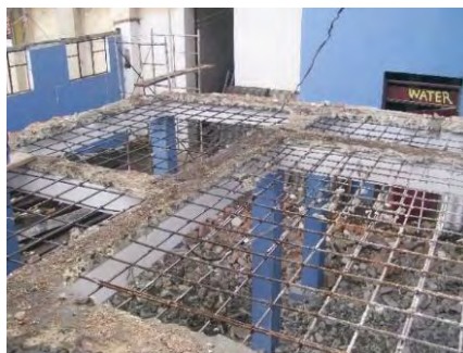
Figura 83. Demolición de placa maciza.
