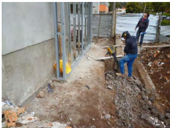
Figura 14. Pañete impermeabilizado para fachada.
