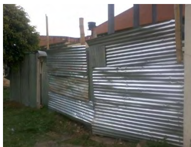
Figura 65. Cerramiento en lámina galvanizada.
