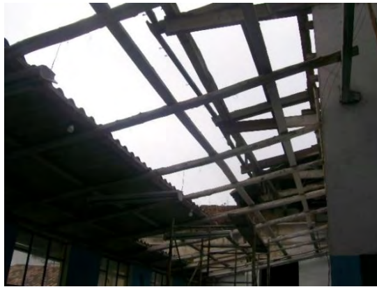
Figura 79. Desmante de teja en fibrocemento.
