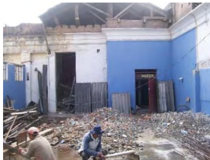
Figura 86. Desalojo de escombros en sitio.
