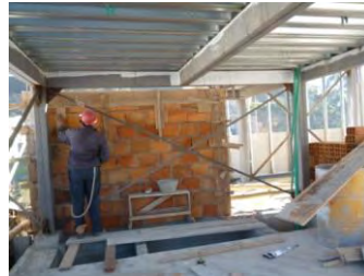
Figura 55. Columna de confinamiento.
