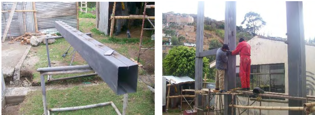
Figura 75. Instalación perfil PHR 220x160 calibre 2 mm.
