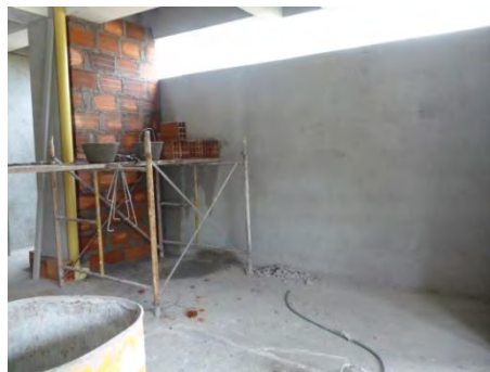
Figura 64. Instalación de bajantes \phi=4" .
