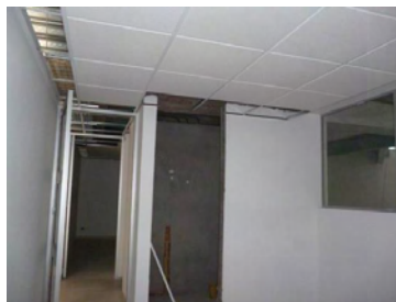
Figura 60. Remate en cielo raso.
