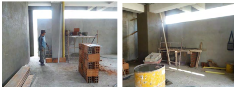
Figura 63. Fundición de bajantes.
