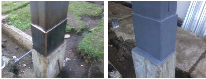
Figura 71. Encamisado columnas cajón.
