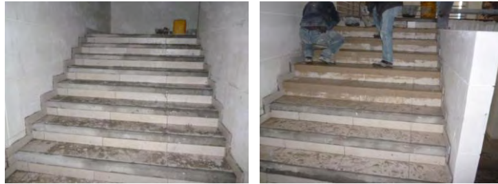
Figura 24. Acabado de escaleras en granito lavado.
