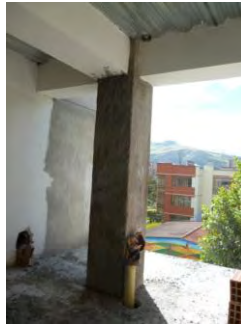
Figura 30. Instalación de bajantes.
