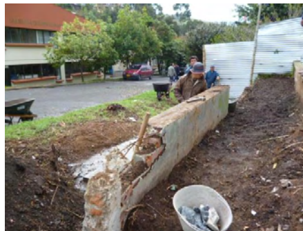
Figura 39. Demolición de viga reforzada.
