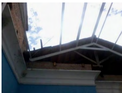
Figura 91. Instalación de perfiles PHR 160x60 calibre 2.0 mm.
