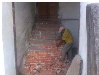
Figura 96. Demolición de escalera en mampostería.
