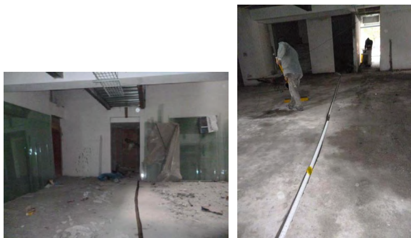
Figura 33. Instalación red hidráulica.
