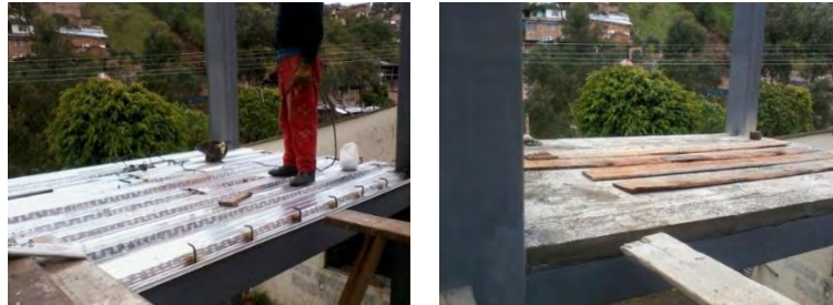
Figura 76. Construcción placa maciza.
