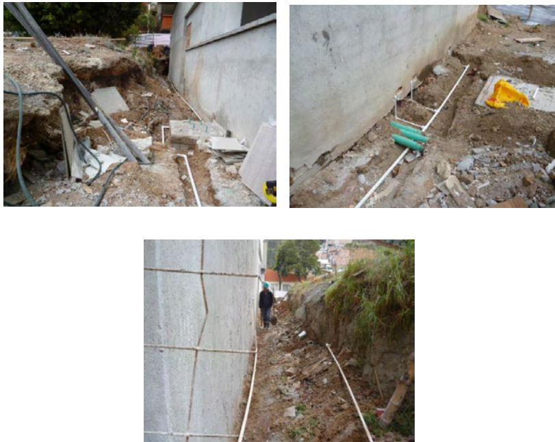
Figura 44. Instalación de red hidráulica \phi=1'' .
