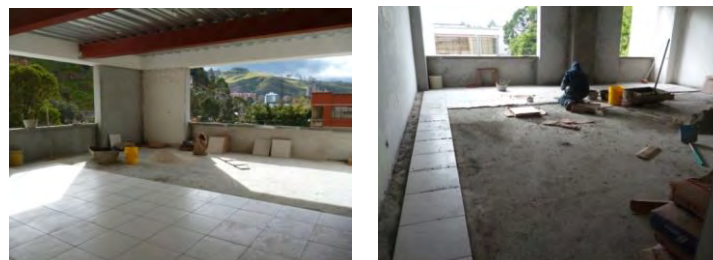
Figura 20. Enchape de piso en cerámica.
