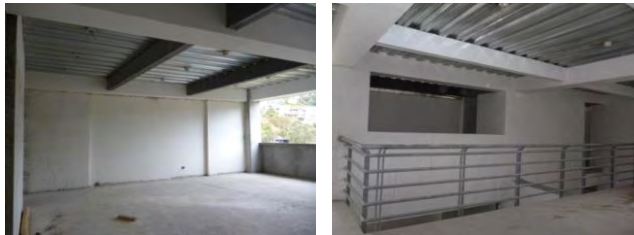
Figura 28. Limpieza de metaldeck.
