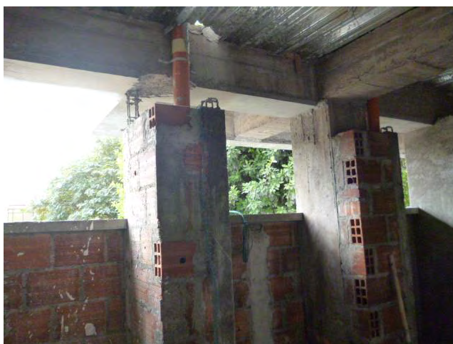
Figura 13. Mochetas en ladrillo bloque No. 5.
