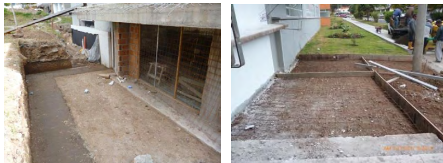
Figura 38. Relleno en recebo compactado.
