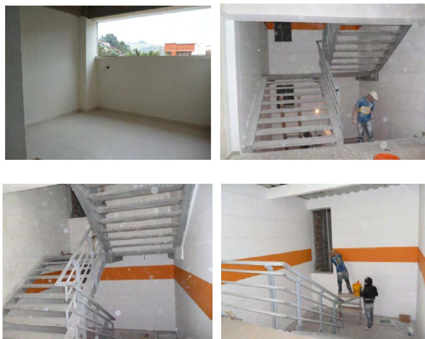
Figura 32. Pintura de muros.
