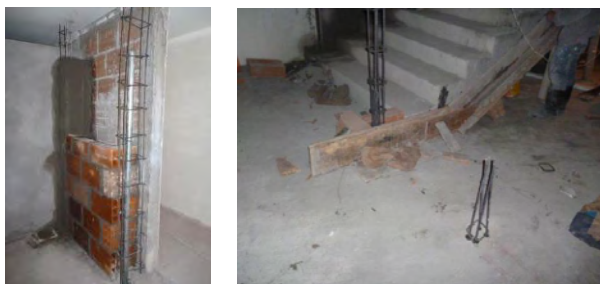
Figura 10. Fundición columnas de confinamientos
