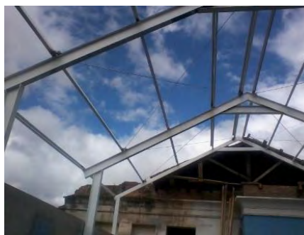
Figura 89. Instalación de perfiles PHR 160x60 calibre 2.5 mm.
