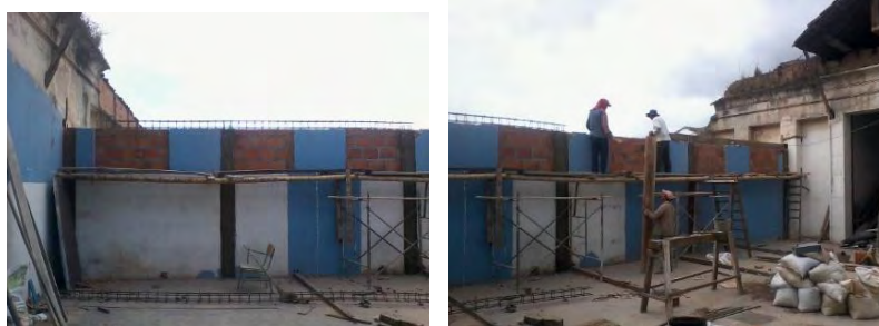
Figura 87. Construcción viga de confinamiento.
