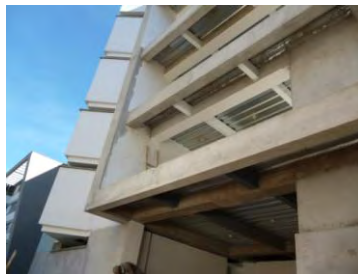
Figura 61. Cielo raso en fibrocemento.
