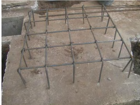
Figura 67. Construcción de zapatas.
