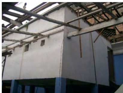
Figura 82. Desmonte de cielo raso.
