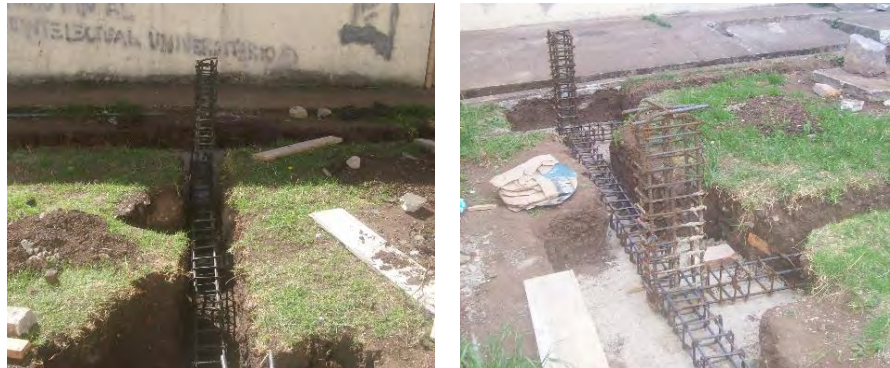
Figura 68. Construcción Vigas de Cimentación.
