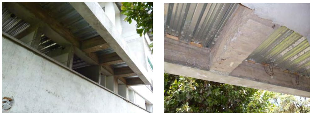
Figura 16. Pañete para vigas de fachada.
