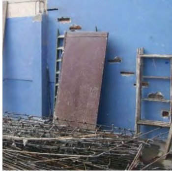
Figura 85. Desmante de puerta sencilla.
