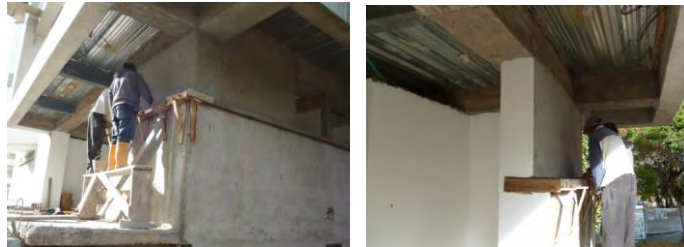
Figura 58. Alfajías en concreto.
