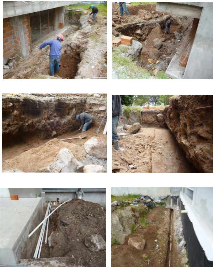
Figura 37. Excavación a mano.
