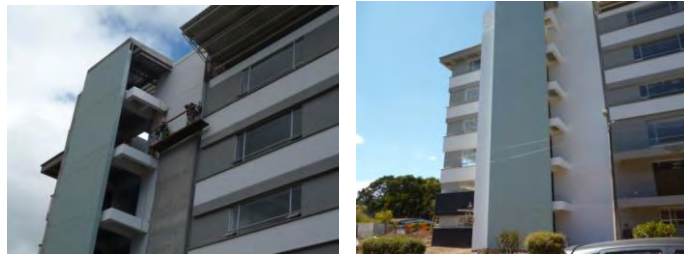
Figura 53. Pintura de exteriores.
