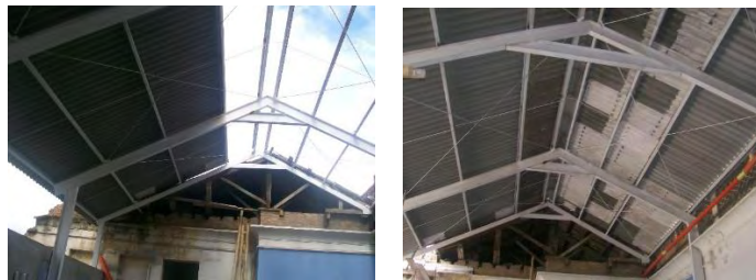
Figura 94. Cubierta en fibrocemento.
