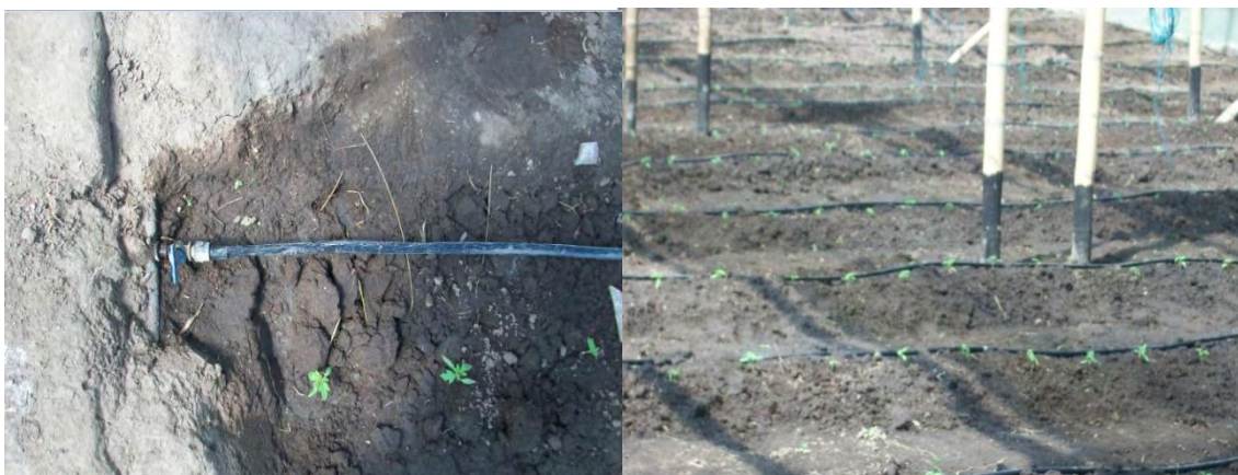
Figura 14. Sistema de riego por goteo
