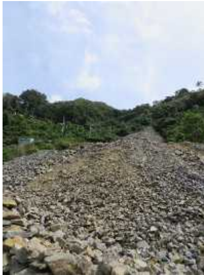
Figura 37. Escombros mina San roque
