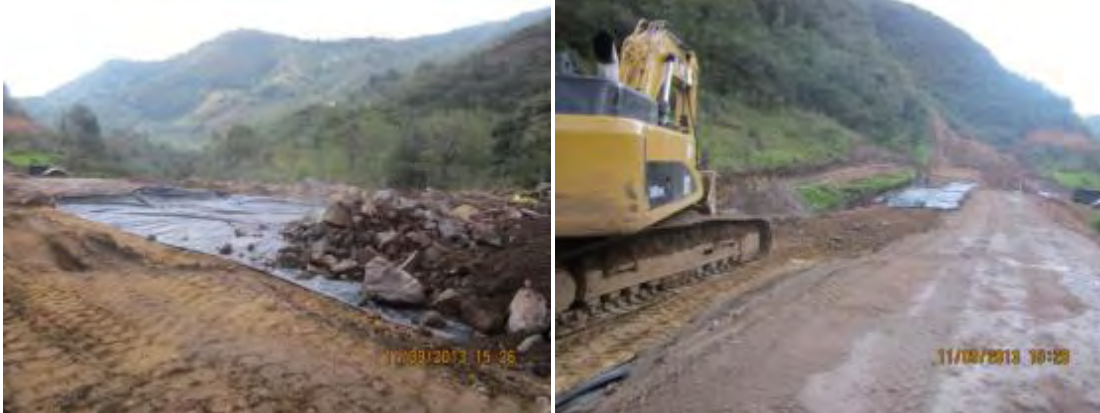
Figura 25. Extensión de Geotextil, extensión de rajón y material de recebo (100% Cantera La Cruz) y compactación del material.
