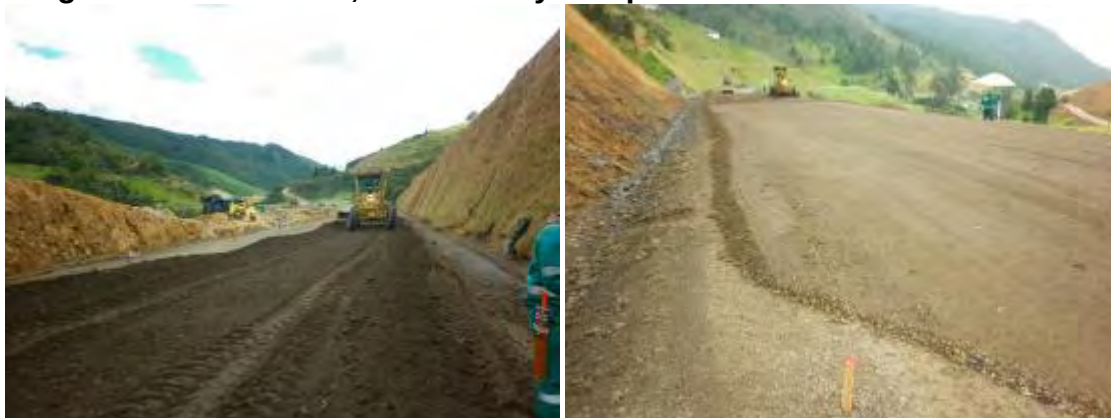
Figura 15. Extensión, nivelación y compactación de la Base Granular.
