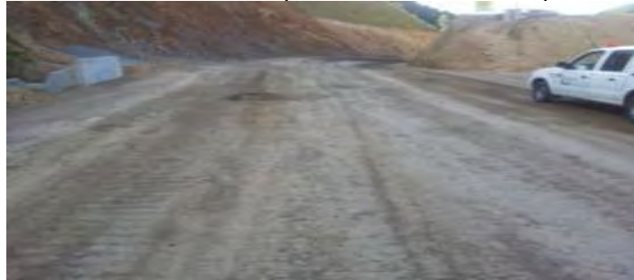
Figura 18. Extensión, compactación de material para Subbase.
