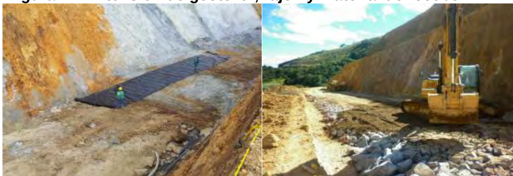
Figura 7. Extensión de geotextil, rajón y material de recebo.
