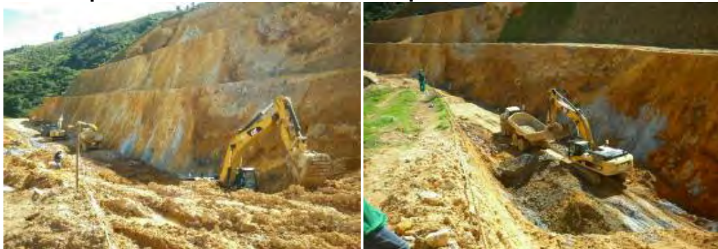
Figura 5. Conformación de calzada y perfilado de taludes. Cargue y transporte de material hacia el terraplén PR 0+690 a PR 0+790.
