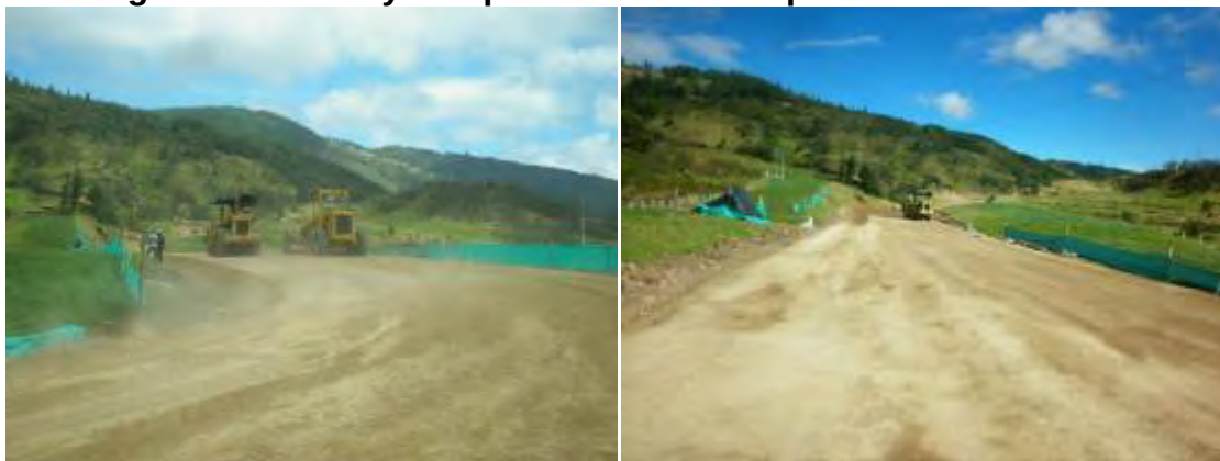
Figura 11. Céreo y compactación de la capa de Base Granular.
