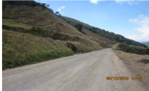
Figura 23. Conformación de capa Base granular lista para extensión de carpeta asfáltica.
