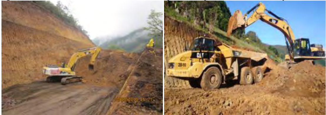
Figura 26. Corte: Perfilado de taludes y desalojo de material. Explanación.
