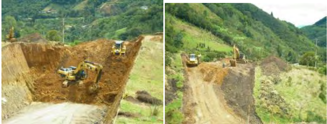
Figura 12. Corte, perfilado de taludes y transporte de materiales hacia SDM.
