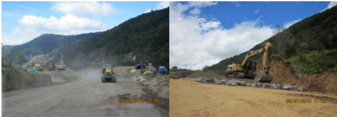
Figura 21. Conformación de capa Subrasante lista para extensión de Subbase. Extensión de material de recebo y rajón para mejoramiento de Subrasante.
