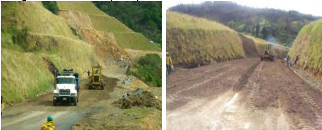
Figura 19. Extensión, compactación de la Base Granular.
