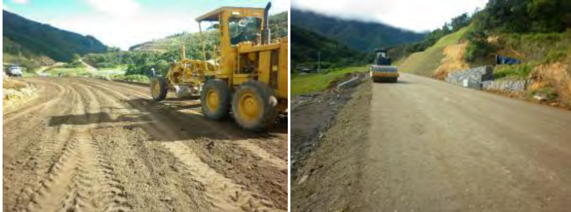
Figura 14. Extensión, nivelación y compactación de la Subbase Granular
