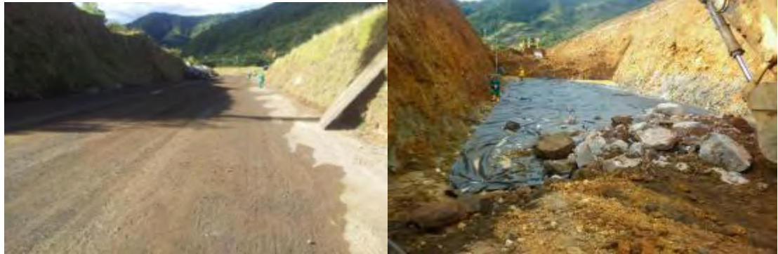
Figura 17. Extensión y compactación de material de Mejoramiento con geotextil, rajón y material seleccionado.
