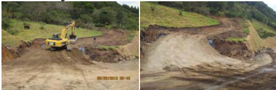
Figura 24. Construcción de acceso Vehicular.
