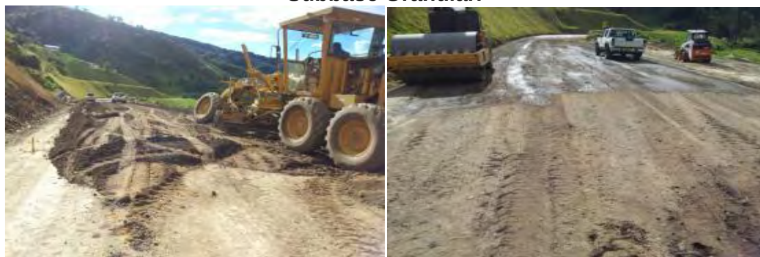
Figura 9. Extensión, nivelación, compactación y conformación de la Subbase Granular.
