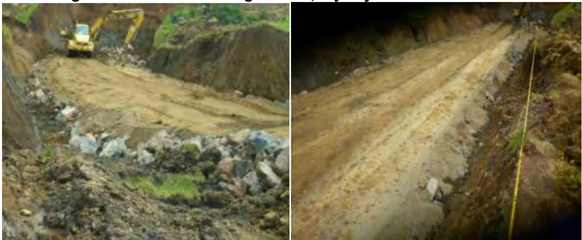
Figura 13. Extensión de geotextil, rajón y material de recebo.
