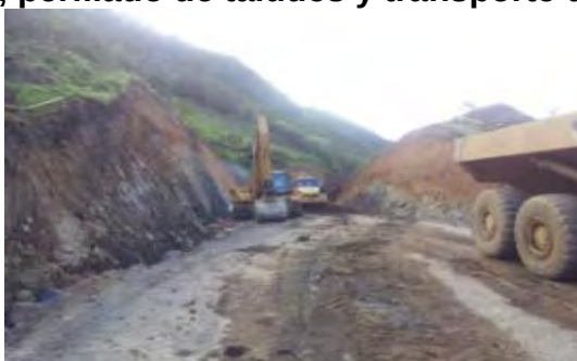
Figura 16. Corte, perfilado de taludes y transporte de material.
