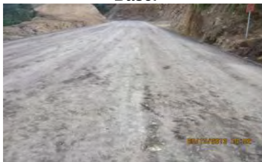
Figura 22. Conformación de capa Subbase granular lista para extensión de Base.
