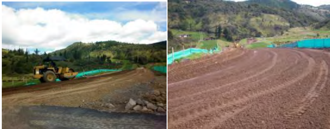
Figura 10. Extensión y compactación de la capa de Base Granular
