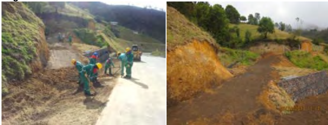
Figura 20. Adecuación de acceso. Extensión de material seleccionado.
