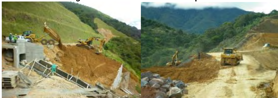
Figura 8. Conformación de Terraplén.
