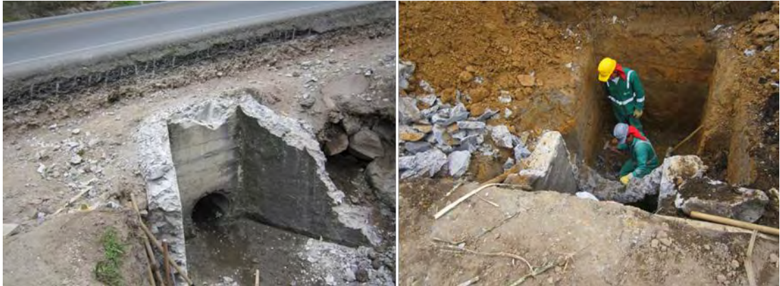
Figura N° 9 – Demolición estructuras - Demolición de cámara de entrada, muro cabezal y aletas, para prolongación de alcantarilla
