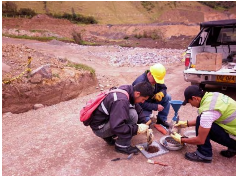
Figura N° 16 – Control de densidades – Medición de la densidad mediante método de cono de arena
