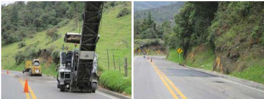
Figura N° 28 – Fresado – Fresado de superficie de pavimento asfáltico para parcheo.
