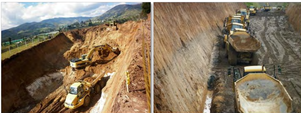
Figura N° 41 – Transporte – Transporte de material proveniente de explanación utilizando vehículos articulados.
