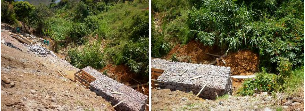
Figura N° 35 – Muro de contención en gaviones – Excavación, formaleta, canasta metálica y material de relleno.
