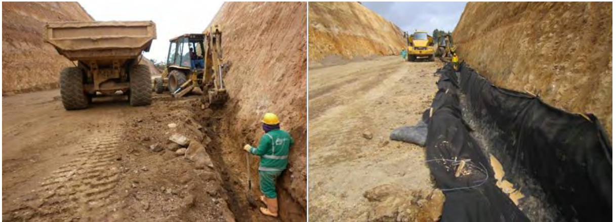
Figura N° 37 – Filtro longitudinal – Verificación visual de alineamiento y dimensiones
