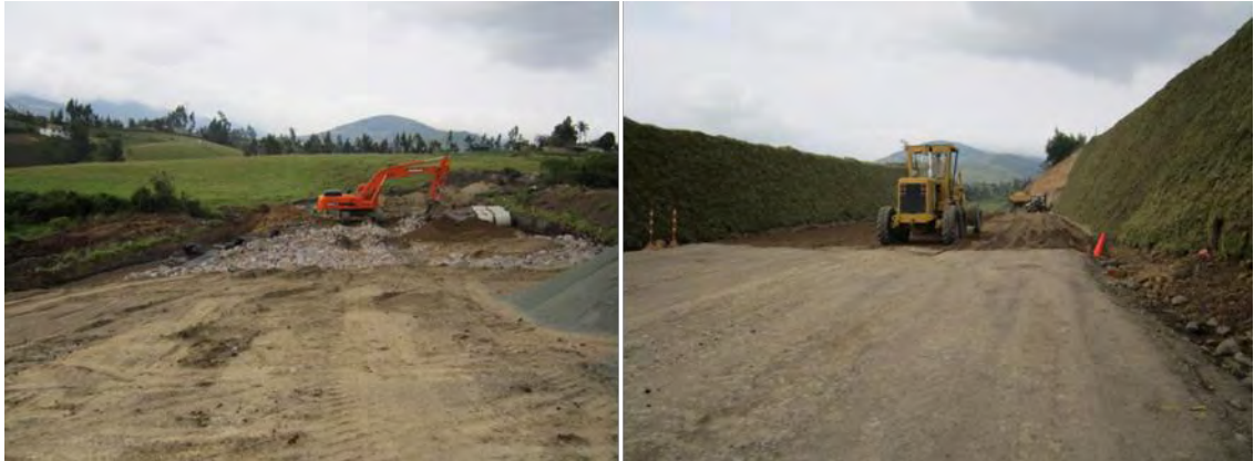
Figura N° 15 – Mejoramiento de subrasante – Extensión de geotextile, extension y conformación de rajón y capa de recebo
