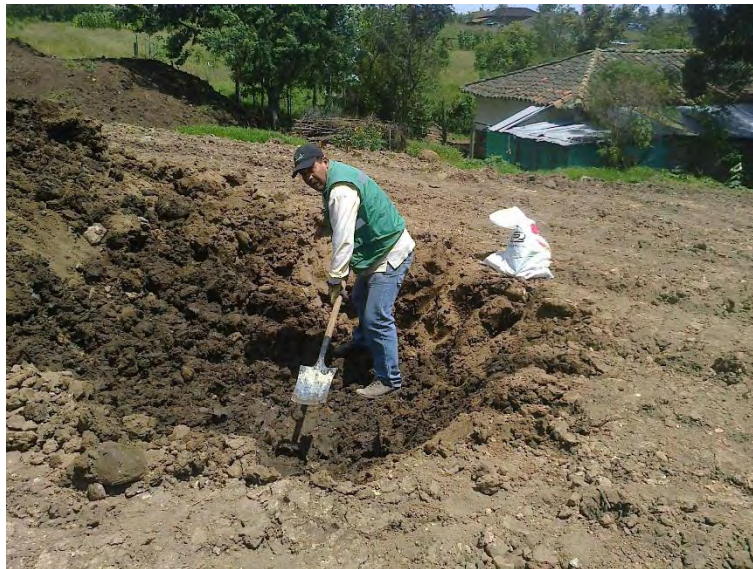
Figura N° 3 – Muestra de suelo – Material de corte depositado en SDM para ensayo de compresión simple
