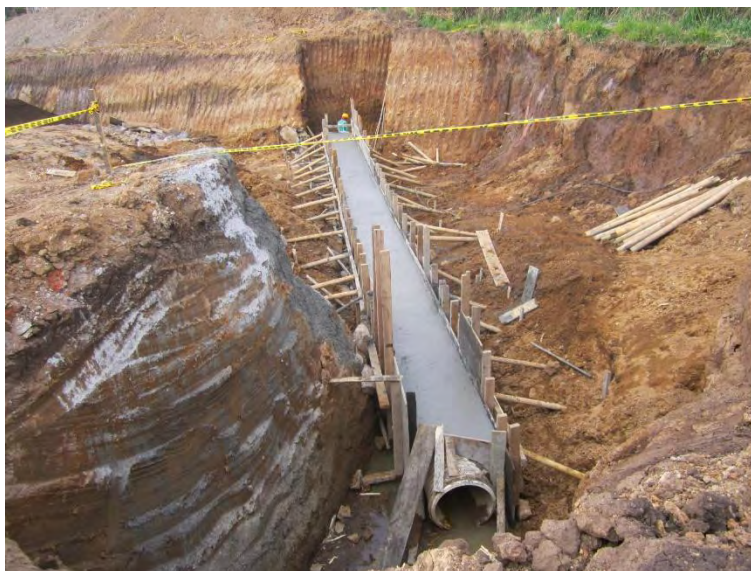
Figura N° 33 – Tubería en concreto reforzado – Instalación, unión y atraque lateral de tubería de 36”en concreto reforzado.
