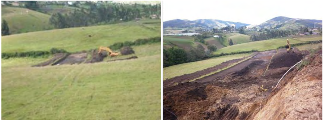
Figura N° 8 – Desmonte y limpieza - Retiro de capa vegetal y material orgánico.
