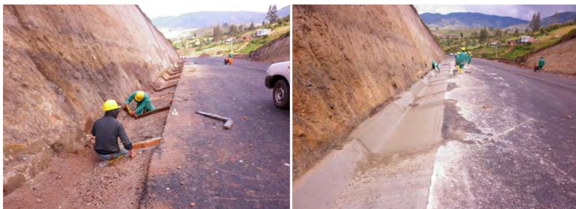
Figura N° 32 – Cunetas revestidas en concreto – Nivelación, compactación de superficie, colocación de formaleta y fundición de cunetas revestidas en concreto.
