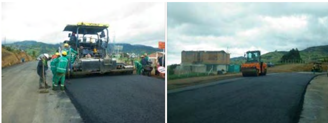
Figura N° 26 – Mezcla asfáltica – Extensión y compactación de mezcla asfáltica tipo MDS-1, para capa de rodadura.
