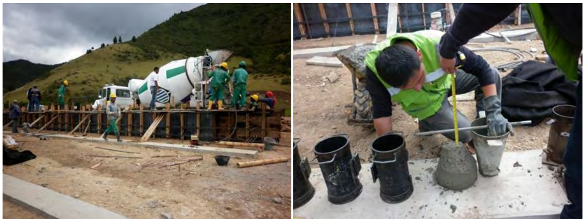
Figura N° 31 – Mezcla de concreto – Fundición de vigas principales de puente Río Pasto, ensayo de asentamiento y moldes para toma de muestras de cilindros de concreto.
