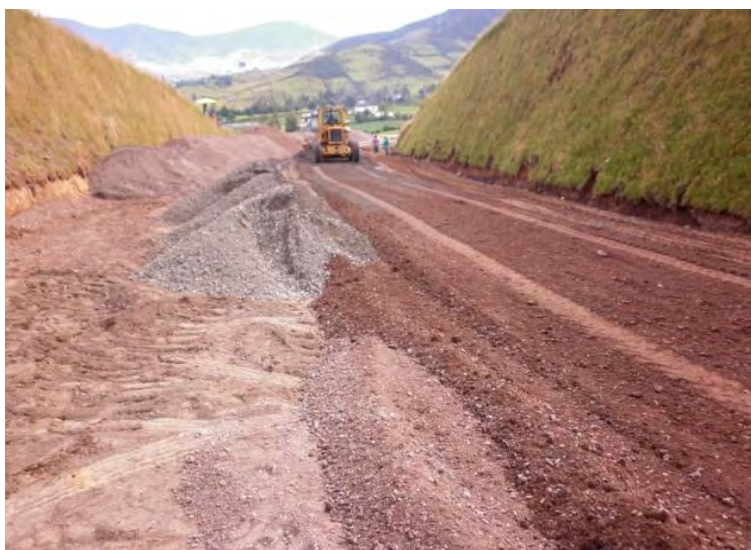
Figura N° 22 – Base granular corregida – Escarificación de capa de base granular, mezcla de material húmedo con material seco
