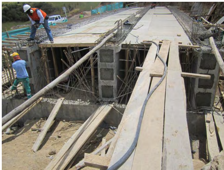
Figura N° 42 – Puente cujacal – Armado de refuerzo New Jersey y Vigas Riostras
