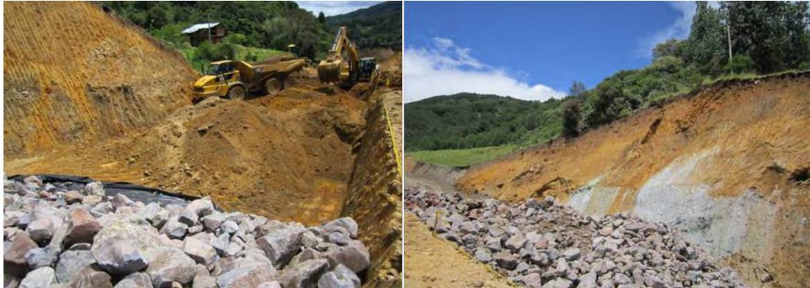
Figura N° 14 – Pedraplén – Preparación de superficie, extensión de geotextile, conformación de material de pedraplén.
