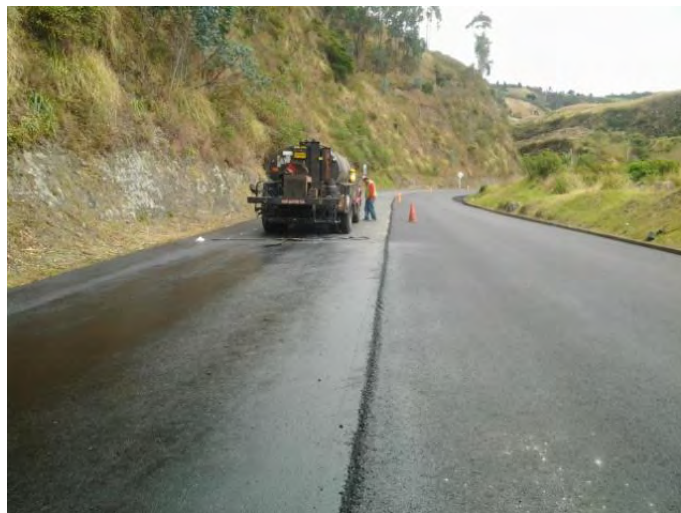
Figura N° 24 – Riego de liga – Aplicación emulsion asfáltica de rotura rápida sobre carpeta asfáltica.
