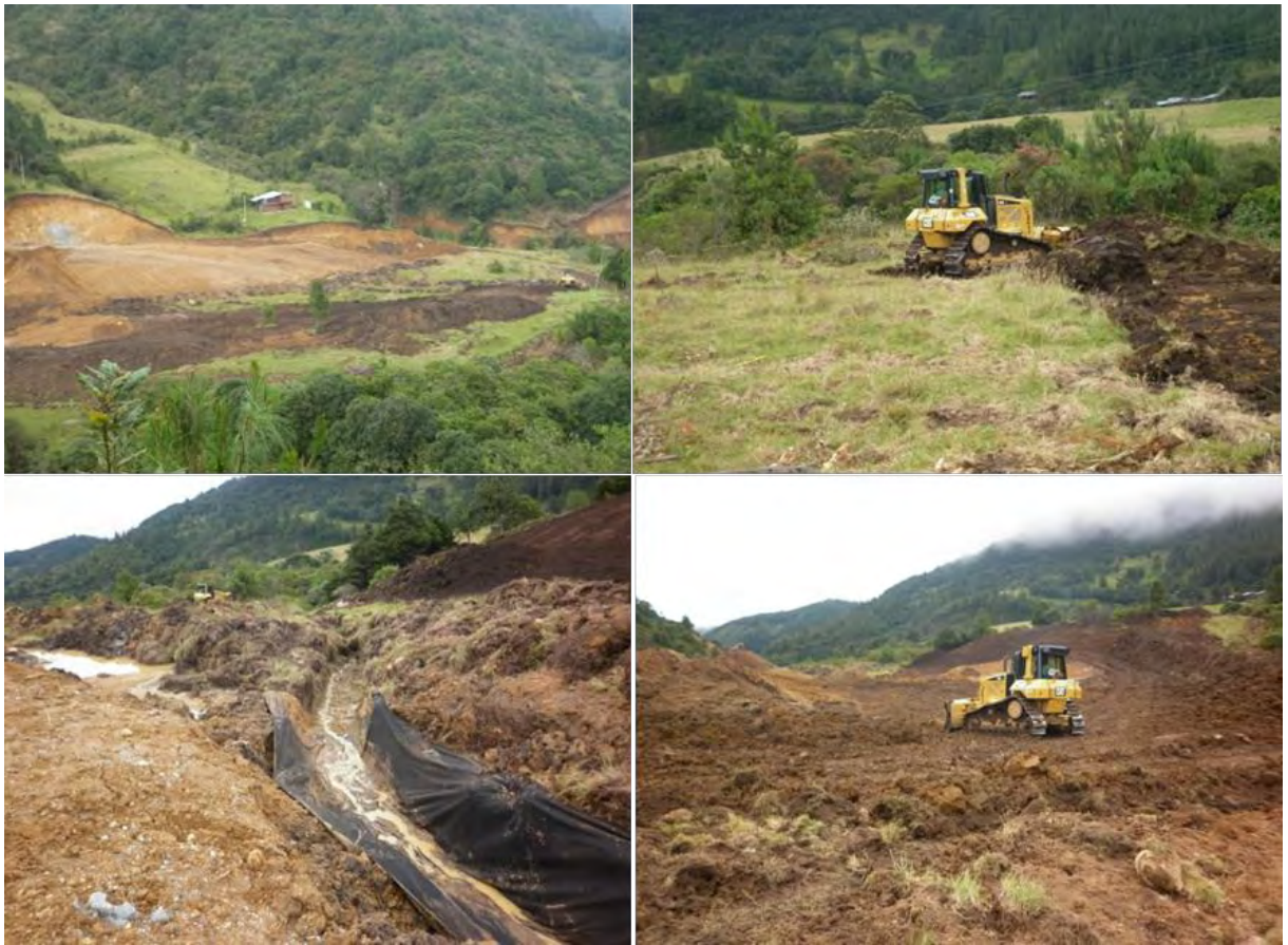
Figura N° 11 – Adecuación de SDM – Descapote, construcción de filtros y conformación de SDM con material de corte
