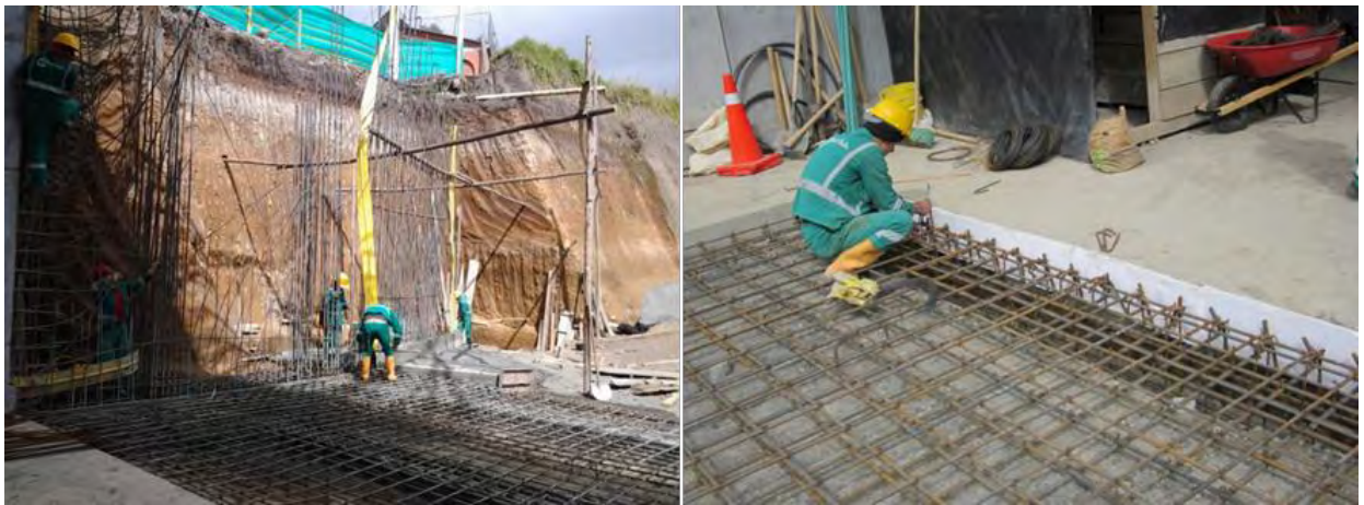
Figura N° 34 – Acero de refuerzo – Colocación y amarre de barras de acero de refuerzo para placa de aproximación inferior Box Vehicular Catambuco.
