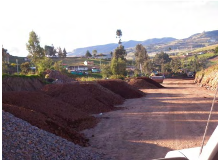
Figura N° 18 – Stock de material en obra – Material de subbase granular, acordonado y listo para ser extendido y compactado
