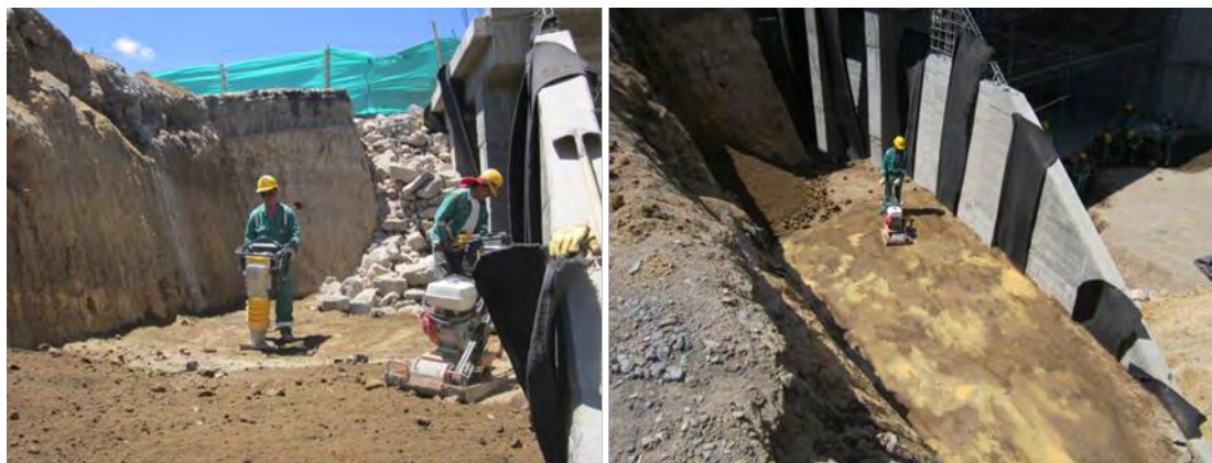
Figura N° 30 – Relleno para estructuras – Relleno y compactación de material seleccionado
