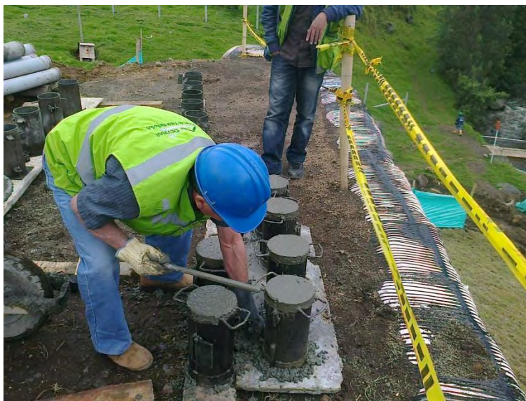
Figura N° 6 – Muestras de concreto – Cilindros de concreto para ensayos de compresion en laboratorio
