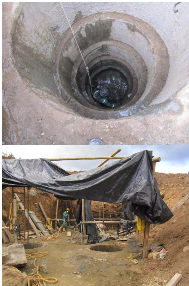
Figura N° 43 – Puente Rio Pasto – Excavación y fundición de anillos para pilotes de cimentación
