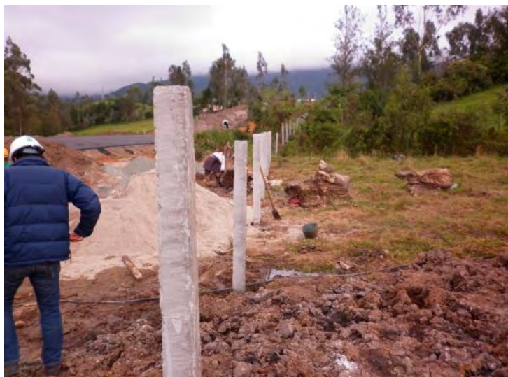
Figura N° 40 – Cercas de alambre – Instalación de postes de concreto con alambre de púas a 4 hilos.
