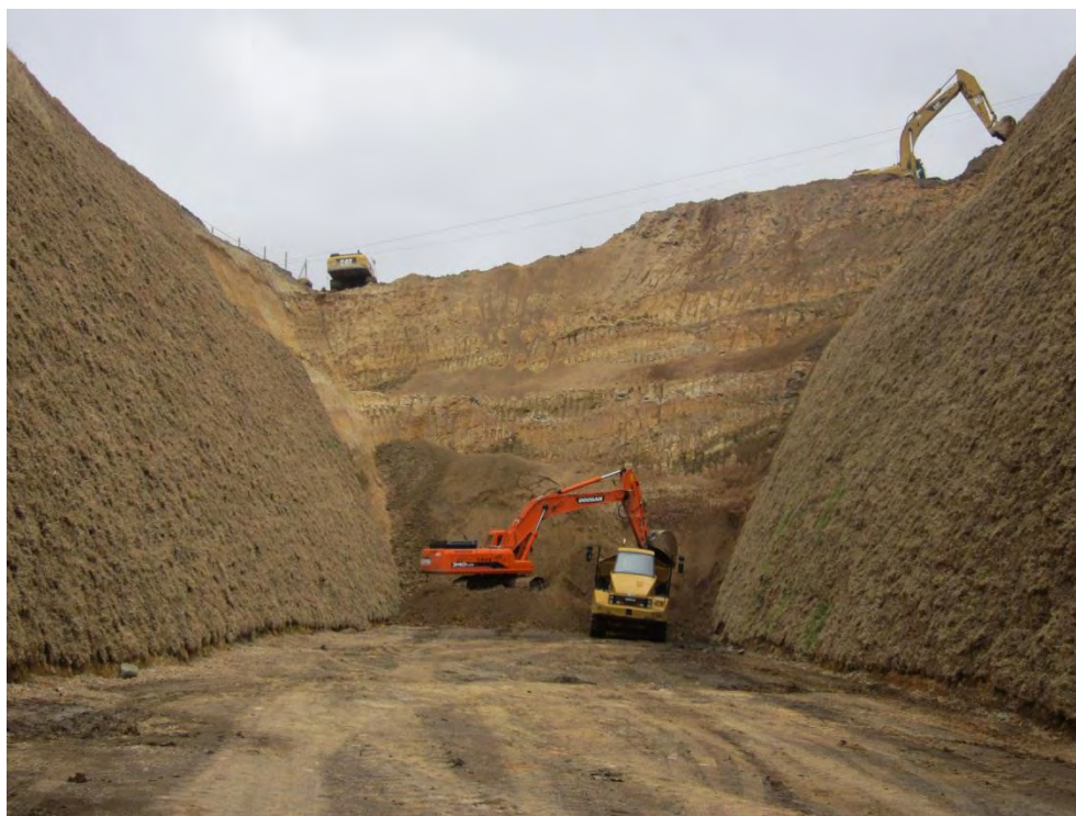
Figura N° 10 – Inspección visual de pendiente - Trayecto 5A. Sector Cujacal. PR 14+590. Explanación para la conformación de calzada. Perfilado de taludes. Conformación de terrazas
