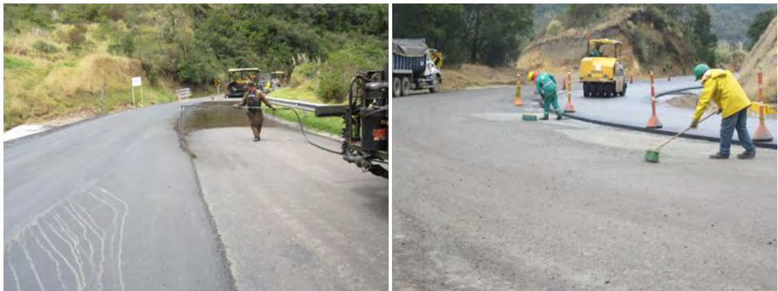
Figura N° 23 – Riego de imprimación – Limpieza de superficie de base granular y aplicación de emulsion de rotura lenta, Extensión, barrido y limpieza de capa de arena.
