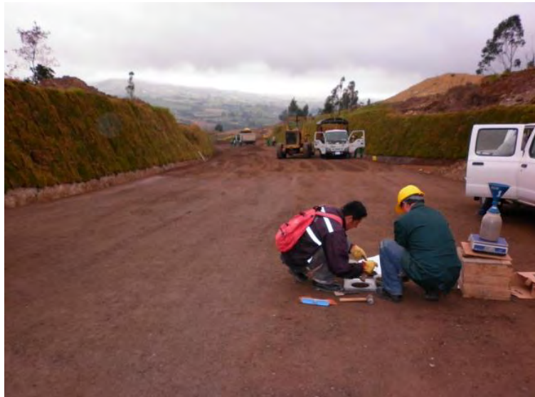
Figura N° 20 – Control de densidades - – Método de cono de arena para control de densidades en capa de base granular.
