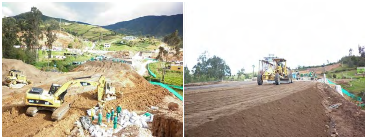
Figura N° 13 – Terraplén – Acceso a Puente Rio Pasto, conformación de núcleo de terraplén con material de corte y mejoramiento de subrasante para corona de terraplén
