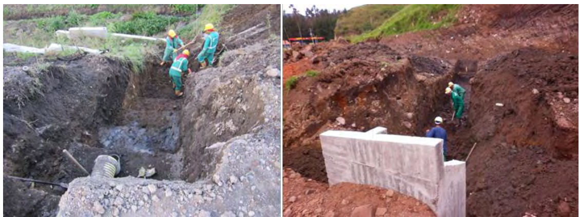
Figura N° 29 – Excavaciones varias – (Izquierda) Excavación en material común para construcción de dissipador de energía. (Derecha) Excavación en material común para construcción de alcantarilla.
