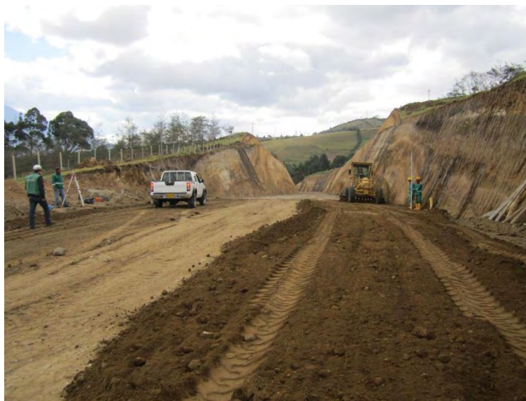
Figura N° 17 – Chequeo de niveles de subrasante – Comisión topográfica realizando chequeo de niveles de subrasante
