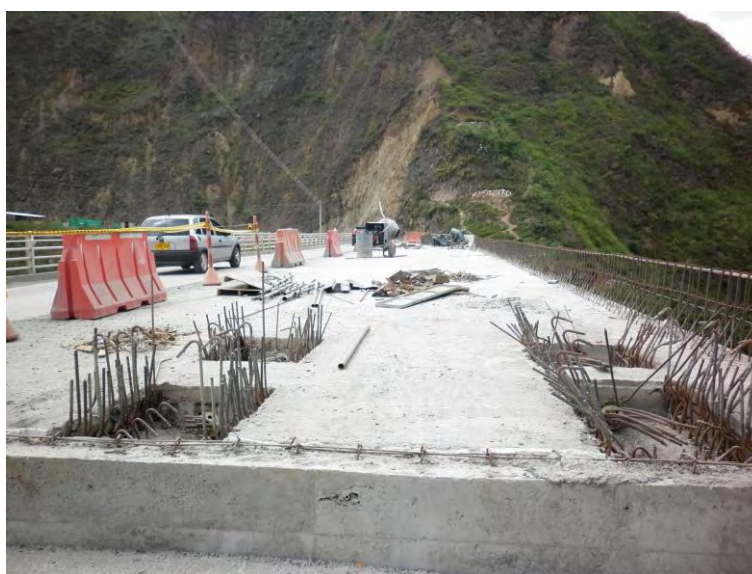
Figura N° 44 – Puente rio guaitara – Segunda etapa de tensionamiento de vigas principales
