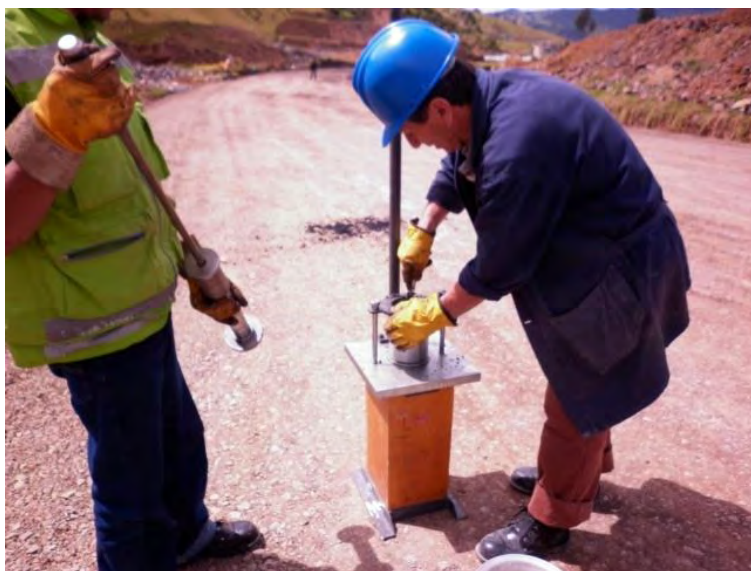
Figura N° 27 – Briquetas de asfalto – Elaboración de briquetas de asfalto en obra
