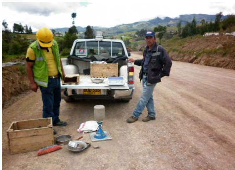
Figura N° 19 – Control de densidades – Método de cono de arena para control de densidades en capa de subbase granular.
