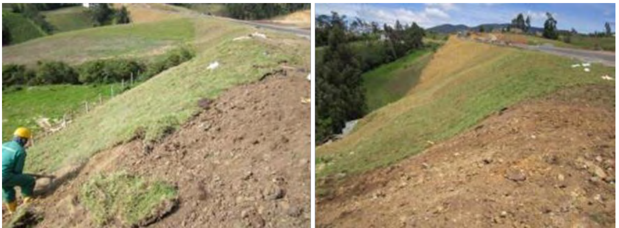
Figura N° 39 – Empradización – Instalación de bloques de césped en terraplén y franja lateral.
