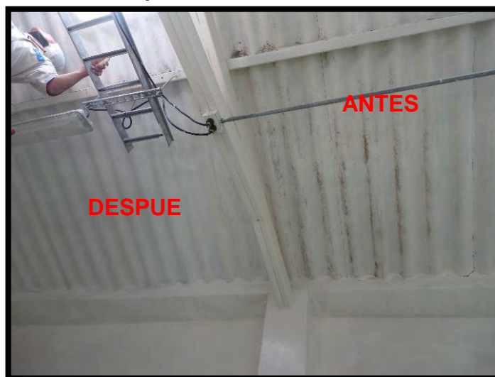
Imagen 7. Adecuaciones de pintura en techo de área de cocidos
