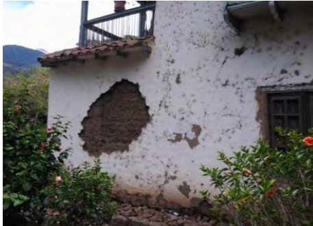
Figura 49// Fotografía del costando norte de la hacienda San Antonio. Fuente: Elaboración propia
