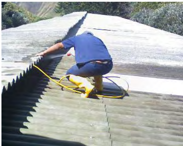
Figura 32. Lavado del techo del galpón.
