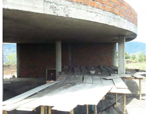
Imagen 68. Placa maciza cubierta de la ludoteca
