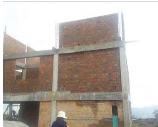
Imagen 100. Vista general muro en ladrillo
