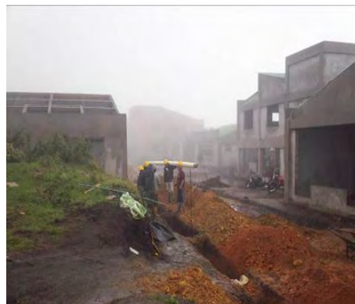
Imagen 120. Instalación tubería sanitaria de 6"
