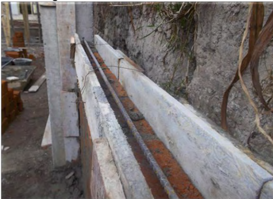
Imagen 47. Formateado de laterales para vigas de confinamiento de muros
