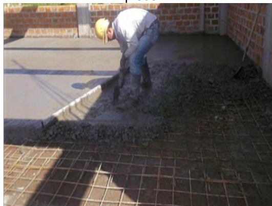
Imagen 66. Extendido de concreto en fundición pisos
