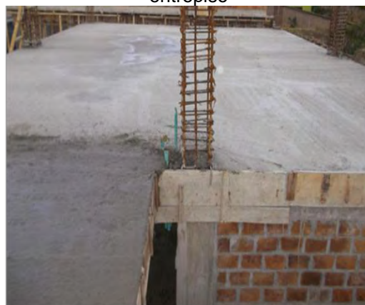
Imagen 52. Vista general concreto en losa de entrepiso
