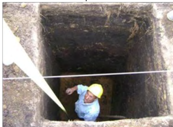
Imagen 24. Relleno con recebo compactado en zapata
