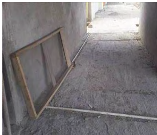
Imagen 110. Instalación red de ¾” en baños
