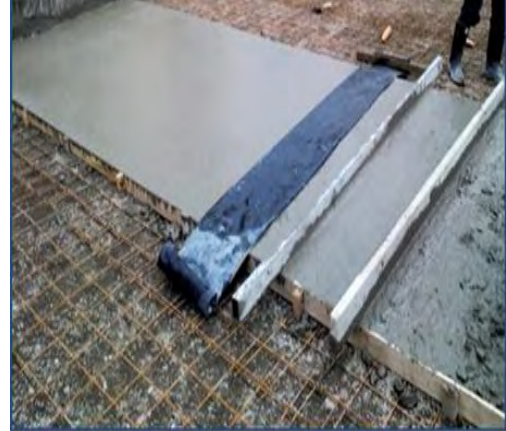
Imagen 72. Proceso de terminado con lona
