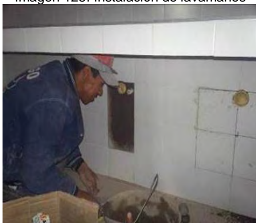
Imagen 125. Instalación de lavamanos
