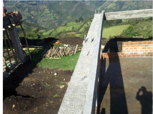
Imagen 60. Vista viga cinta terminada
