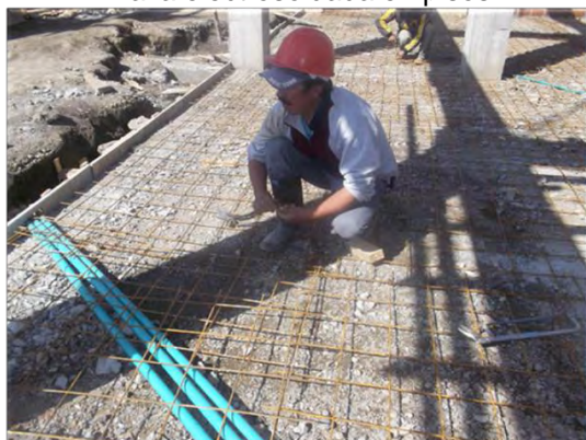
Imagen 65. Instalación de tubería conduit y malla electrosoldada en pisos
