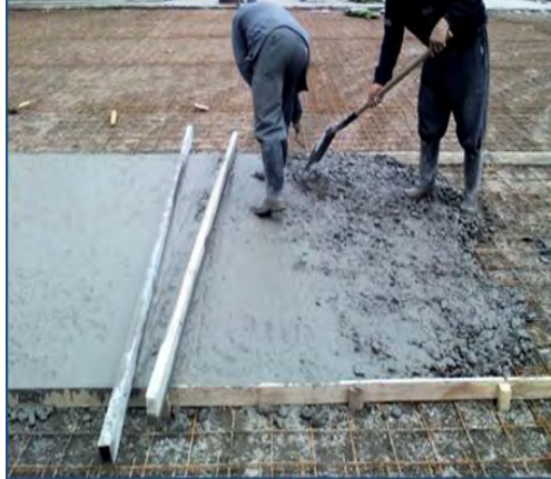
Imagen 71. Extendido y nivelación del concreto
