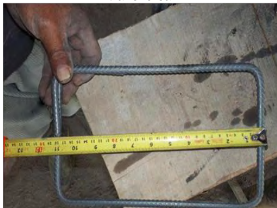
Imagen 87. Verificación de medidas refuerzo transversal
