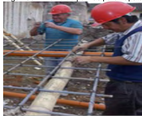
Imagen 86. Amarre de parillas para zapatas
