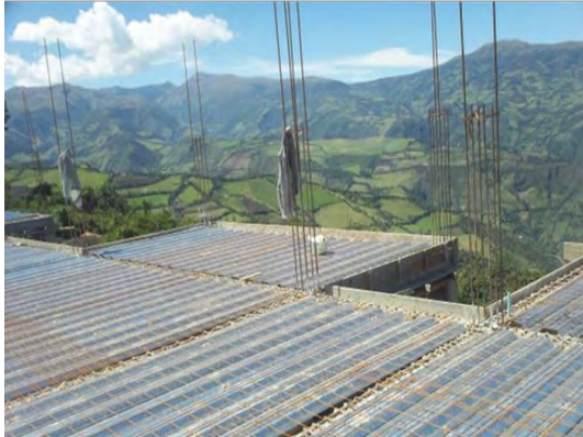
Imagen 55. Amarre y anclaje de malla electrosoldada sobre lámina de metaldeck
