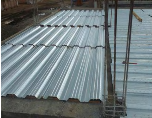
Imagen 53. Extendido de láminas de metaldeck calibre 22
