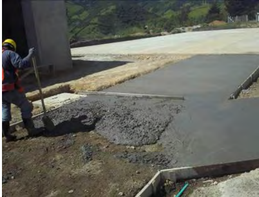
Imagen 75. Vaciado y extendido del concreto
