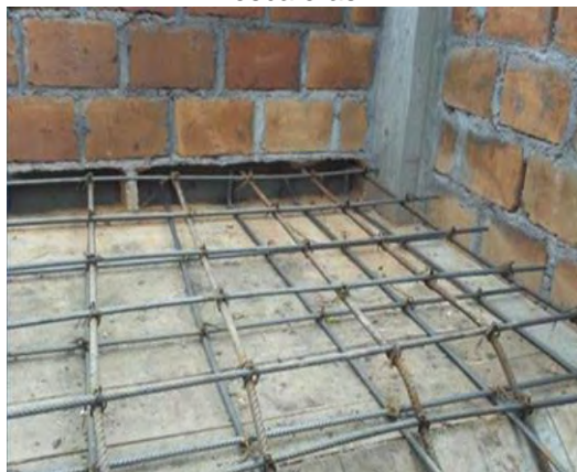
Imagen 95. Distribución de hierro para escaleras
