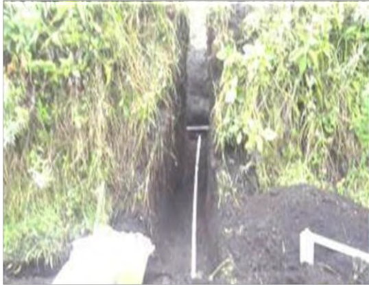
Imagen 15. Excavación para acometida de acueducto
