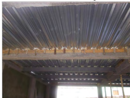
Imagen 50. Taponamiento de espacios que deja la lámina metaldeck sobre vigas aéreas
