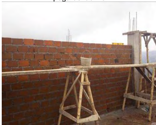
Imagen 99. Utilización de nylon y nivel para pega de ladrillo
