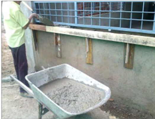
Imagen 79. Vaciado de concreto para alfajías
