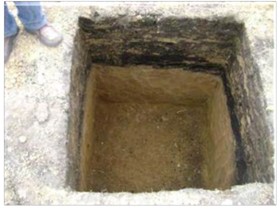
Imagen 10. Vista general excavación de zapata finalizada
