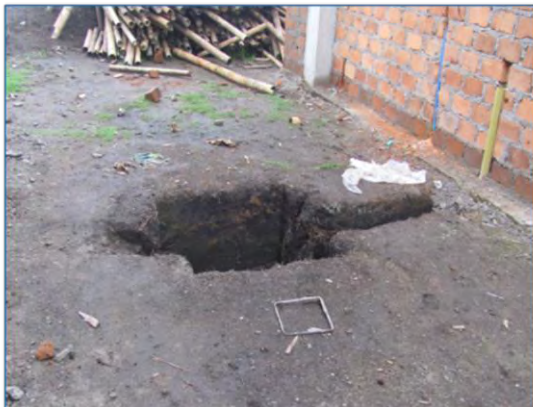
Imagen 17. Excavación para cajillas de inspección sanitaria
