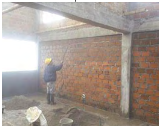
Imagen 101. Humedecimiento de la superficie a repellar
