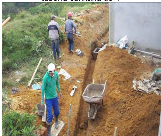
Imagen 119. Excavación para ubicación de tubería sanitaria de 4"
