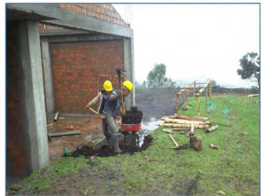
Imagen 18. Excavación para cajillas de inspección sanitaria
