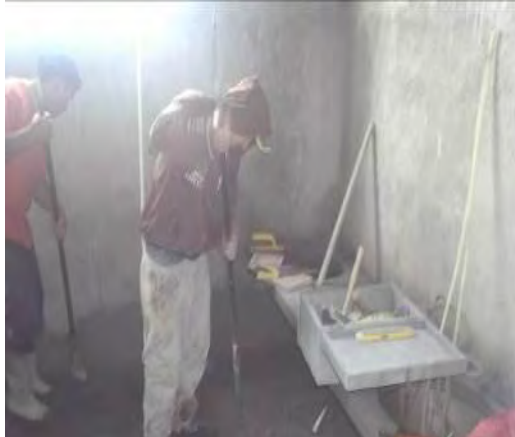
Imagen 107. Instalación red de ½” en baños
