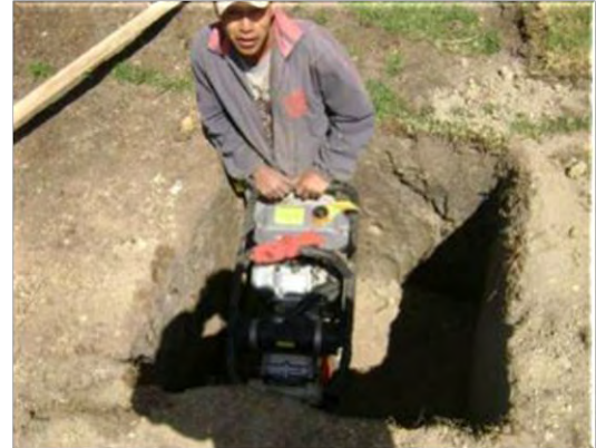
Imagen 22. Compactación de material con saltarín
