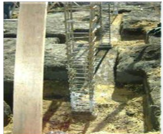
Imagen 12. Vista general de excavación para viga de cimentación
