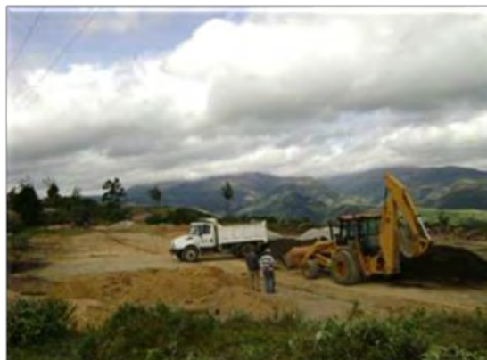
Imagen 20. Desalojo de material sobrante y escombros
