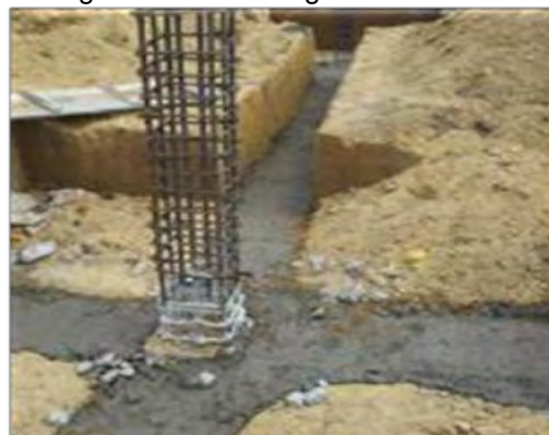
Imagen 26. Solado viga de cimentación
