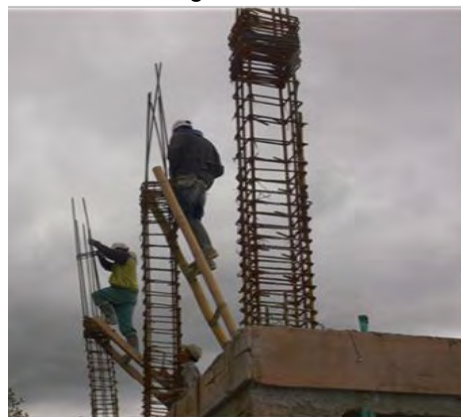
Imagen 96. Amarre de estribos en columnas del segundo nivel
