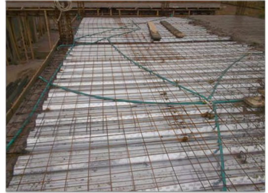
Imagen 56. Instalación de malla electrosoldada y tubería conduit sobre placa metaldeck
