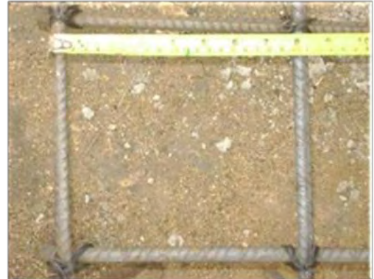
Imagen 28. Elaboración de parrilla de zapatas
