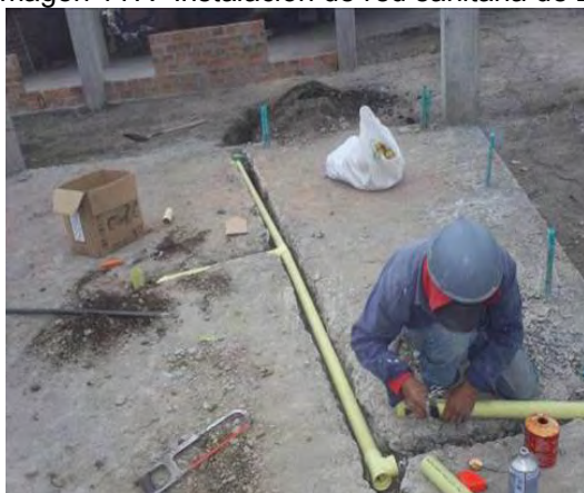
Imagen 117. Instalación de red sanitaria de 2"
