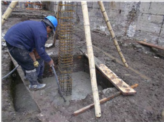
Imagen 33. Extendido y vibrado de mezcla de concreto sobre la zapata
