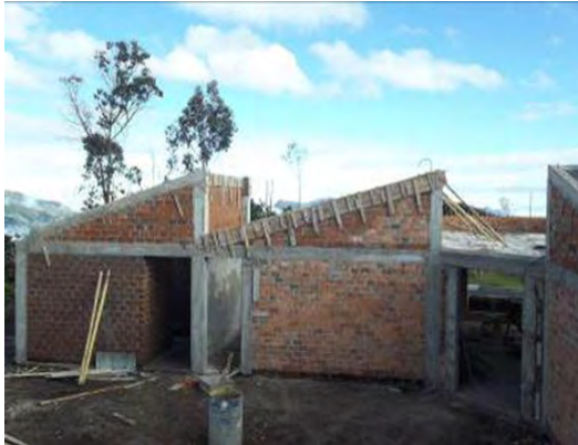
Imagen 59. Encofrado viga cinta
