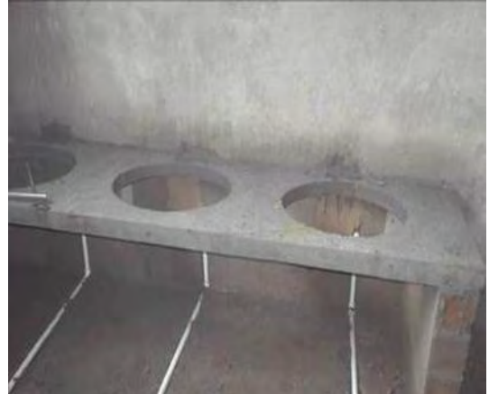
Imagen 108. Instalación red de ½” en lavamanos
