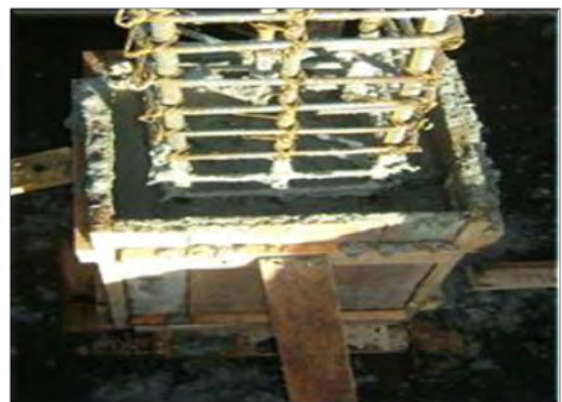
Imagen 32. Fundición de pedestales
