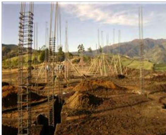
Imagen 11. Excavación para viga de cimentación
