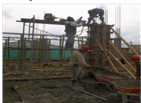
Imagen 42. Fundición de columnas
