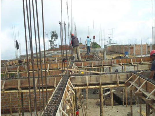
Imagen 45. Formateado de vigas aéreas
