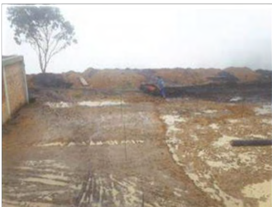
Imagen 13. Excavación para polideportivo
