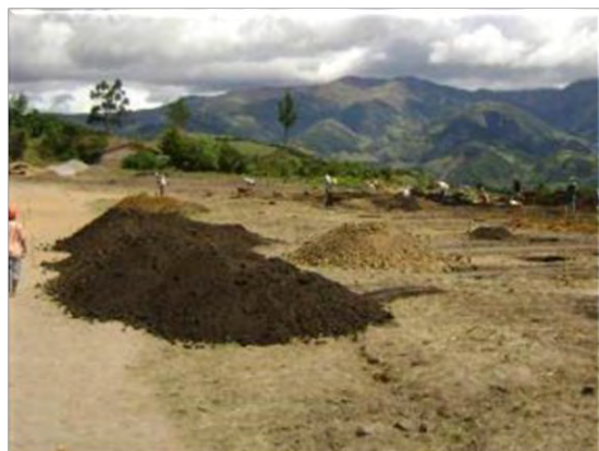
Imagen 19. Apilamiento de material sobrante y escombros
