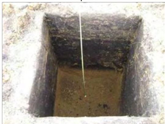
Imagen 23. Relleno con recebo compactado en zapata
