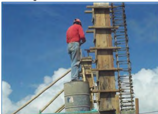
Imagen 41. Encofrado de columnas
