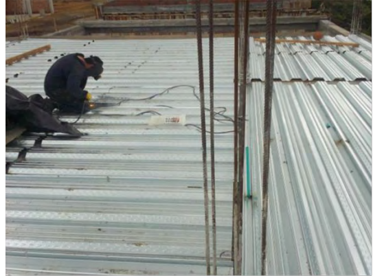
Imagen 54. Soldadura de transmisores de cortante para placa metaldeck
