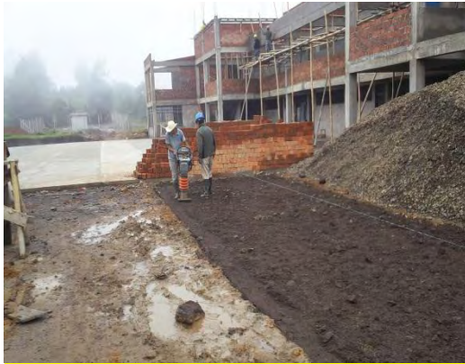
Imagen 73. Extendido y compactación de base en recebo
