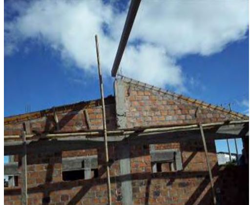
Imagen 94. Disposición de hierro para refuerzo longitudinal y transversal de vigas cinta
