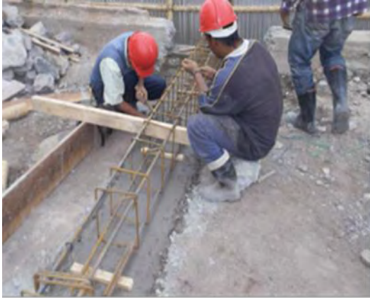
Imagen 89. Disposición de hierro para vigas de cimentación
