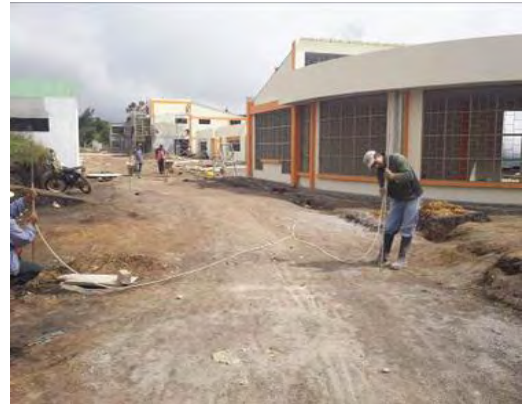
Imagen 74. Nivelación y formateado de andenes
