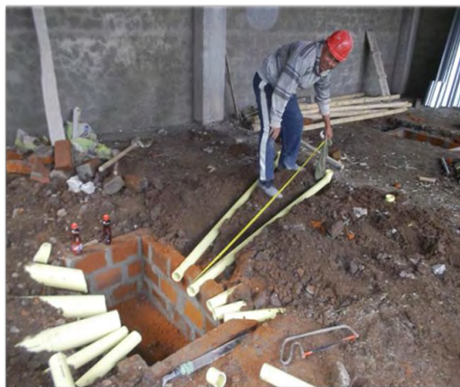
Imagen 115. Detalle de caja de inspección en batería sanitaria
