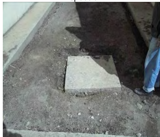
Imagen 116. Colocación de tapa en caja de inspección
