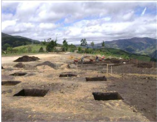
Imagen 9. Excavación para zapatas bloque de primaria
