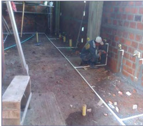
Imagen 113. Instalación Llave de paso de ½” en baterías sanitarias
