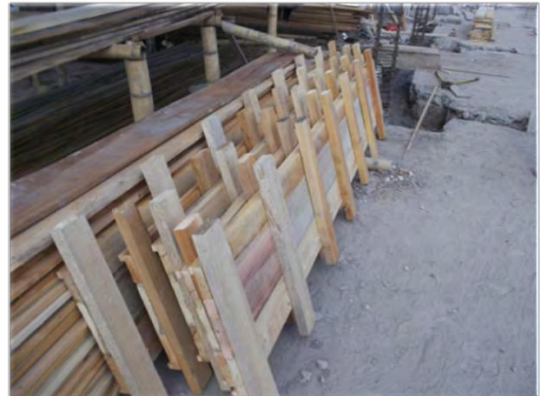
Imagen 40. Tableros para columnas
