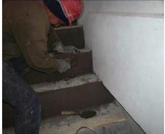
Imagen 104. Repello de escalera
