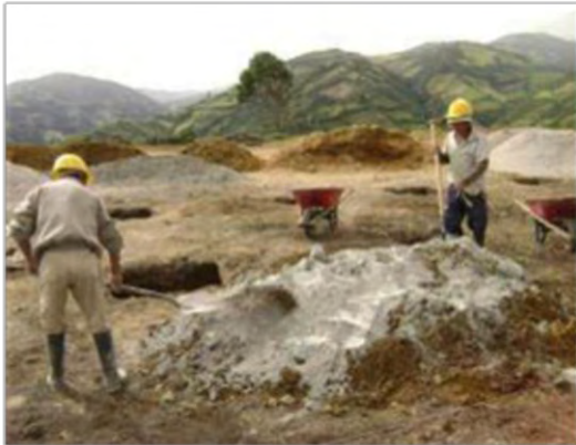
Imagen 21. Mezcla de recebo cemento manualmente
