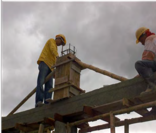
Imagen 43. Encofrado de columnas
