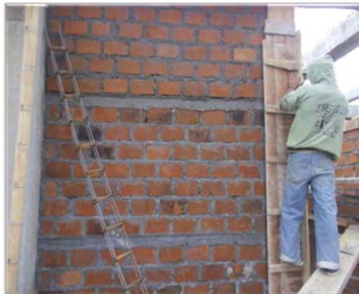
Imagen 93. Castillos para columnetas de muros para puertas
