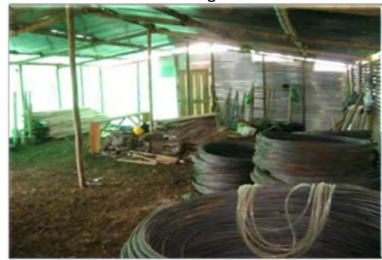
Imagen 6 Campamento parte interna área de bodega
