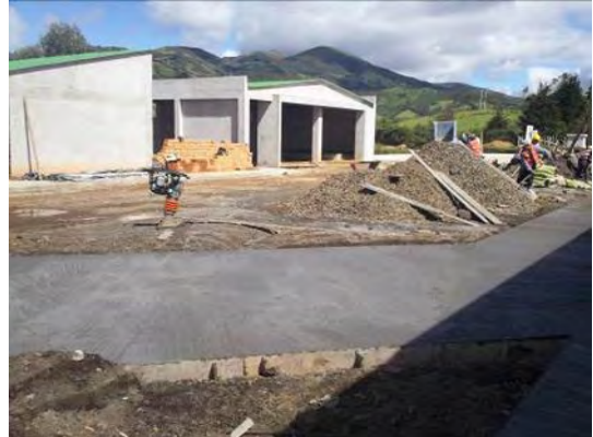
Imagen 76. Vista general de andén
