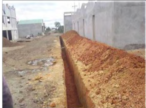
Imagen 16. Excavación manual para red sanitaria
