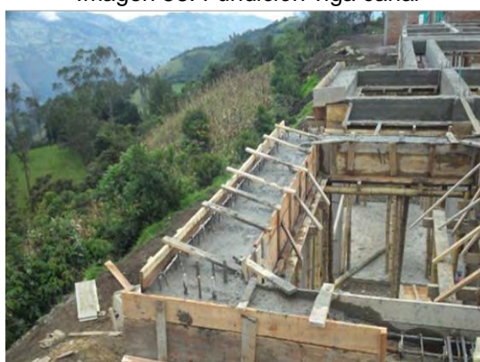
Imagen 58. Fundición viga canal
