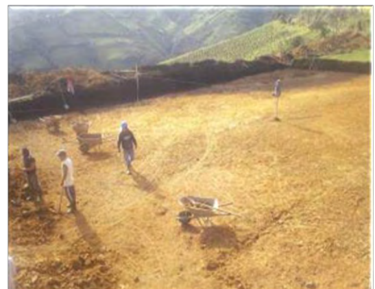
Imagen 14. Vista general excavación para polideportivo
