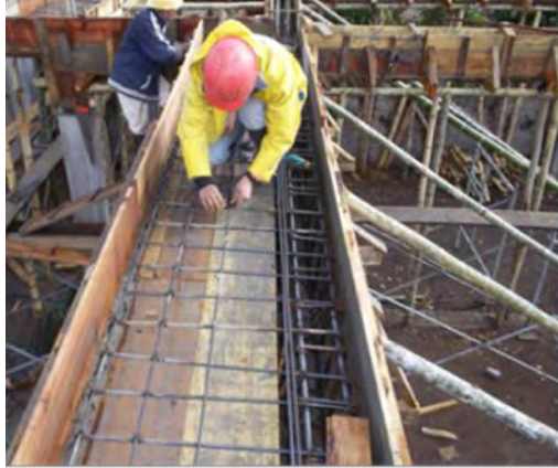
Imagen 91. Amarre de hierro longitudinal y transversal de vigas canal
