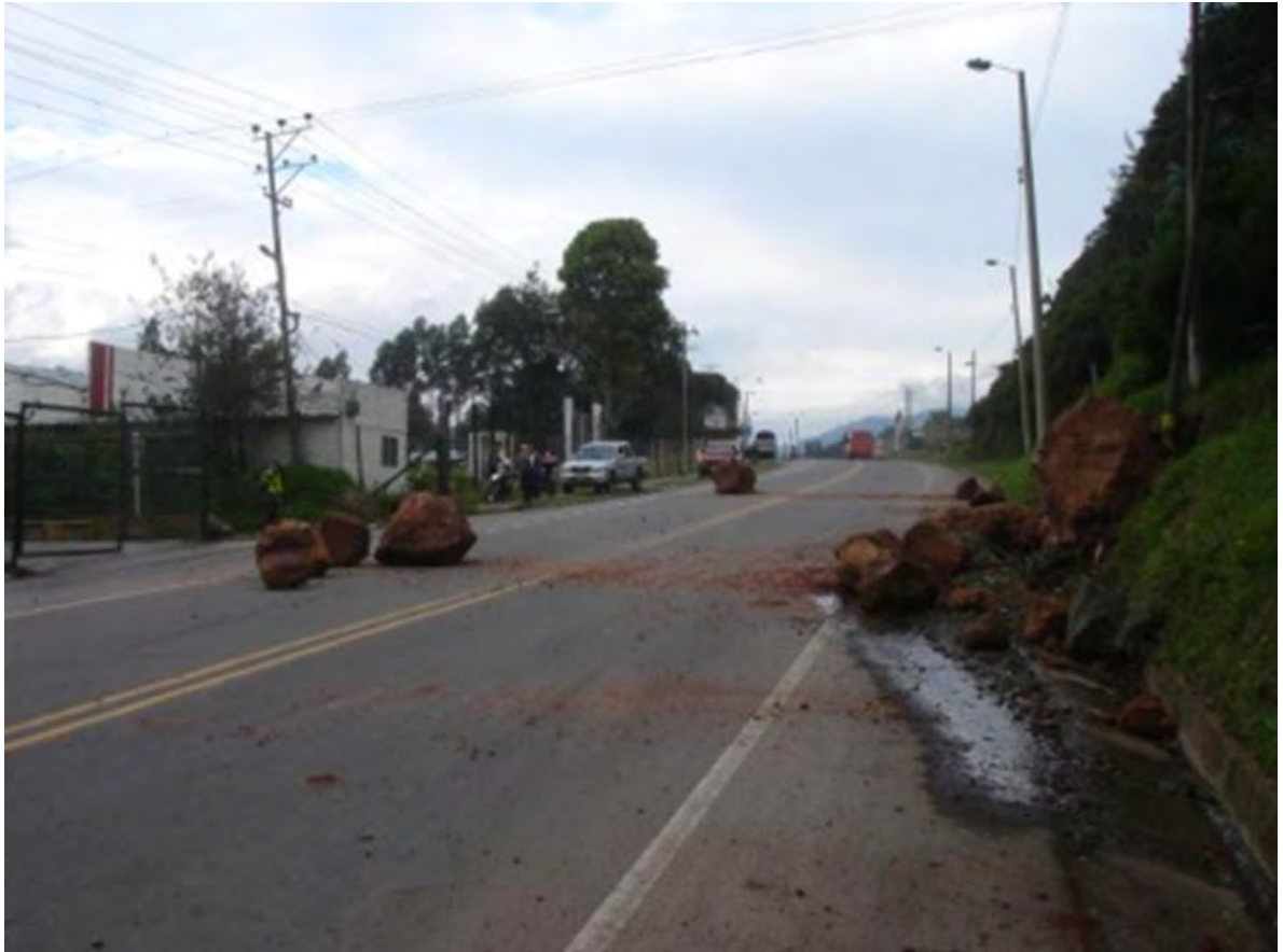
Figura 6. Desprendimiento talud, cantera Toro Alto Mina 2, barrio Briceño, San Juan de Pasto año 2009.
