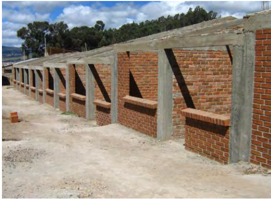
Foto 1. Construcción de viviendas
