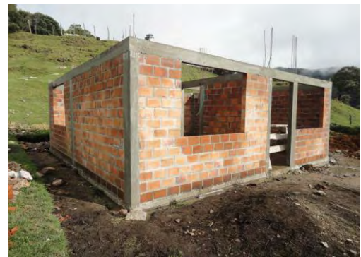
Imagen N° 12: Vigas aéreas terminadas
