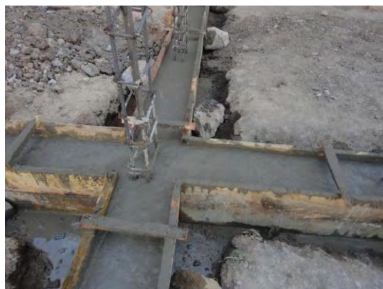
Imagen N° 9: Detalle fundición Vigas de cimentación
