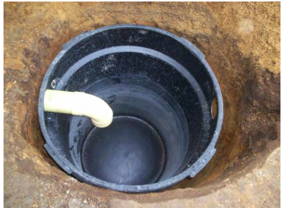
IMAGEN N° 49: POZOS DE INSPECCION
