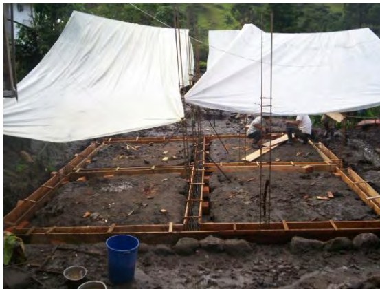
Imagen N° 7: Formaleta Vigas de cimentación
