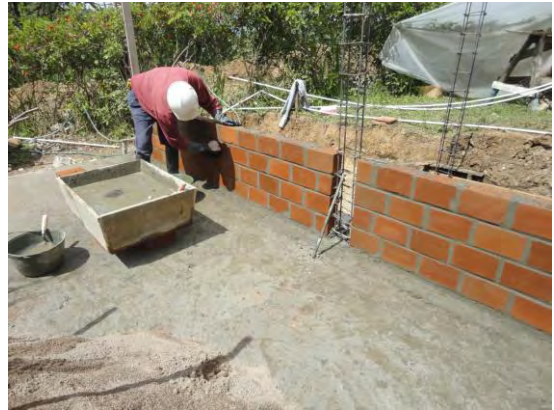
Imagen N° 21: Pega de ladrillo
