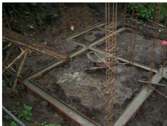
Imagen N° 8: Fundición Vigas de cimentación
