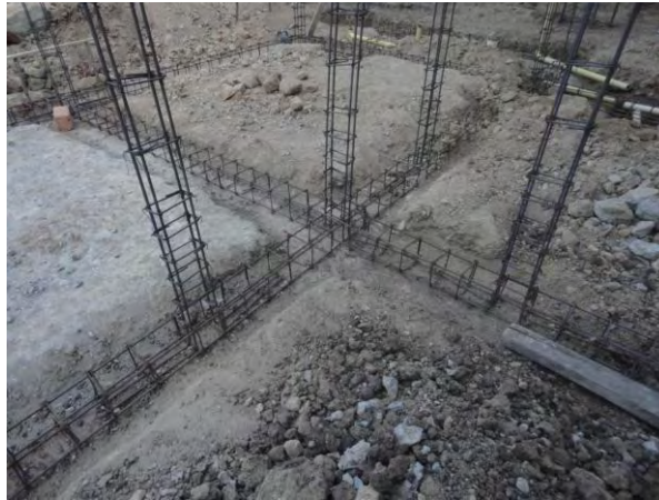
Imagen N° 5: Armado de hierro vigas y columnas
