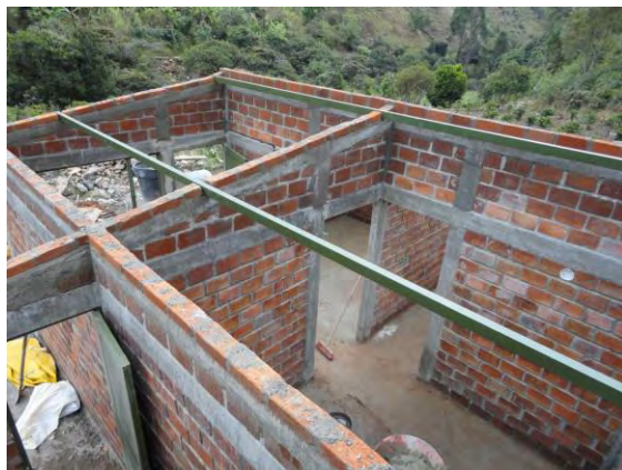
IMAGEN N° 44: INSTALACION DE PERFILES METALICOS
