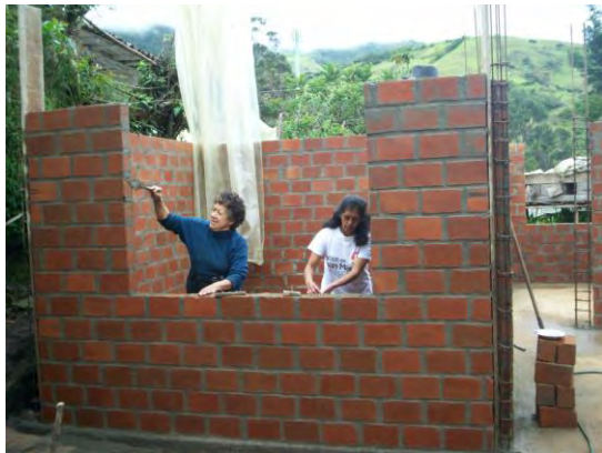
Imagen N° 24: Limpieza de ladrillo
