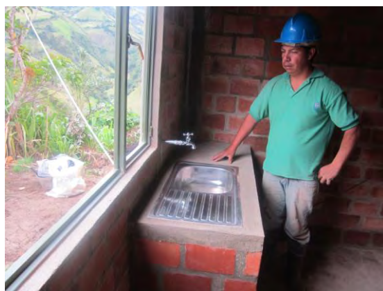
IMAGEN N° 25: MESON EN LADRILLO TERMINADO
