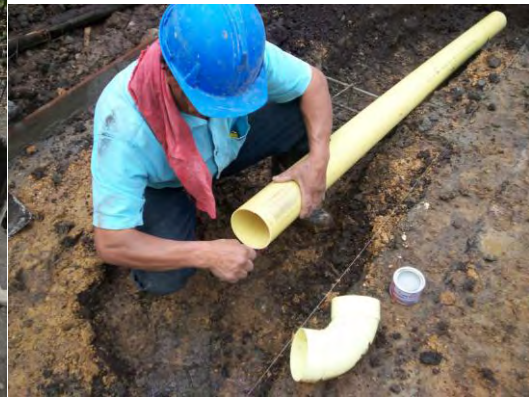
Imagen N° 32: Instalaciones tubería sanitarias
