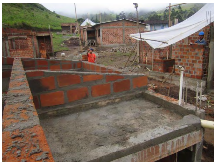
Imagen N° 20: Losa tanque de almacenamiento
