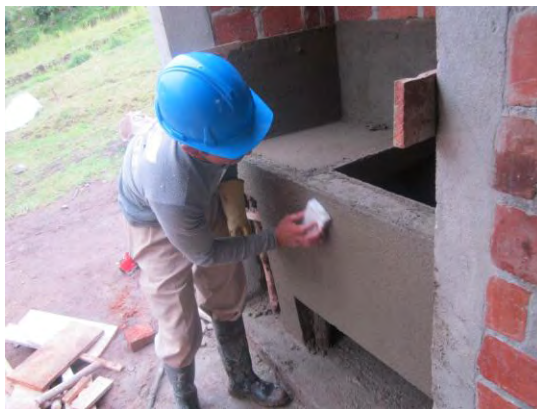
IMAGEN N° 35: LAVADERO EN MAMPOSTERIA
