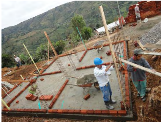
Imagen N° 22: Mampostería en ladrillo visto
