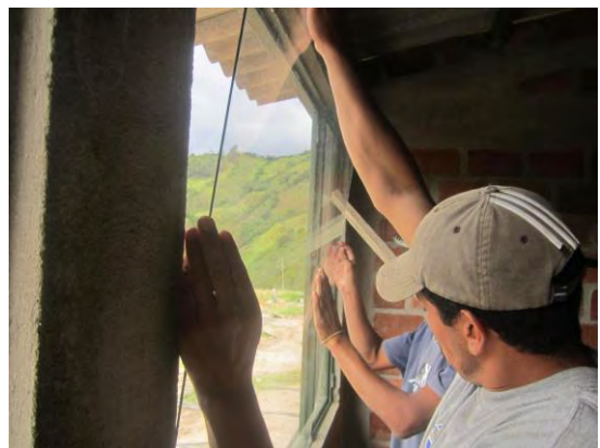
IMAGEN N° 47: INSTALACION DE VIDRIOS
