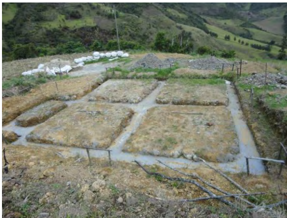
Imagen N° 3: Fundición concreto ciclopeo
