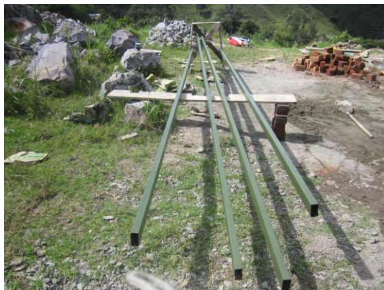
IMAGEN N° 43: PERFILES PINTADOS CON ANTICORROSIVO
