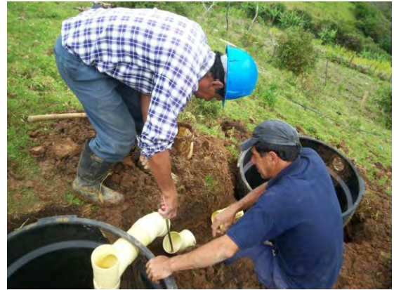
IMAGEN N° 51: INSTALACION POZO DE INSPECCION; INSTALACION TUBERIA
