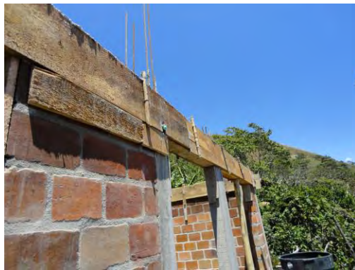
Imagen N° 10: Fundición Vigas aéreas
