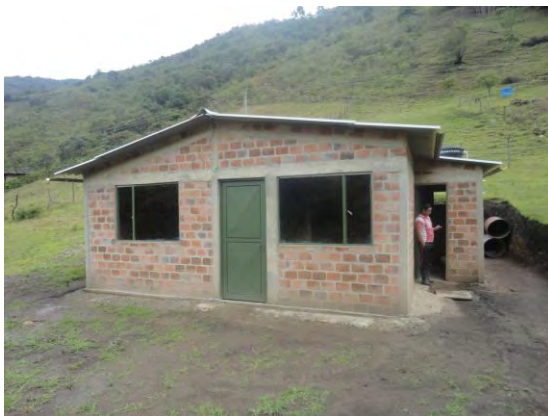
IMAGEN N° 54: VISTA FRONTAL CASA TERMINADA
