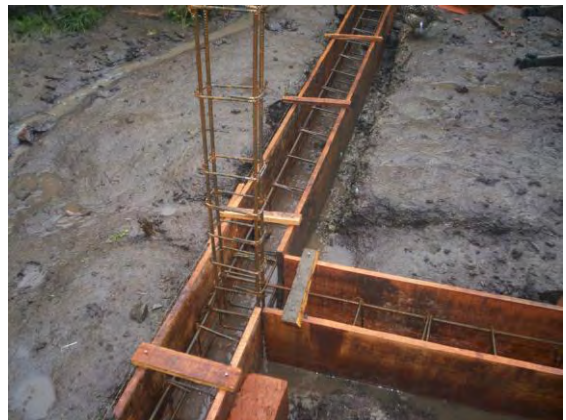
Imagen N° 6: Detalle formaleta Vigas de cimentación
