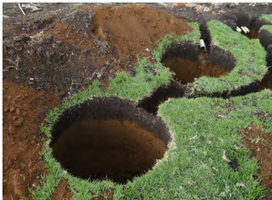
IMAGEN N° 50: EXCAVACION PARA POZO DE INSPECCION
