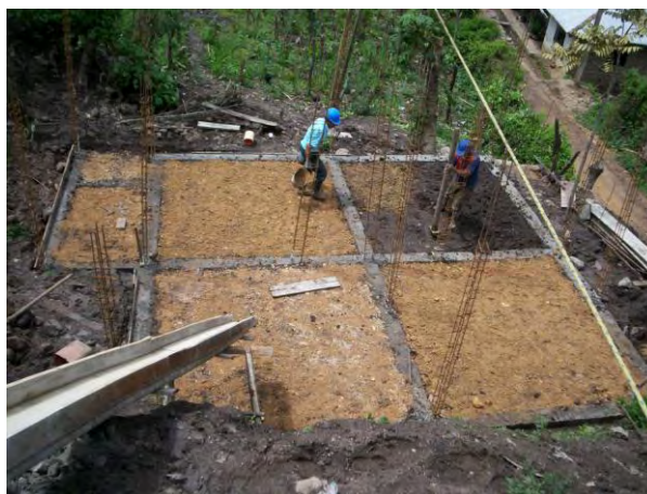
Imagen N° 4: Relleno material común
