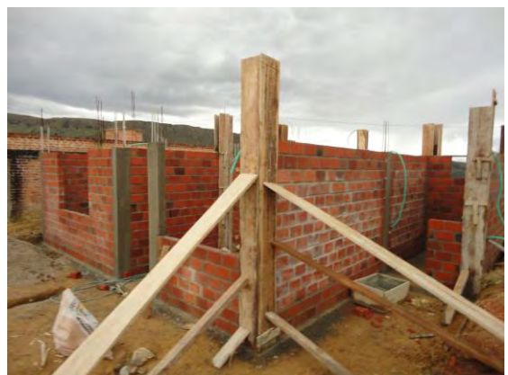
Imagen N° 16: Apuntalamiento de columnas
