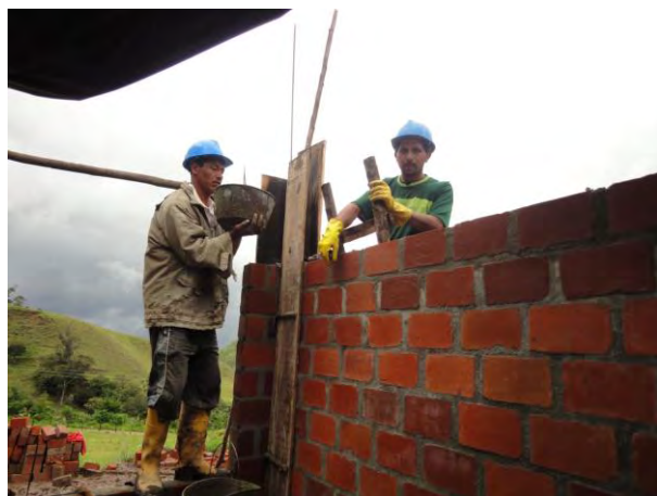
Imagen N° 19: Fundición de columnas
