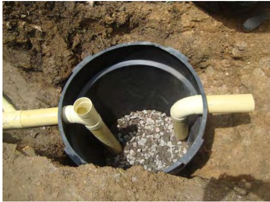
IMAGEN N° 52: INSTALACION POZO DE INSPECCION; FONDO GRAVILLA
