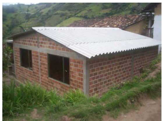
IMAGEN N° 53: FACHAD APOSTERIOR CASA TERMINADA
