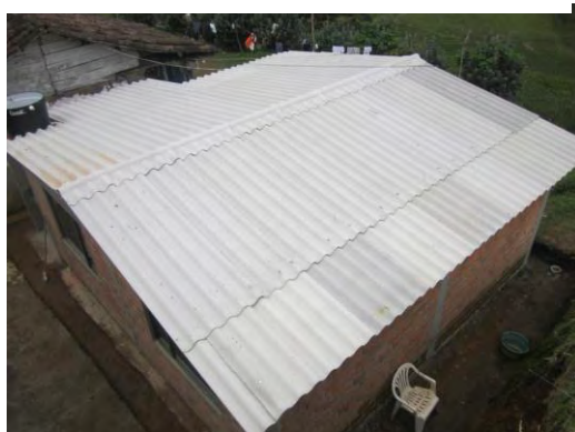
Imagen N° 31: Cubierta en teja fibrocemento
