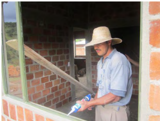
IMAGEN N° 48: INSTALACION CON SILICONA ANTIHONGOS
