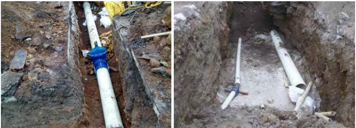
Figura 31, Instalación de tubería de 14, 12 y 4 pulgadas.
