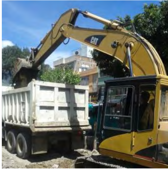
Figura 7, Retiro de material producto de la excavación
