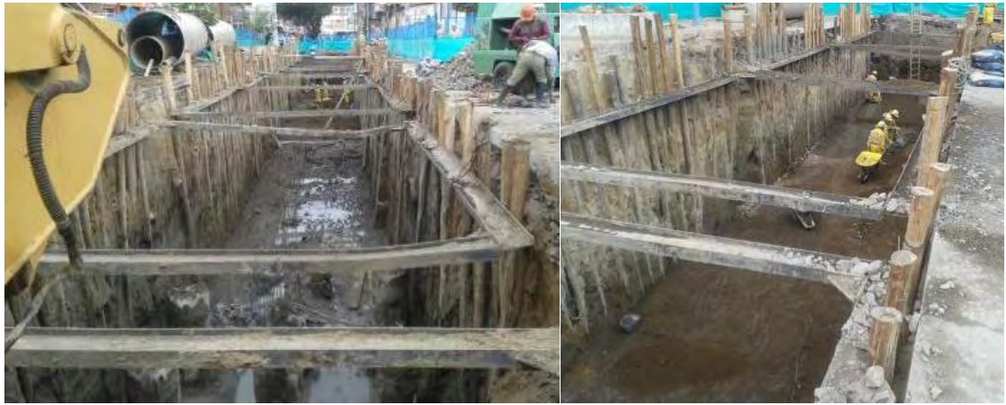
Figura 20, Entibado con marco metálico y palos rollizos en madera.
