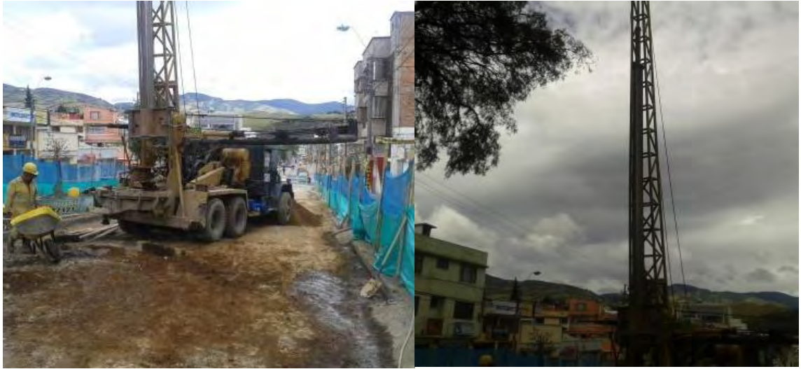
Figura 14, Perforadora piloteadora longitud máxima de excavación 30 ml.
