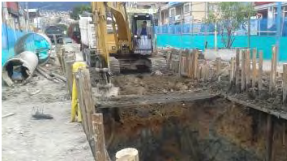
Figura 6, Excavación con retroexcavadora
