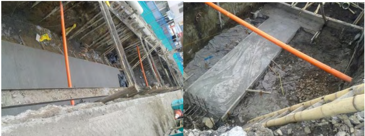
Figura 17, Losa de cimentación en concreto reforzado de 3000 psi.
