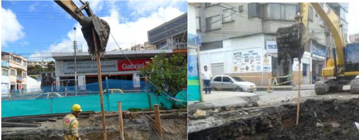
Figura 21, Hincado de palos rollizos sobre el terreno cada 60 cm.
