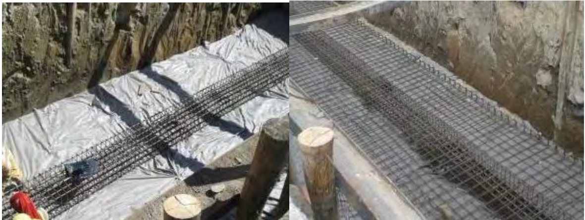
Figura 16, Estructura de acero viga y losa de cimentación.
