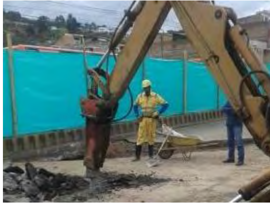
Figura 4, Demolición de pavimento asfáltico e=10cm con pajarita
