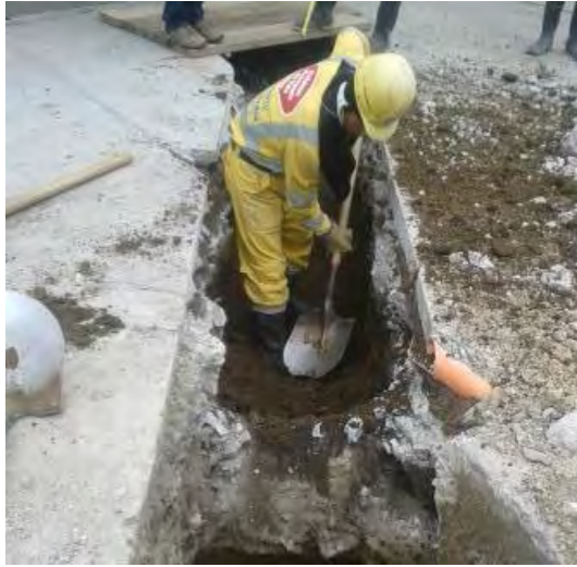
Figura 5, Excavación manual en material común H < 2\text{m}
