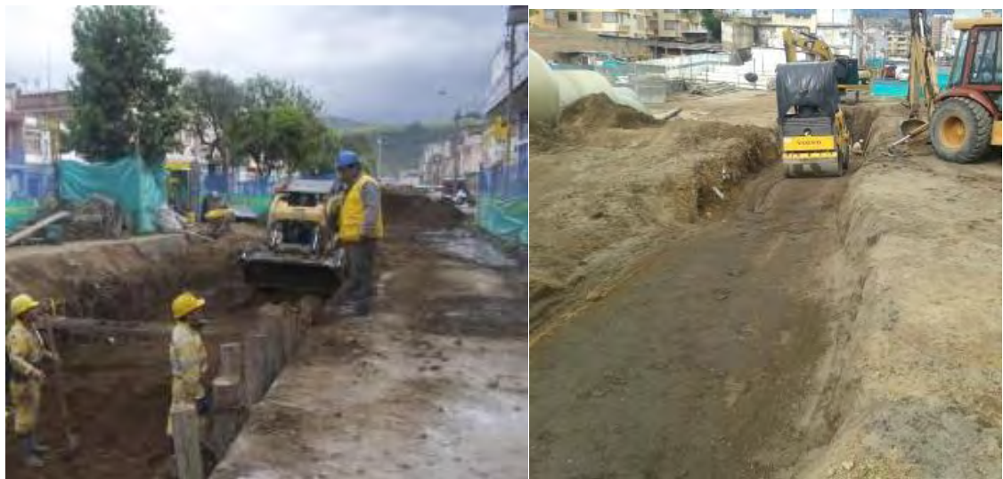
Figura 23, Extendido y compactación de recebo granular para relleno de excavaciones de gran magnitud
