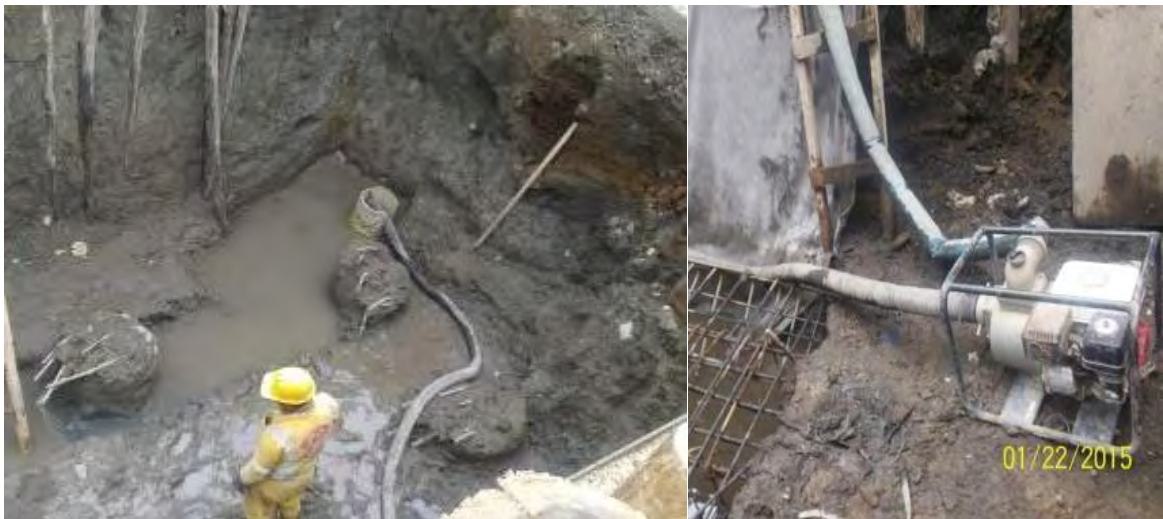
Figura 25, Bombeo de agua de nivel freático en la excavación.
