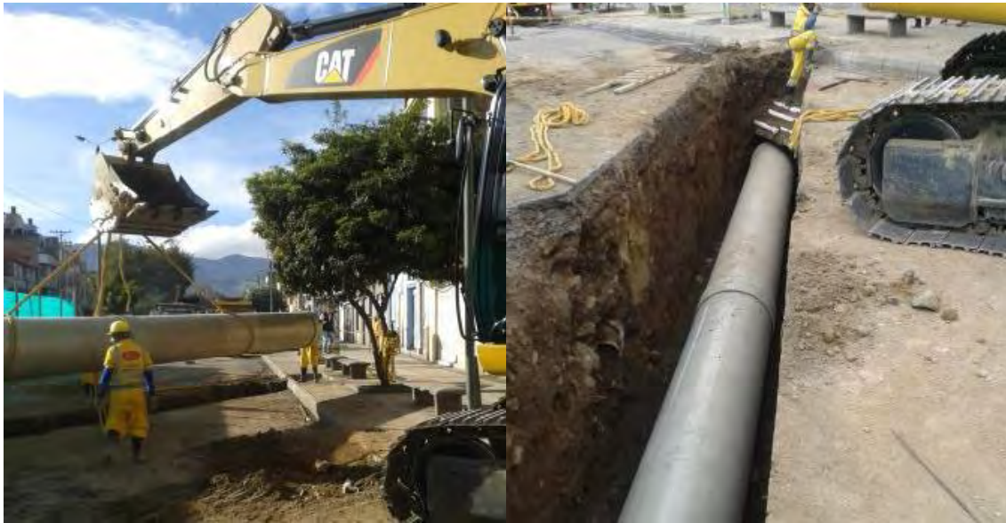
Figura 9, Instalación de tubería GRP de 800 mm.
