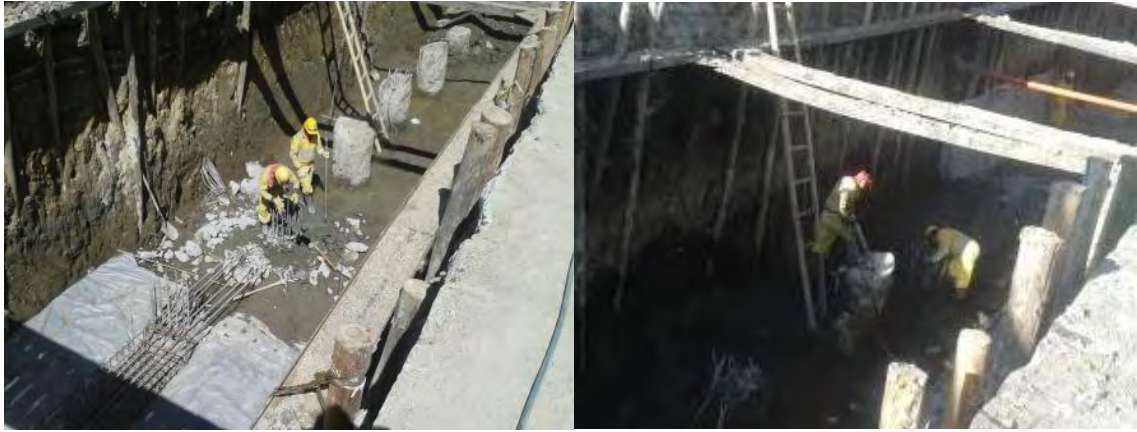
Figura 15, Demolición de pilotes de la losa de cimentación.
