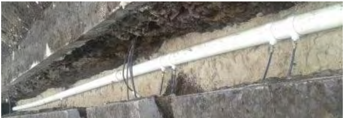
Figura 36, Instalación de acometidas domiciliarias en tubería principal de 6”.
