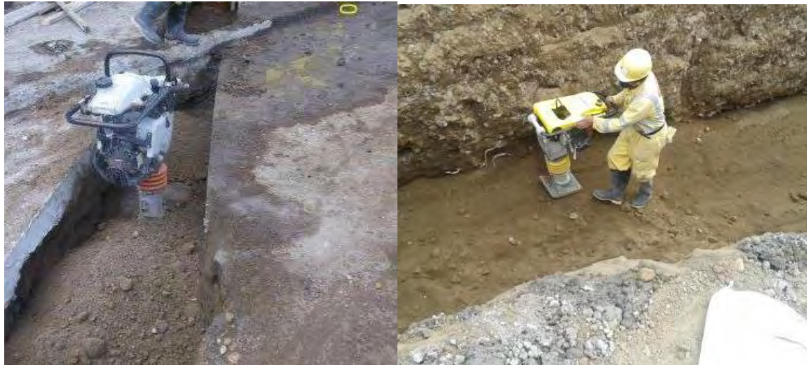
Figura 24, Relleno de excavación con recebo granular compactado con apisonador mecánico (saltarín).
