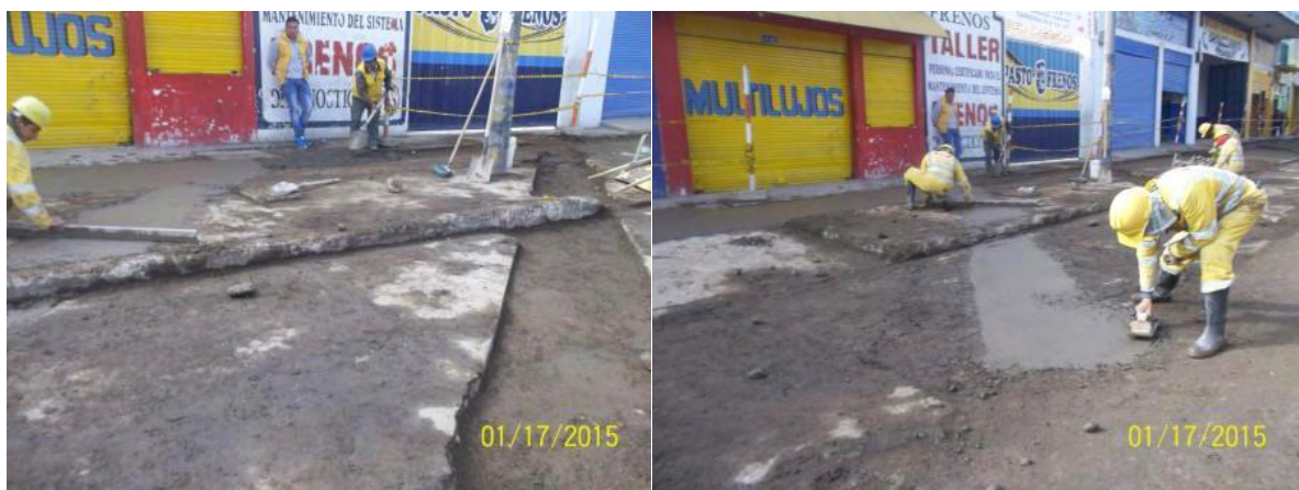
Figura 26, Reposición de la capa de rodadura de acometidas domiciliarias con recebo cemento espesor 10 cm.
