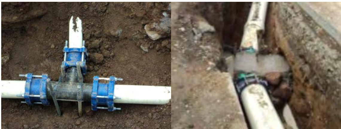
Figura 33, Atraque y fundición en concreto de accesorios en hierro dúctil.
