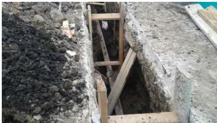
Figura 30, Tubería de acueducto existente de asbesto cemento de 4"
