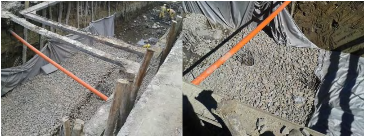
Figura 22, Instalación de geotextil no tejido.
