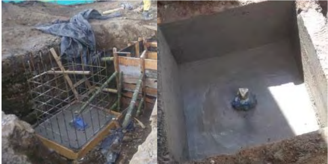
Figura 34, Acero y fundición de concreto de 3000 psi de una caja válvula.
