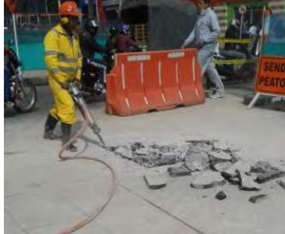
Figura 3, Demolición de placa de concreto e=20cm con compresor
