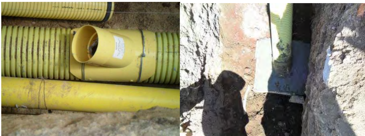
Figura 10, Instalación silla yee
