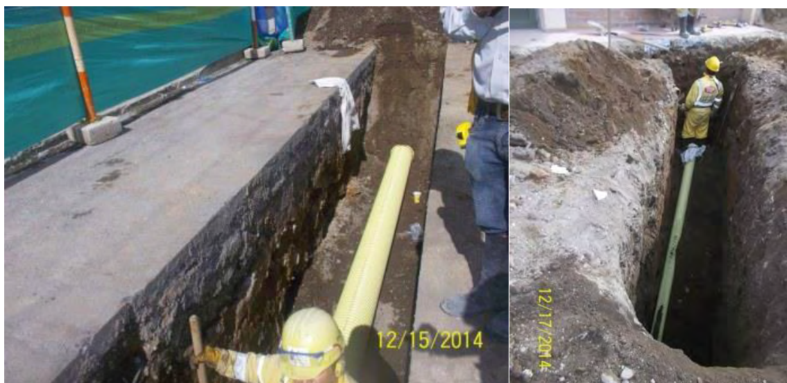
Figura 8, Instalación de tubería PVC novafort estructurada de 12” y 6”
