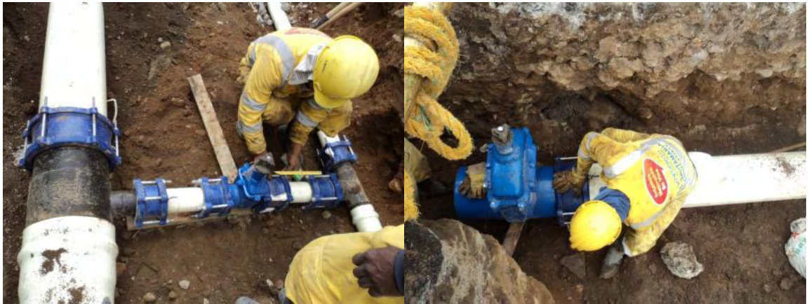
Figura 32, Instalación de válvulas y accesorios en hierro dúctil.
