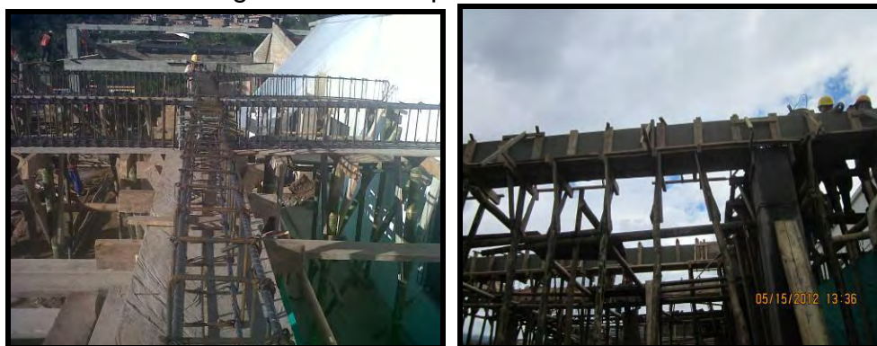
Ilustración 21 Armado de vigas aéreas bloque 8
