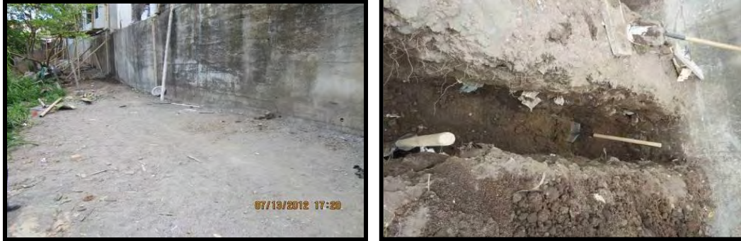
Ilustración 52. Excavación para cimientos.
