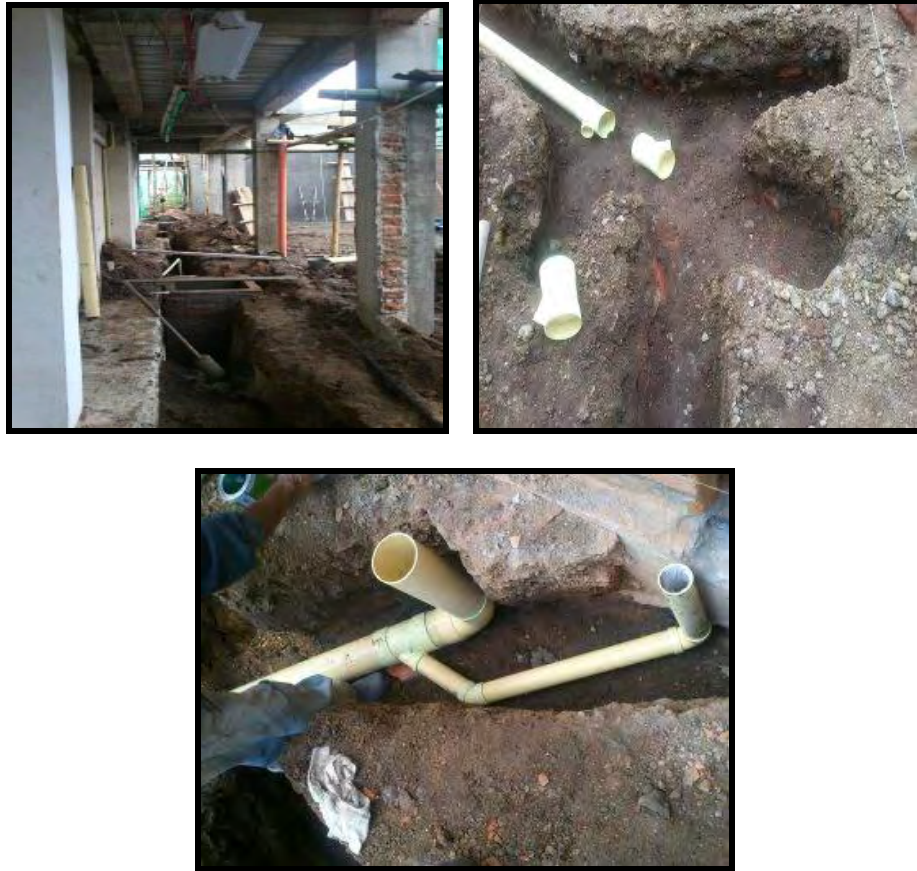
Ilustración 33. Excavación y tendido de tubería sanitaria.
