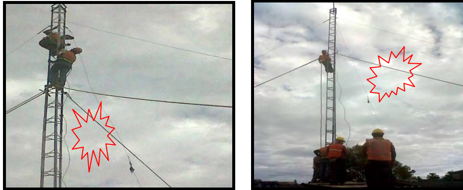
Ilustración 44. Desmante de antena
