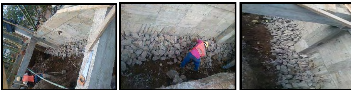
Ilustración 18. Filtro en nuevo muro perimetral bloque 8
