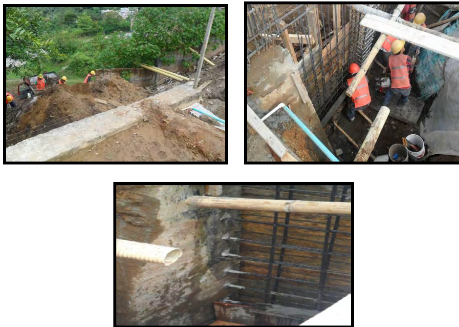
Ilustración 17. Muro antiguo y armado muro nuevo con anclajes.
