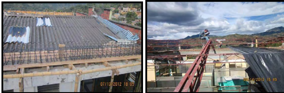
Ilustración 50. Cubierta y desmonte de teja
