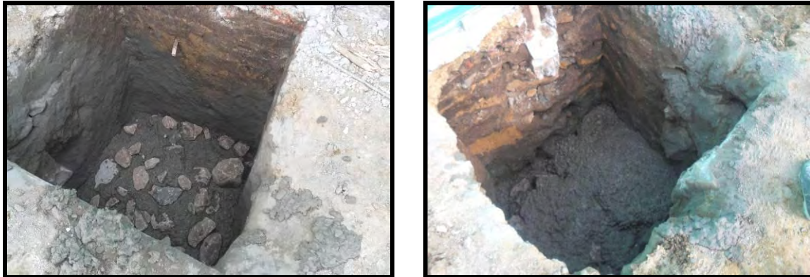
Ilustración 14. Concreto ciclópeo para zapatas.
