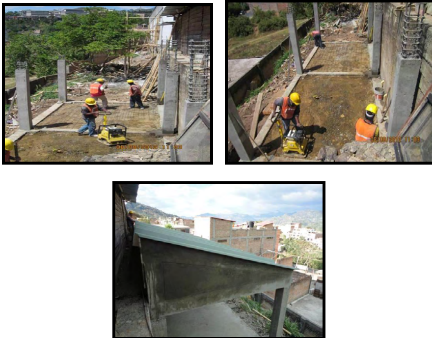
Ilustración 56. Estructura residuos sólidos y canaleta 90
