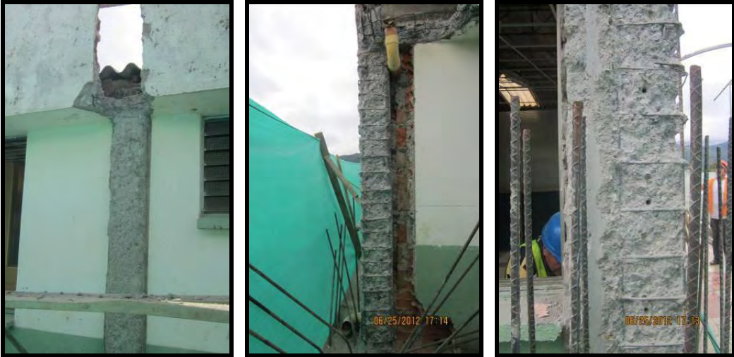
Ilustración 45. Escarificación de columnas
