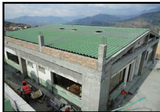
Ilustración 51 Adecuación de cubierta y estructura reforzada
