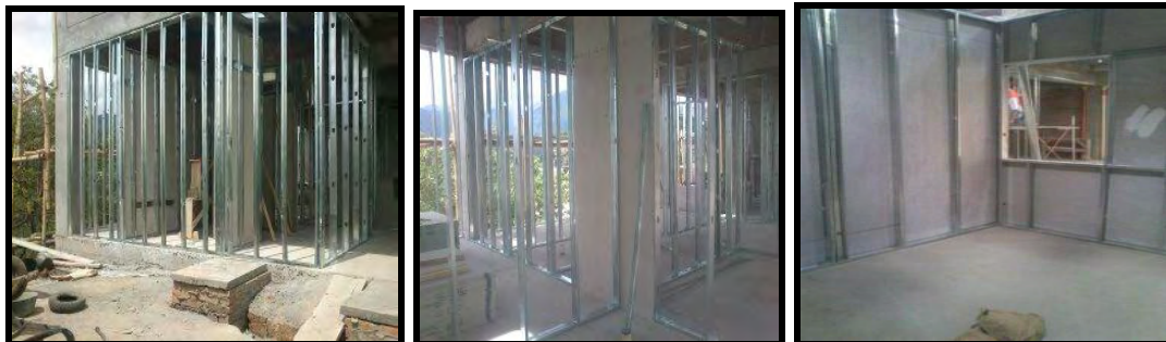
Ilustración 26 Estructura muros en superboard.
