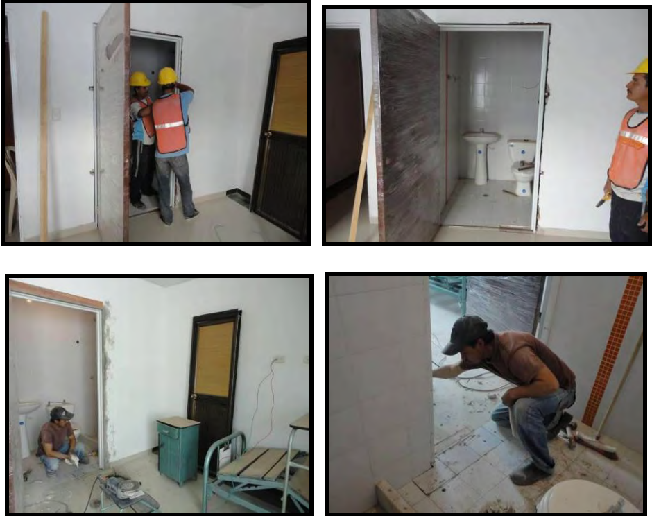
Ilustración 63. Cambio puertas zona de hospitalización
