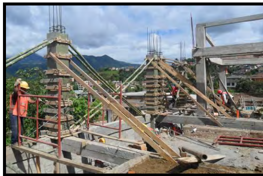
Ilustración 20. Armado de columnas bloque 8.
