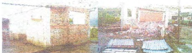
Demolición Z. implementos aseo 1
