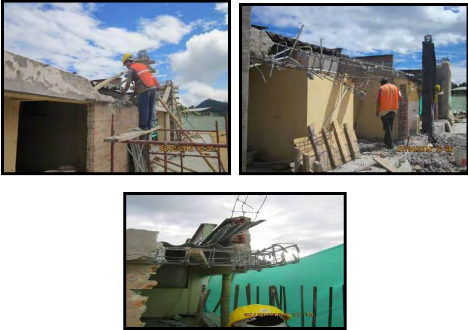
Ilustración 46. Demolición de vigas y muros existentes.
