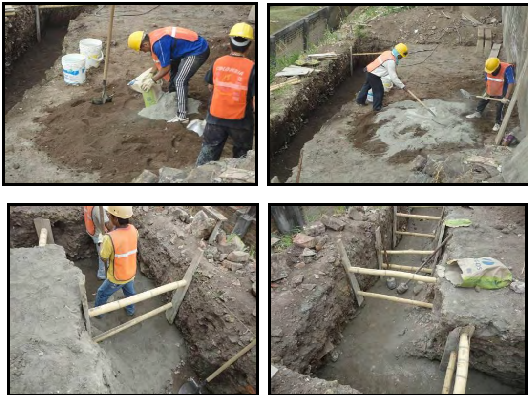
Ilustración 53. Mejoramiento de suelo
