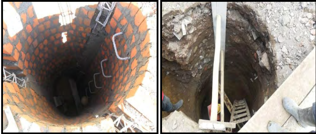
Ilustración 23 Cámara de inspección
