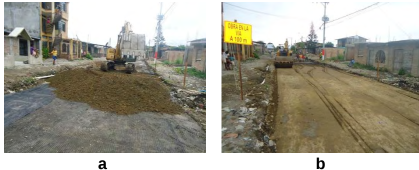
Figura 09 a, b: Material de base se esparció sobre el terreno en capas de espesor uniforme.
