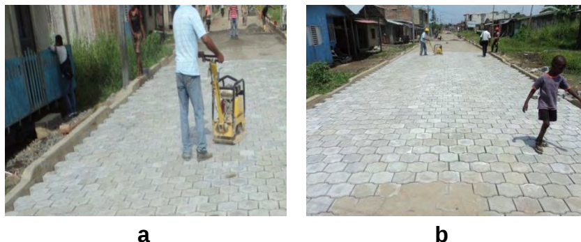
Figura 17 a, b: Proceso de compactación.
