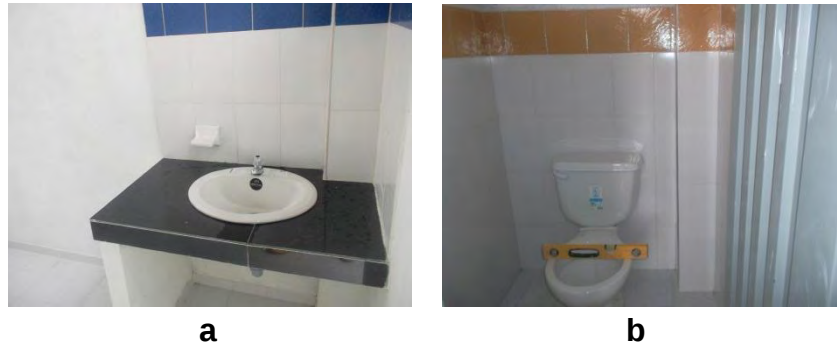
Figura 44 a, b: Instalación de aparatos sanitarios chequeando niveles.
