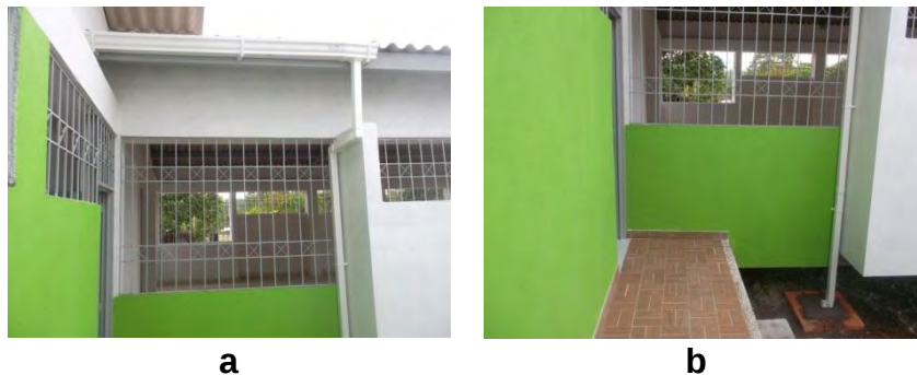
Figura 36 a, b: Instalación de canaletas en PVC.
