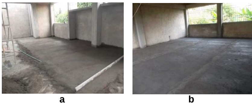
Figura 40 a, b: Pañetado de forma manual, se hizo las nivelaciones.
