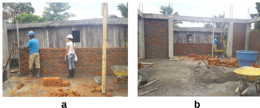
Figura 31 a, b: Proceso mediante plomada para verificar la linealidad y verticalidad de los muros.
