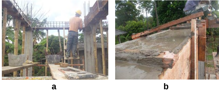
Figura 30 a, b: Armado de hierro, formaletería y fundición.
