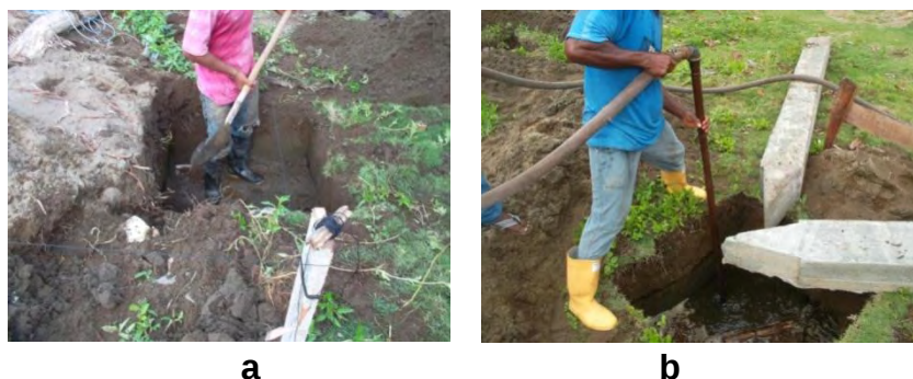
Figura 23 a, b: Proceso de hincado de pilotes.
