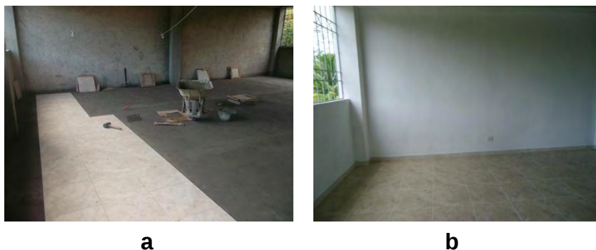
Figura 41 a, b: Enchape de baldosa mediante el codal para su linealidad y guardaescobas.
