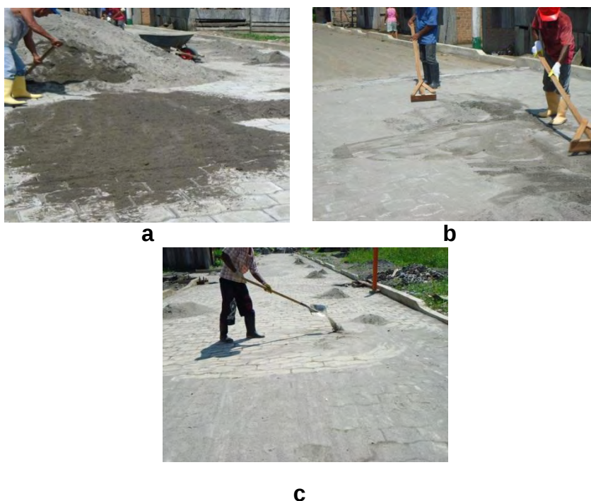
Figura 18 a, b, c: Sellado de juntas y recolección de arena.
