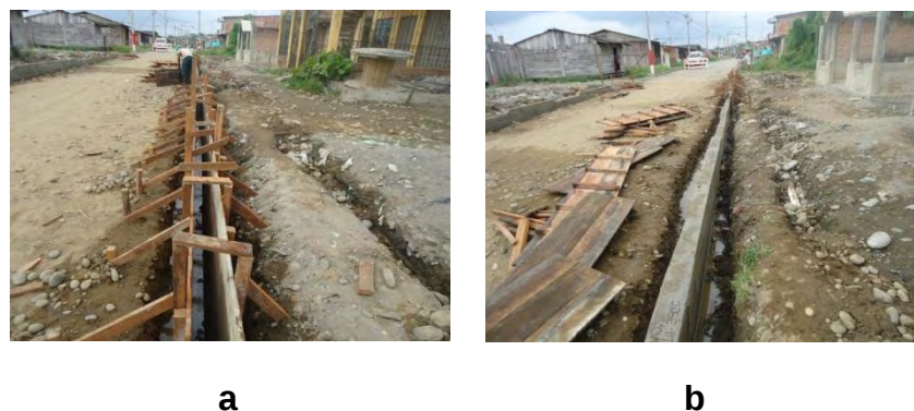
Figura 10 a, b: Proceso de formaletería, desencofrado para sardineles.
