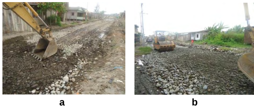
Figura 06 a, b: Colocación de la capa de afirmado por toda la vía.
