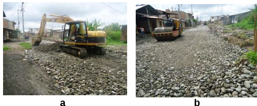
Figura 07 a, b: Se mejoró la sub-base con material de río con una capa de 20 cm.
