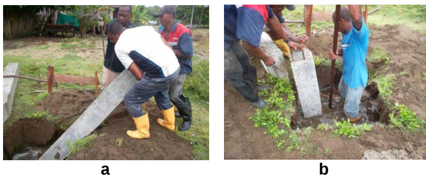
Figura 24 a, b: Hincado de pilotes de forma tradicional mediante motobomba.
