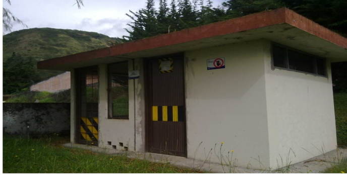
Figura 3: Centro de abastecimiento de gas y almacenamiento de agua de la Universidad de Nariño.
