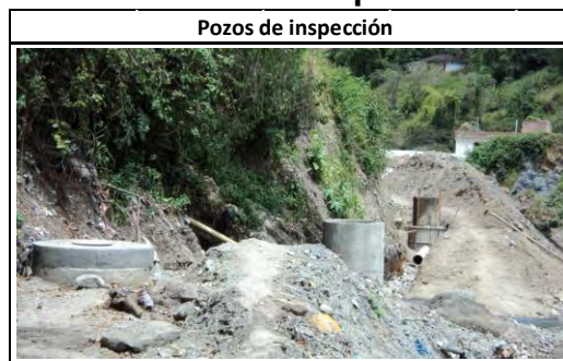
Figura 8. Construcción de pozos de inspección
