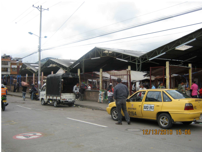
Figura 11. Vista externa de la plaza de mercado de 'El Tejar'
