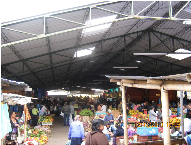
Figura 12. Cubierta de de la plaza de mercado de 'El Tejar'
