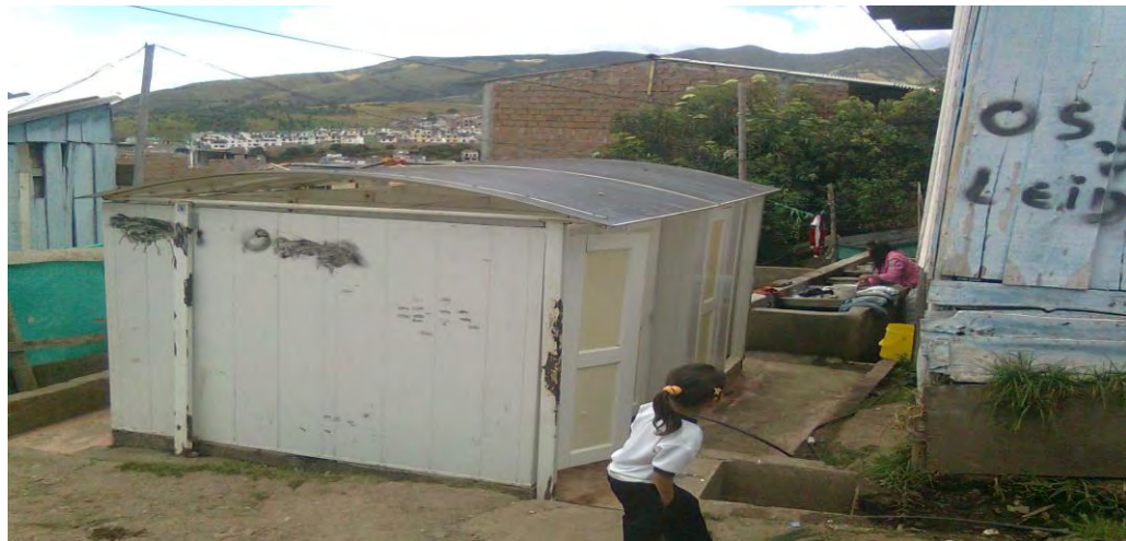
Figura 4. Baños y lavadero comunitario. Albergues la Alameda.
