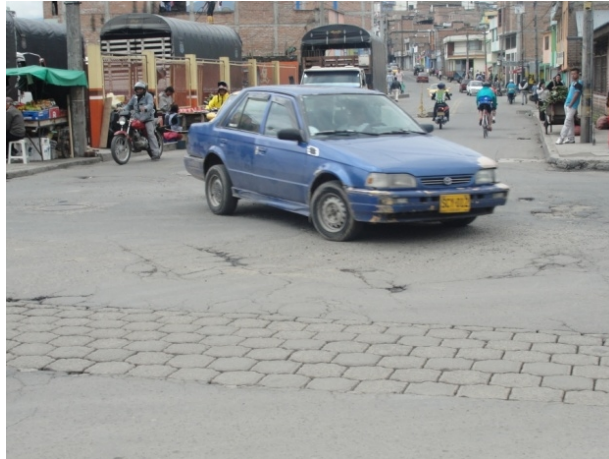
Figura 19. Fotografía vista general cruce carrera 4 calle 12
