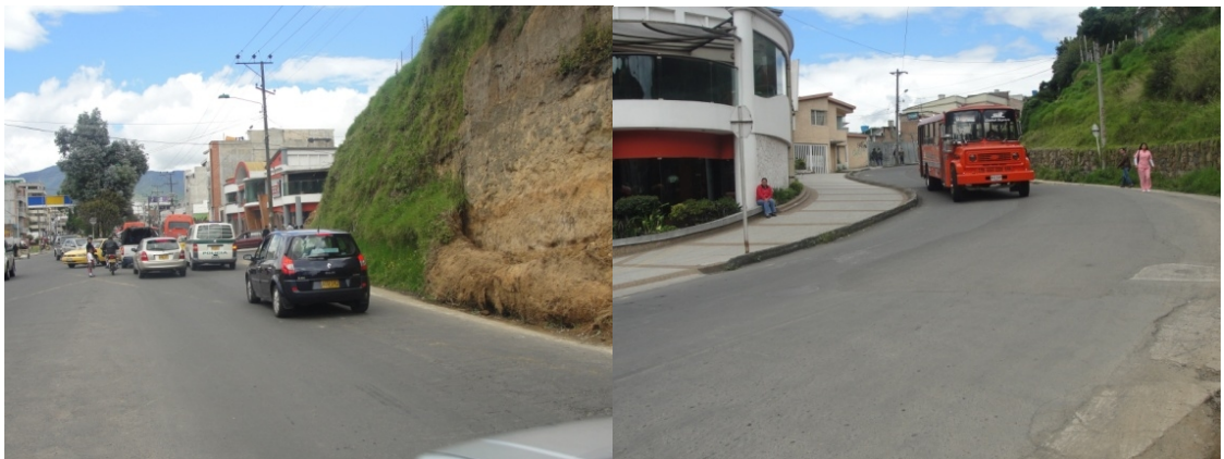
Figura 24. Fotografía vista general cruce carrera 42 calle 18
