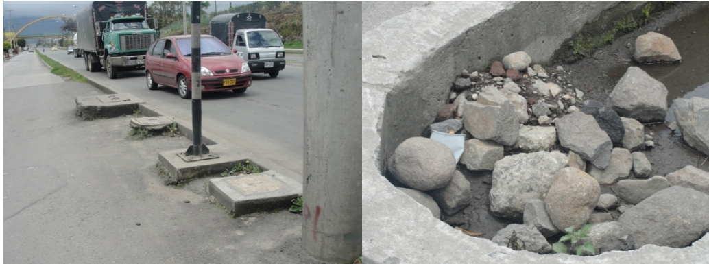
Figura 11. Fotografía detalle de separadores sector avenida panamericana con carrera 27
