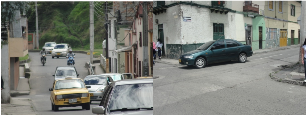
Figura 39. Fotografía vista general sector calle 22 entre carrera 26 y 27
