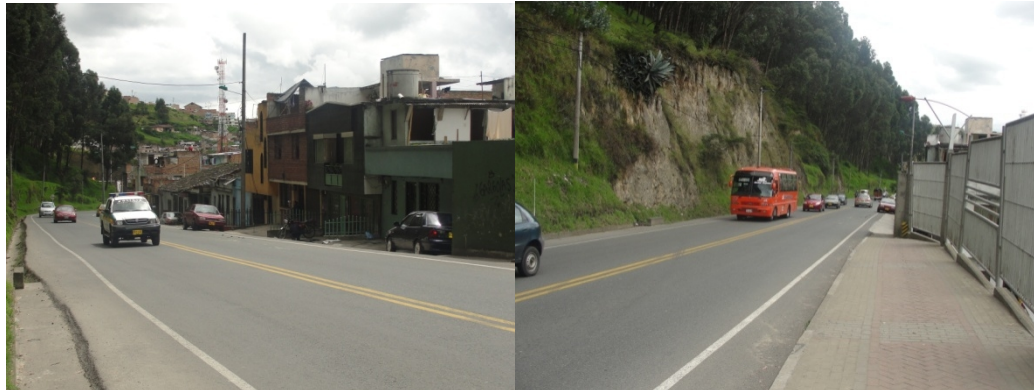
Figura 10. Fotografía sector salda al sur - parque Chapalito
