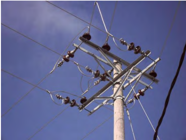
Figura No 12. Nuevas redes eléctricas.
