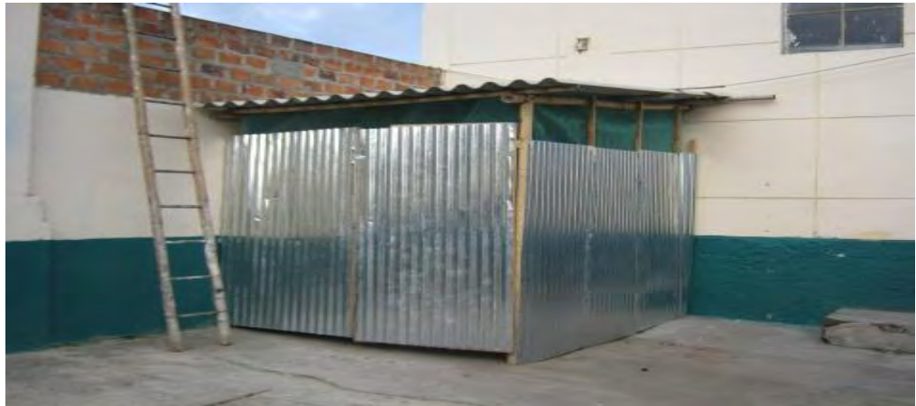
Cuarto de almacenamiento de residuos solidos
