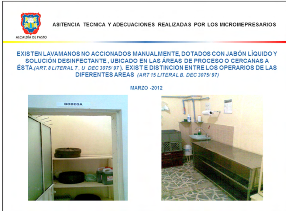
Figura 13. Adecuación instalación de lavamanos en área de proceso y señalización de la fábrica.
