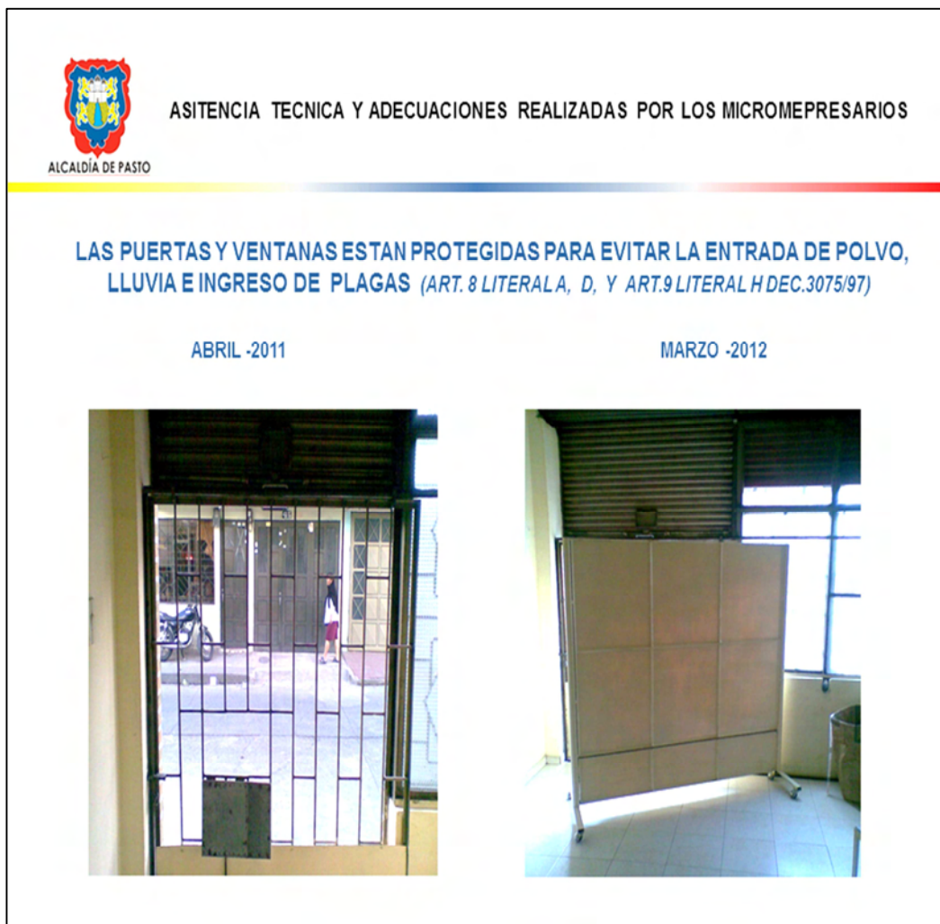
Figura 12. Adecuación instalación de barrera física para evitar contacto directo con el exterior.
