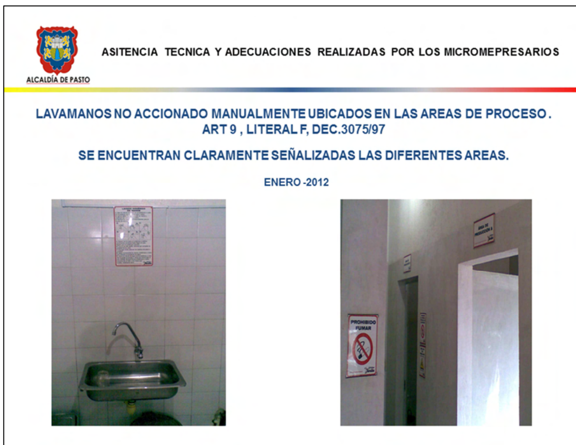
Figura 8. Instalación de lavamanos en áreas de proceso y señalización de la fábrica
