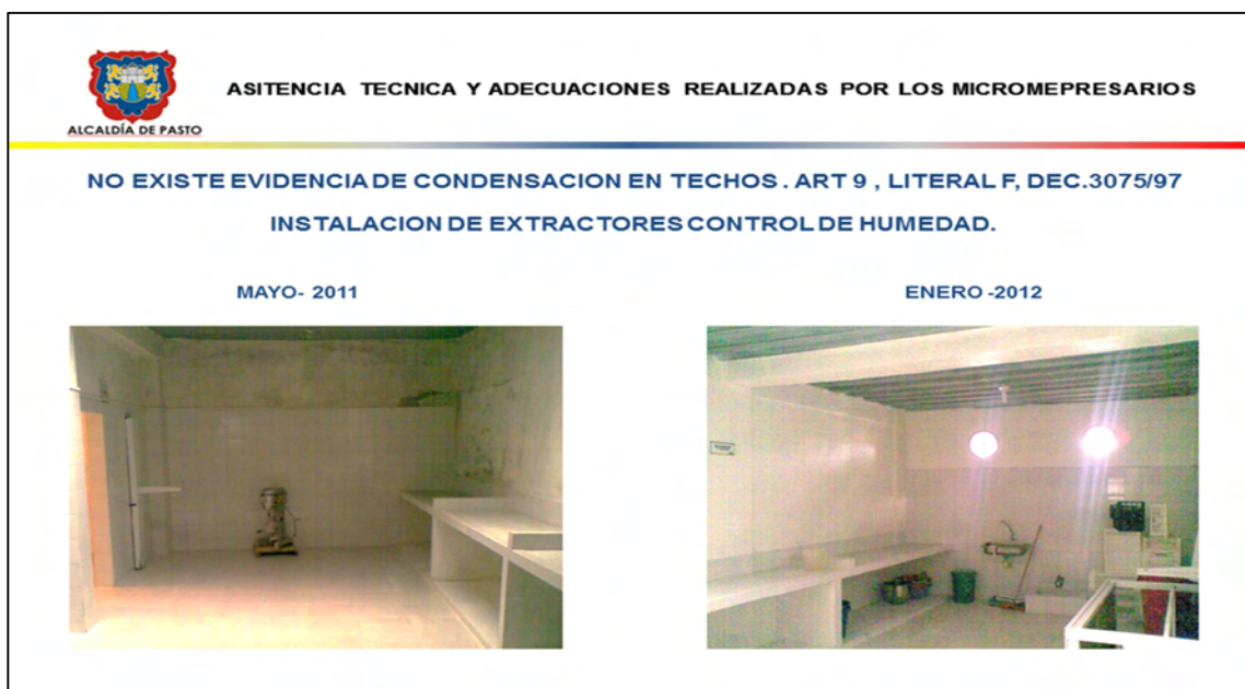
Figura 6. Instalación de extractores para control de humedad en área de proceso
