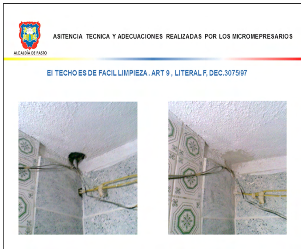
Figura 18. Mantenimiento del techo y paredes.
