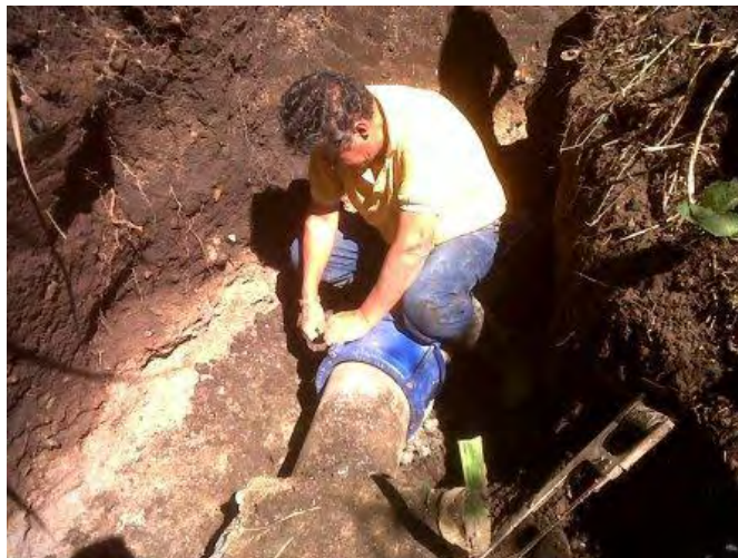
Figura 11.2 Cambio de tubería acueducto del casco urbano de Morelia
