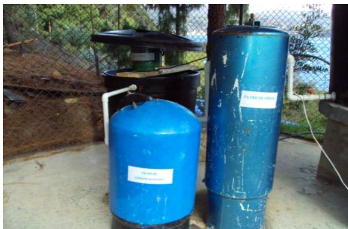
Figura #39. Montaje potabilización de agua
