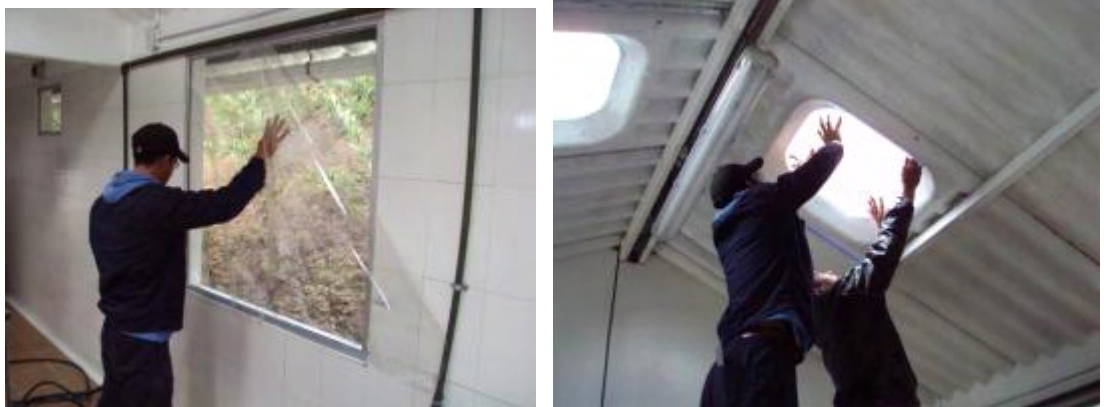
Figura #18. Instalación películas protectoras en vidrios
