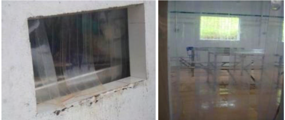
Figura #17. Cortina protectora de ventanas y puertas
