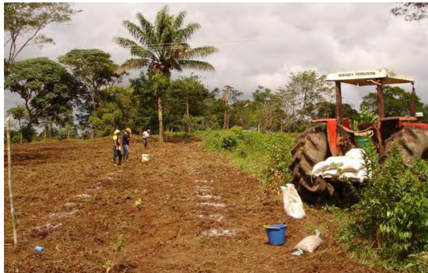
Figura 7. Compactación del terreno
