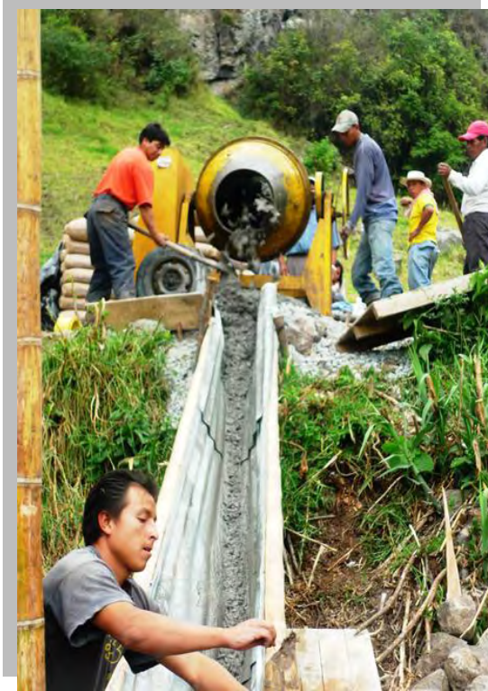
IMAGEN 18. Construcción caseta purificadora de agua
