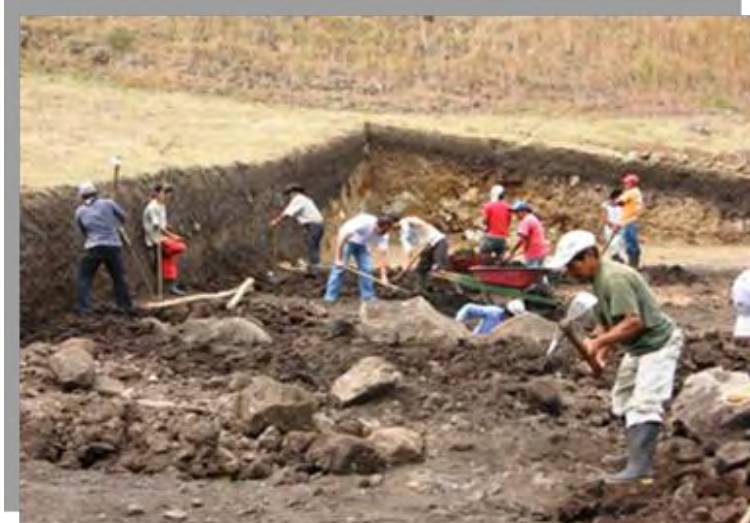
IMAGEN 12. Excavación para nivelación del terreno
