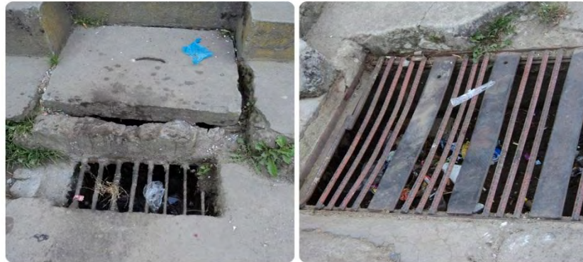
Figura 12. Sumideros del sistema de alcantarillado – municipio de Sapuyes
