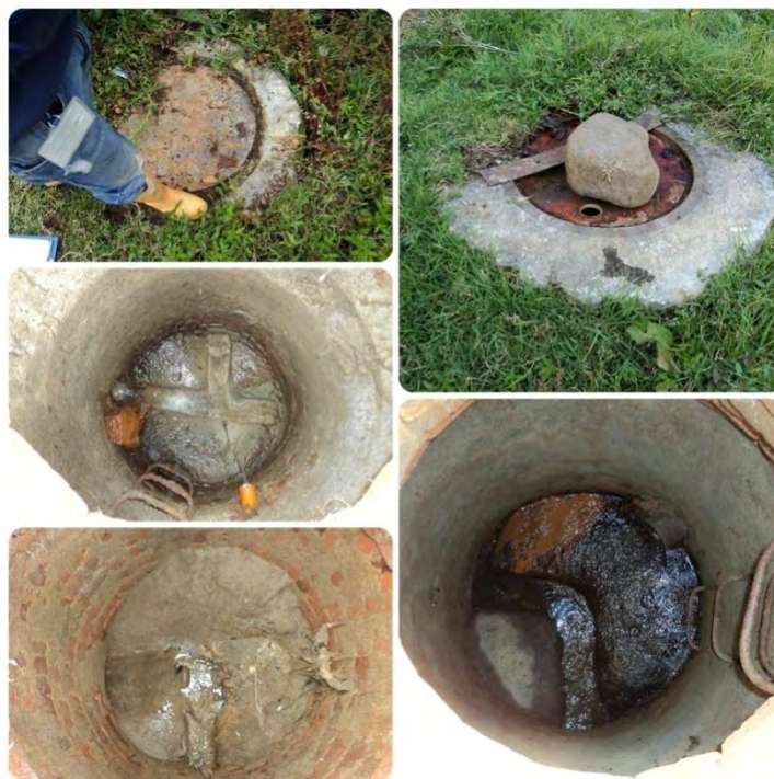
Cuadro 67. Pozos de inspección – Corregimiento El Encano
