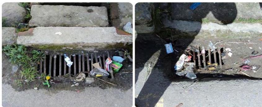
Figura 16. Sumidero del sistema de alcantarillado existente – corregimiento El Encano
