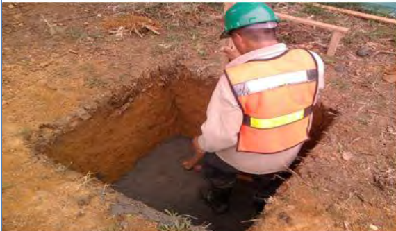
concreto 1500psi de limpieza
