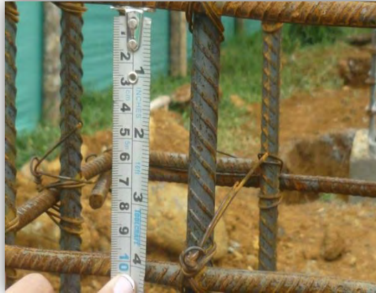
Figura 31. Revisión de colocación del refuerzo
