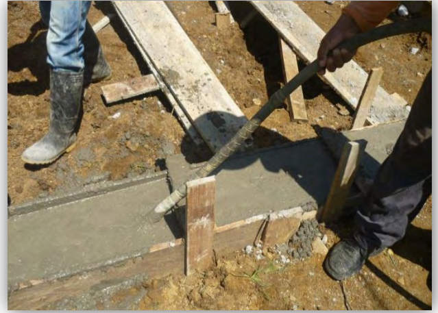
Figura 37. Fundición de elementos de cimiento
