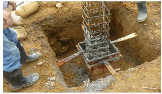
Fundicion de pedestales
