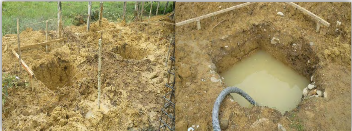
Figura 60. Excavaciones batería sanitaria
