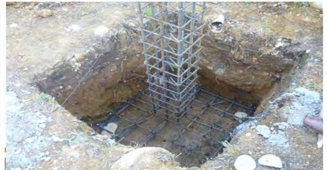
refuerzo zapatas, pedestales y columnas
