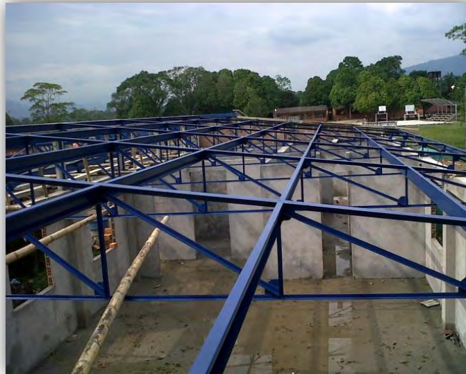
Figura 52. Instalación estructura metálica
