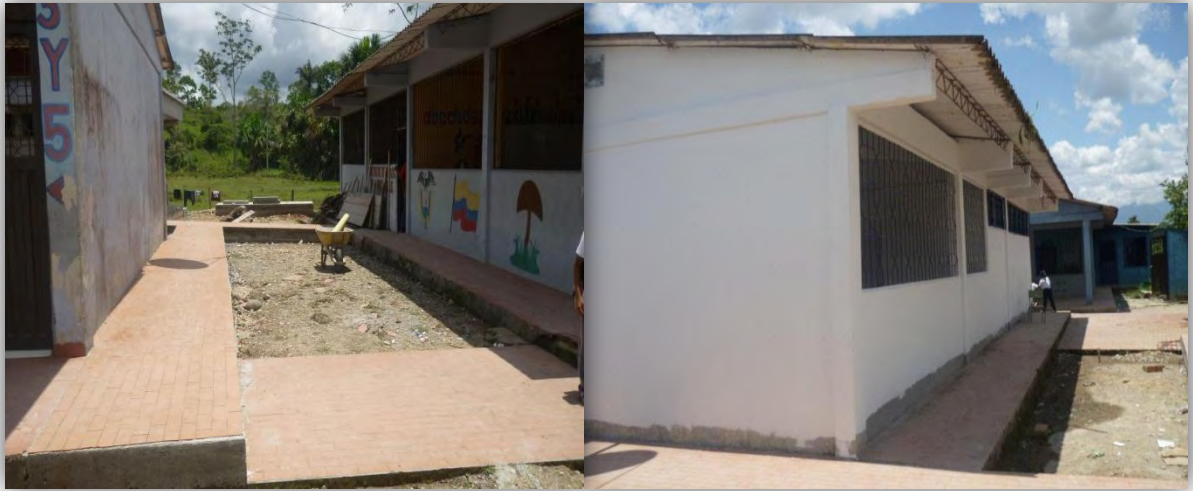
Figura 87. Adecuaciones Institución educativa Islandia
