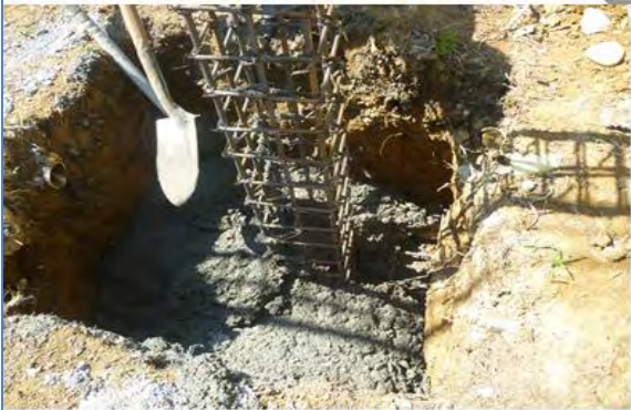
Fundicion de zapatas
