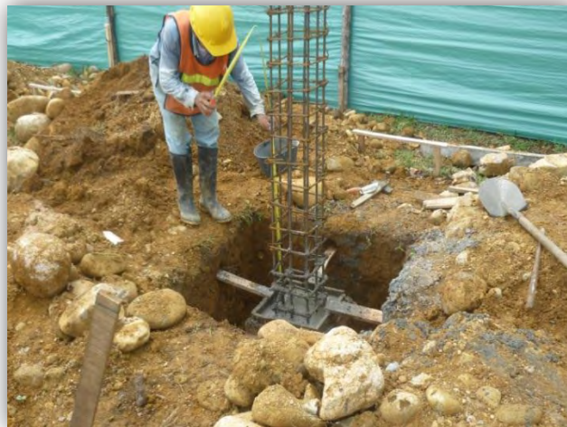
Figura 35. Construcción de pedestales
