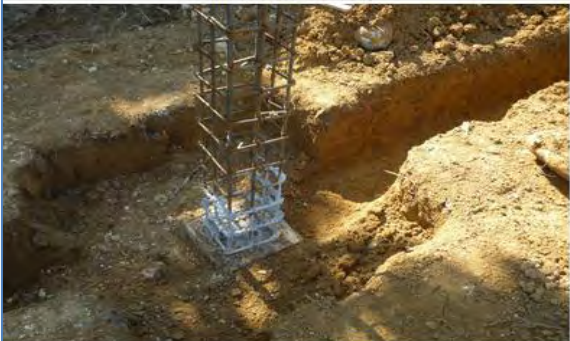
excavaciones para vigas de cimentacion
