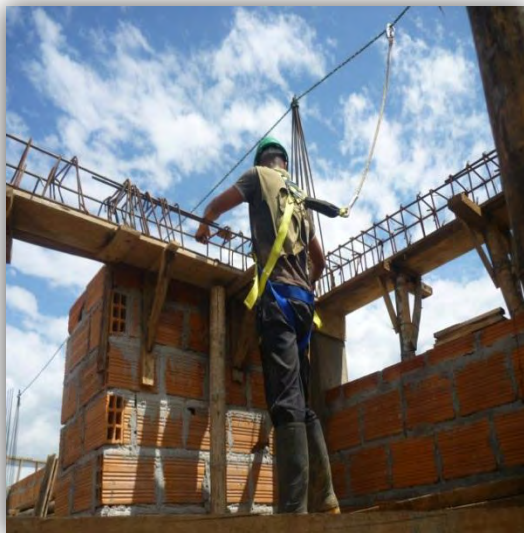
Figura 50. Refuerzo viga aérea
