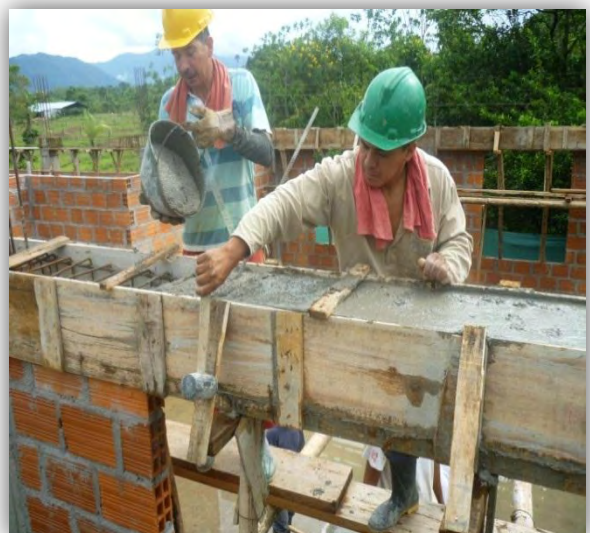
Figura 51. Fundición del elemento
