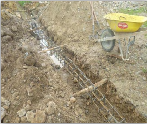
Figura 66. Viga de cimentación
