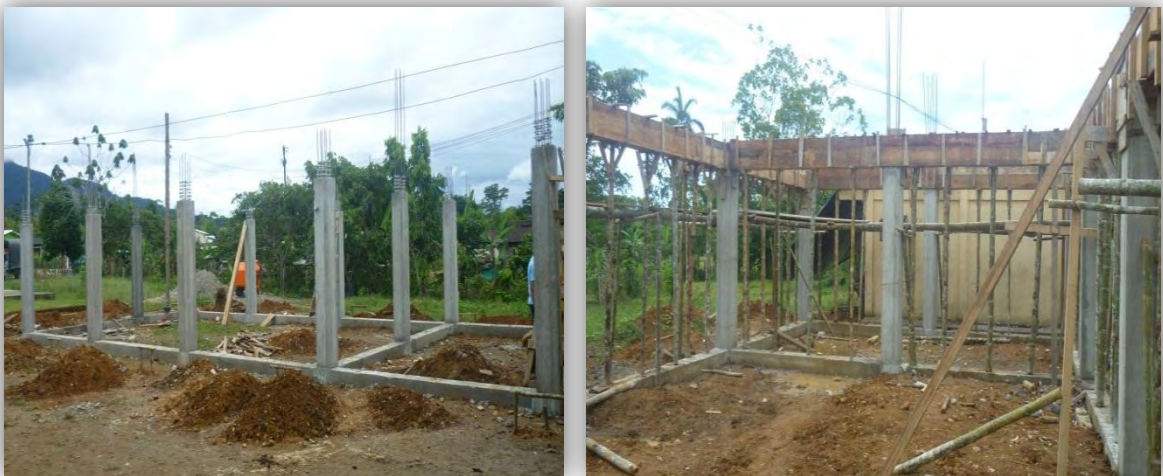
Figura 74. Estructura restaurante escolar
