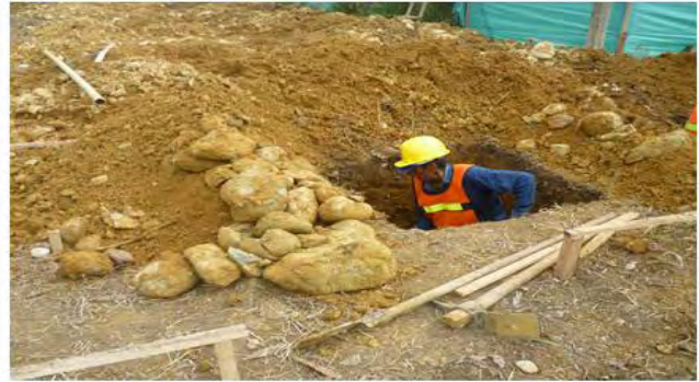
Excavaciones para zapatas
