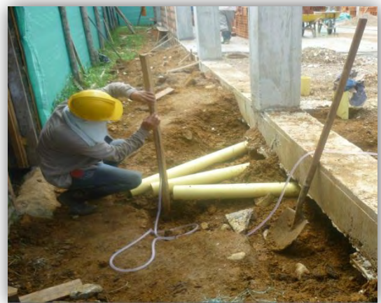
Figura 43. Rectificación de niveles
