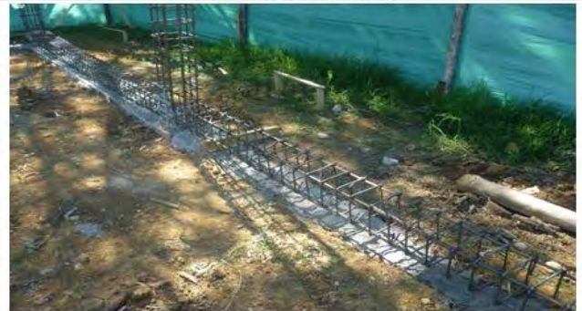
solados y refuerzo de vigas de cimentacion
