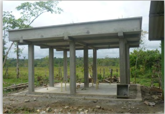
Figura 71. Estructura batería sanitaria
