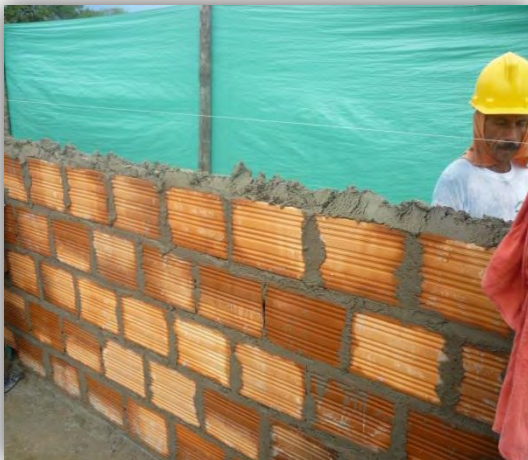
Figura 48. Pega de muros
