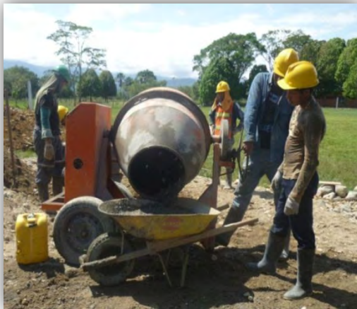
Figura 27. Preparación del concreto
