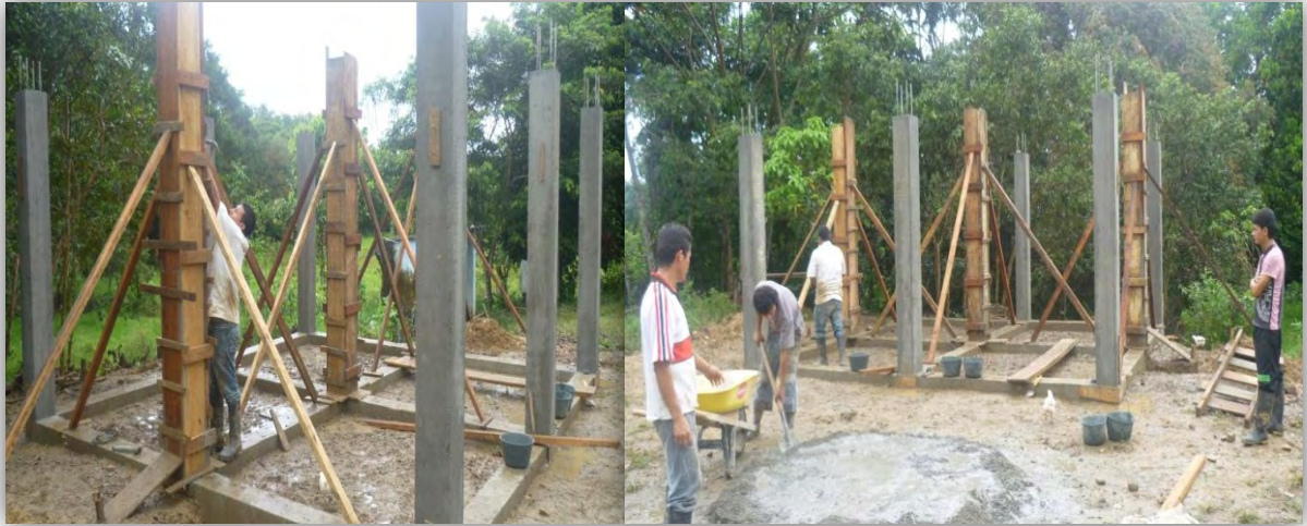
Figura 80. Estructura batería sanitaria
