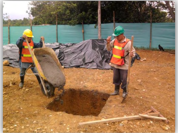
Figura 26. Vaciado de concreto simple
