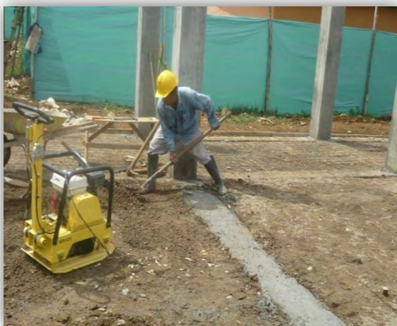
Figura 40. Material de relleno
