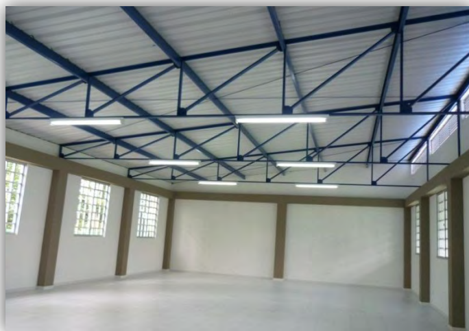
Figura 57. Instalación de lámparas fluorescentes.
