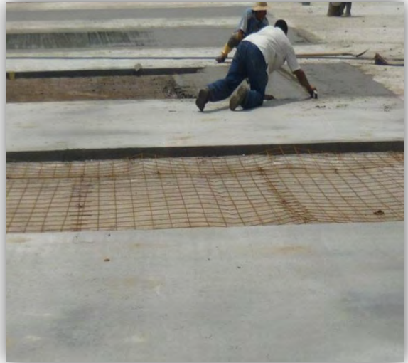
Figura 79. Fundición de placa
