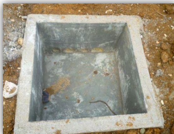
Figura 45. Cajas en concreto Inspección
