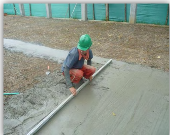
Figura 41. Fundicion de placa
