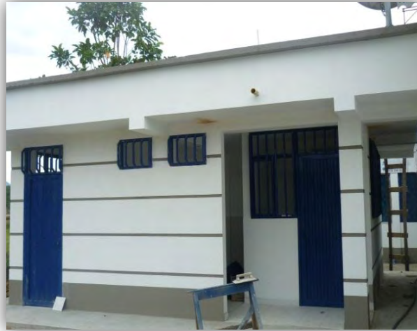
Figura 61. Batería sanitaria S. Isidro
