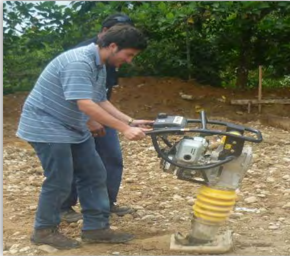
Figura 78. Equipo de compactación
