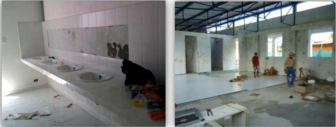
Figura 53. Enchape de paredes, pisos y mesones
