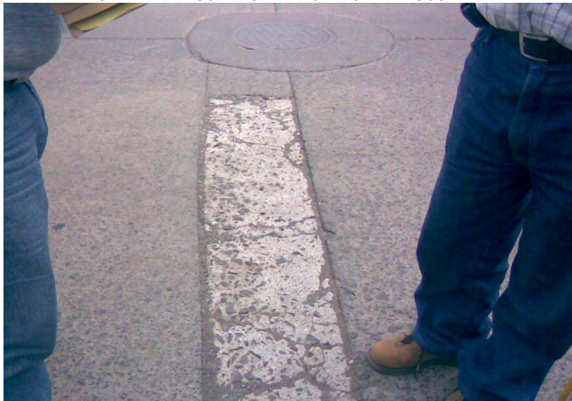
FIGURA No. 10. VERIFICACIÓN DEL CUMPLIMIENTO DE MEDIDAS DE SEGURIDAD Y CONTROL CAMARA DE INSPECCION
