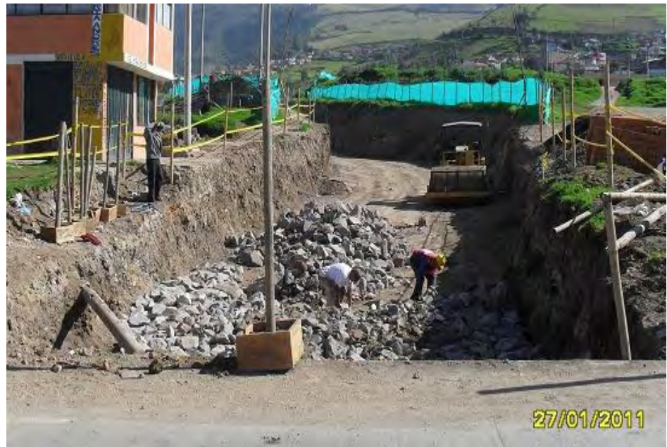
FIGURA No. 23. EN PROCESO PRECOMPACTACIÓN DE LA SUBRASANTE Y COLOCACIÓN DE RAJÓN PARA CIMENTACIÓN DE LA ESTRUCTURA DE PAVIMENTO SEGÚN REDISEÑO A PARTIR DEL K0+610.
