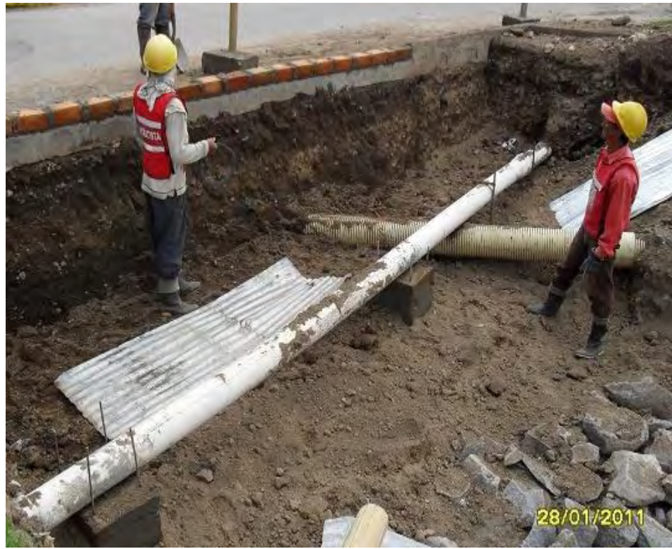
TUBERÍA ACUEDUCTO Y ALCANTARILLADO EXISTENTE EN LA VIA.
