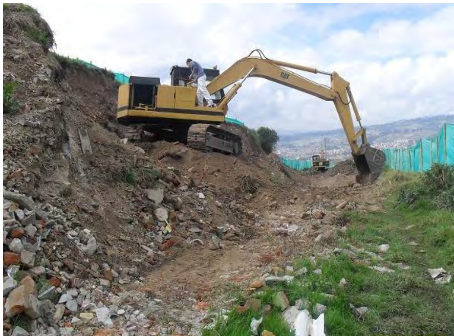
VISTA GENERAL DEL MATERIAL QUE CONFORMA EL TERRENO EN LA ZONA DE TRABAJO (ESCOMBROS A MÁS DE 5 METROS DE ALTURA).
