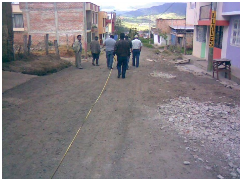
VERIFICACION DE LONGITUD PARCIAL
