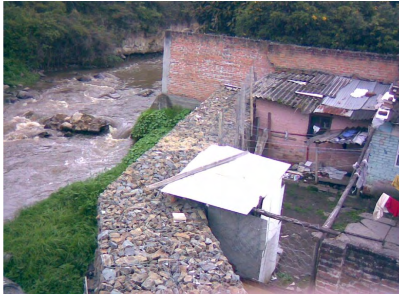
FIGURA No. 12. MURO EN GAVIÓN UBICADO EN EL BARRIO LAS CUADRAS EN LA CALLE 21 N° 31C-114
