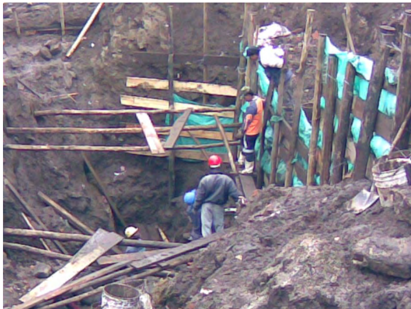
FIGURA No. 17. EXCAVACIÓN A MAQUINA Y MANUAL- ENTIBADO DEL TALUD BARRIO CORAZÓN DE JESÚS.
