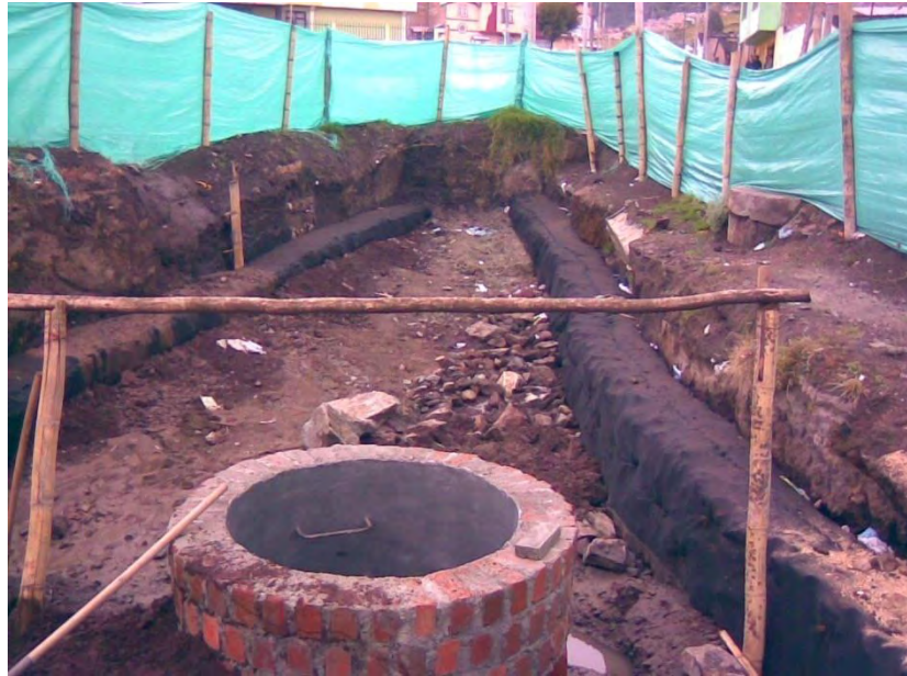
CONSTRUCCIÓN SISTEMA DE FILTRACIÓN PAVIMENTACIÓN RIO BLANCO.
