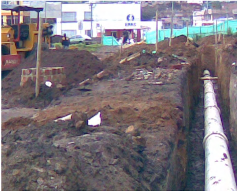
FIGURA No. 26. APERTURA RED HIDRAULICA. VÍA AQUINE-EMAS-CARRERA 24-BOMBEROS.
