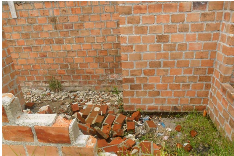
OTRA VISTA DEL MURO DIVISORIO.
