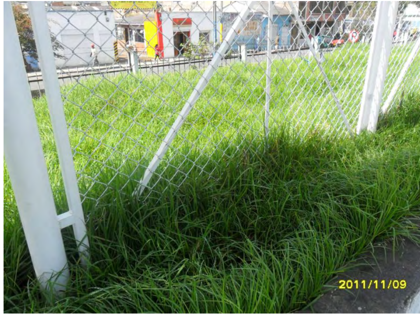
BASE DE LA ESTRUCTURA METÁLICA.
