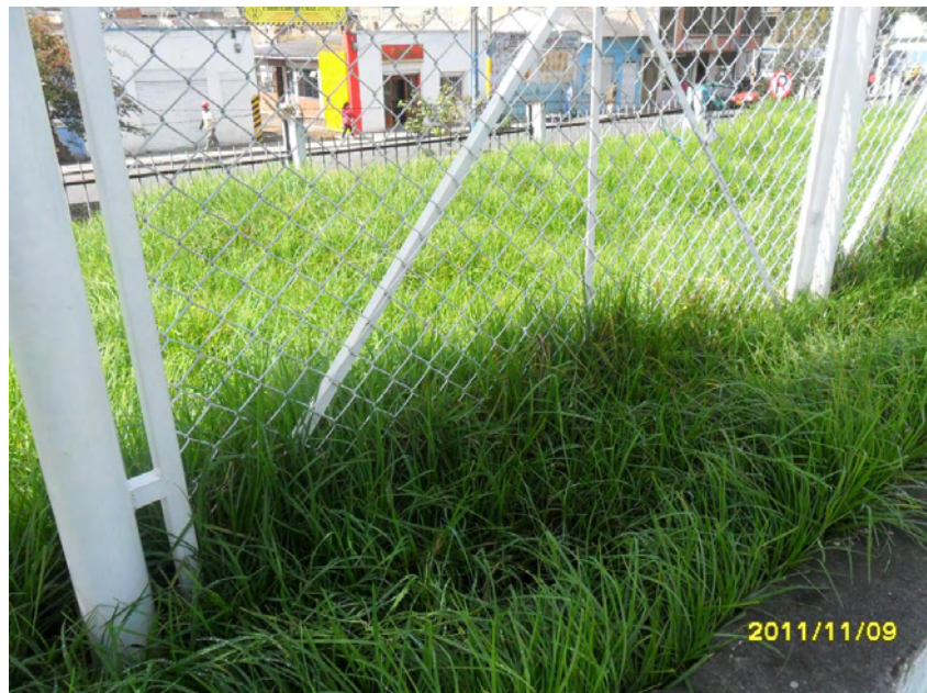
FIGURA No. 31. BASE DE LA ESTRUCTURA METÁLICA. CERRAMIENTO CANCHA DE FUTBOL PARQUE BOLÍVAR MUNICIPIO DE PASTO.
