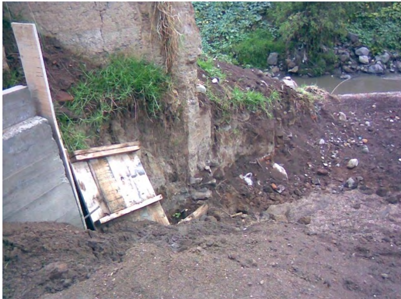
EXCAVACIÓN RIVERA RIO PASTO PARA CONSTRUCCIÓN DE ESTRIBO DEL PUENTE.
