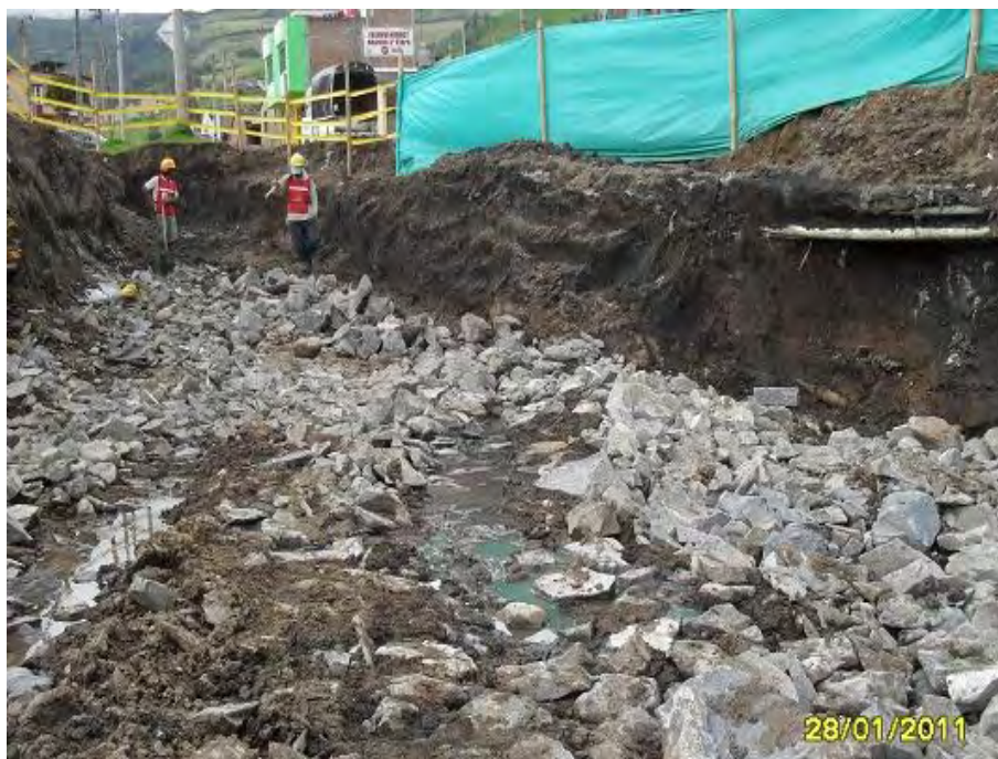
FIGURA No. 24. VISTA GENERAL DE PEDRAPLEN PARA CIMENTACIÓN DE LA NUEVA ESTRUCTURA DE PAVIMENTO ANTES DEL EMPALME CON LA VIA DE LA FLORESTA.
