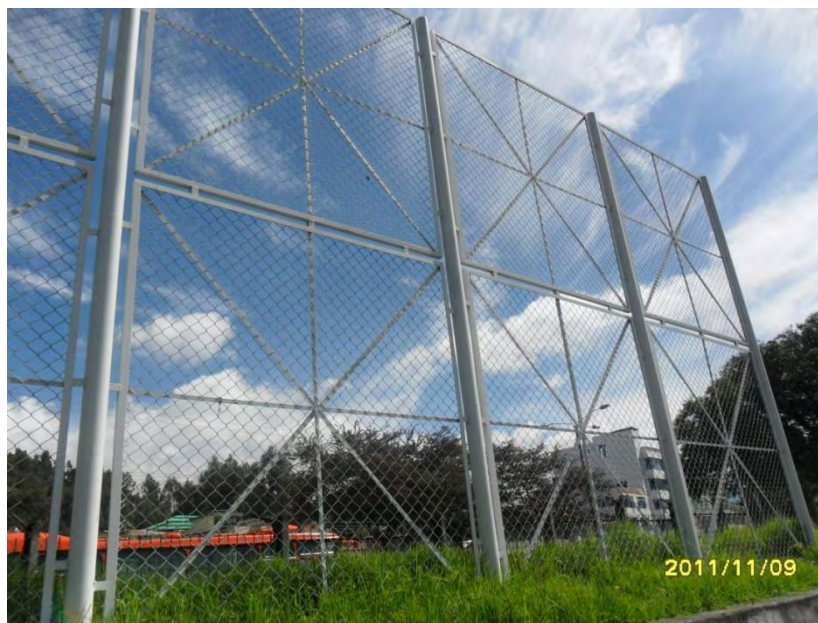
VISTA FRONTAL CERRAMIENTO DE PROTECCIÓN. ALTURA 5MTS
