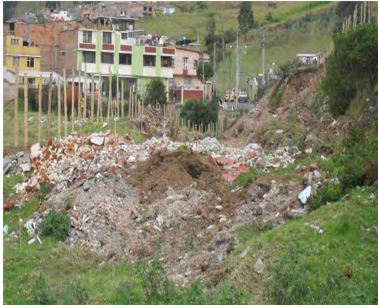
COLOCACIÓN DE POSTES PARA CERRAMIENTO CON ADIFLEX TRAMO CORAZÓN DE JESUS – LA FLORESTA / VISTA GENERAL DE ACUMULACIÓN DE ESCOMBROS Y BASURAS A LO LARGO DEL PROYECTO (K0+640 A K0+870)
