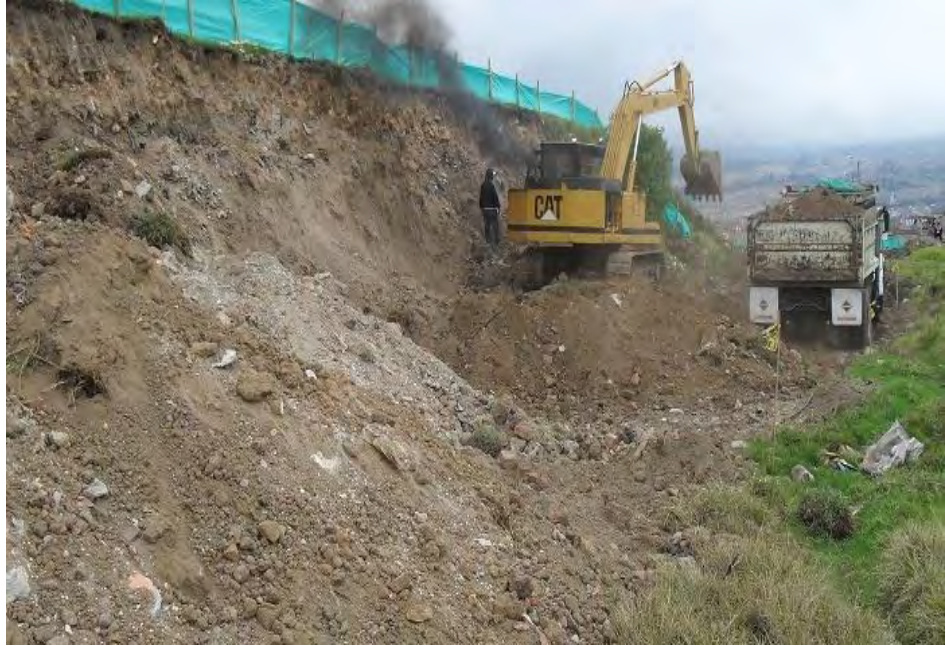
AVANCE DE CORTE EN TALUD CON EL SEGUNDO FRENTE DE TRABAJO – DESALOJO POR LA VIA PRINCIPAL DEL CORAZÓN DE JESUS CON DESTINO A LA ESCOMBRERA MUNICIPAL.
