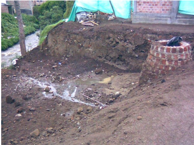
OTRA VISTA DE LA EXCAVACIÓN.
