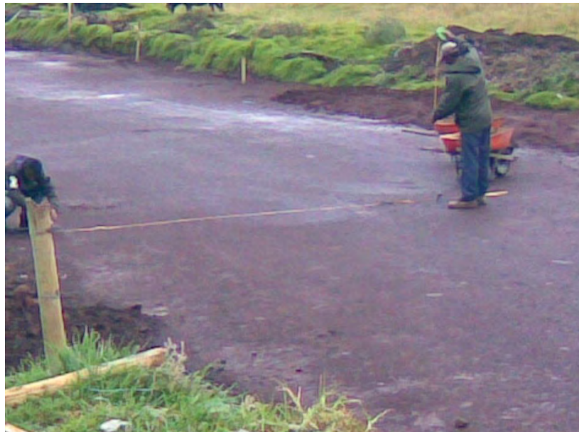
MEDICIÓN TRANSVERSAL DE LA VIA.
