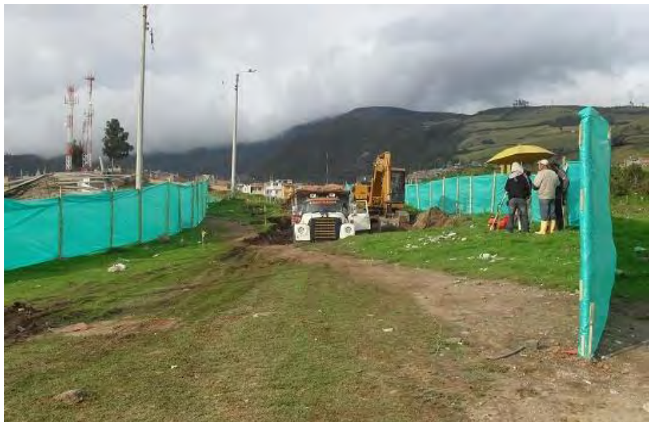
CONTROL DE CORTES PARA CAJEO INICIAL DESDE EL K0+650 A CARGO DE LA COMISIÓN DE TOPOGRAFIA DEL CONTRATISTA BAJO LA SUPERVISIÓN DE INTERVENTORIA.
