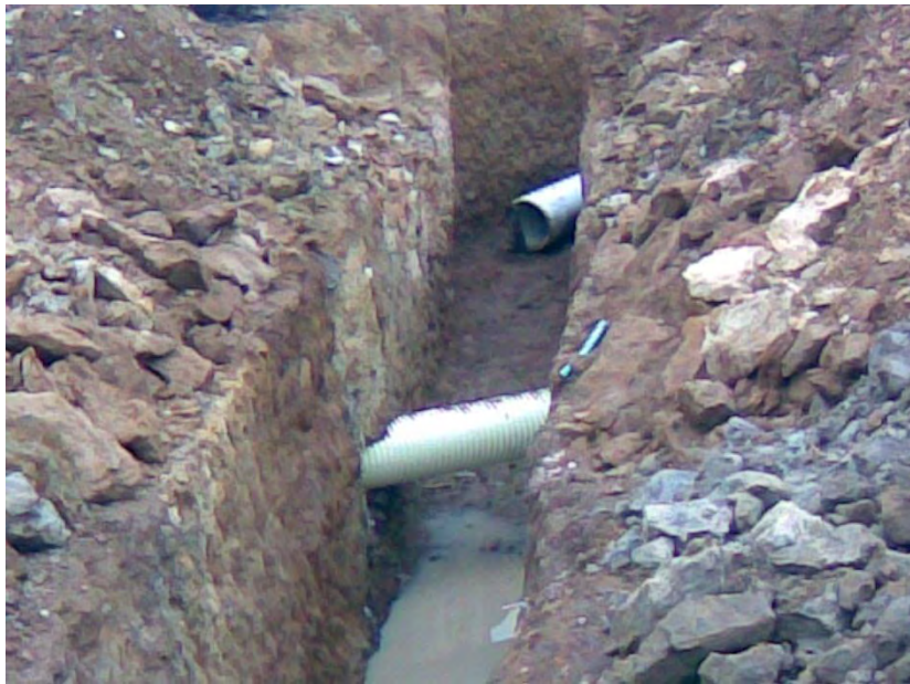
APERTURA RED SANITARIA.
