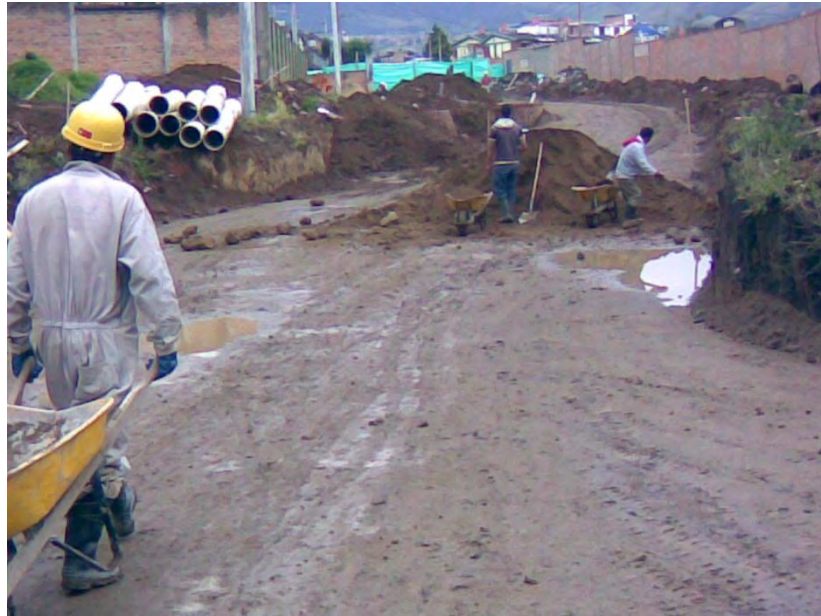
FIGURA No.28. MEJORAMIENTO DE SUBRASANTE CON MATERIAL IMPORTADO. VÍA AQUINE-EMAS-CARRERA 24-BOMBEROS
