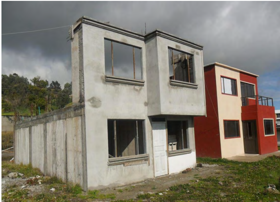
VIVIENDA SIN TERMINAR.
