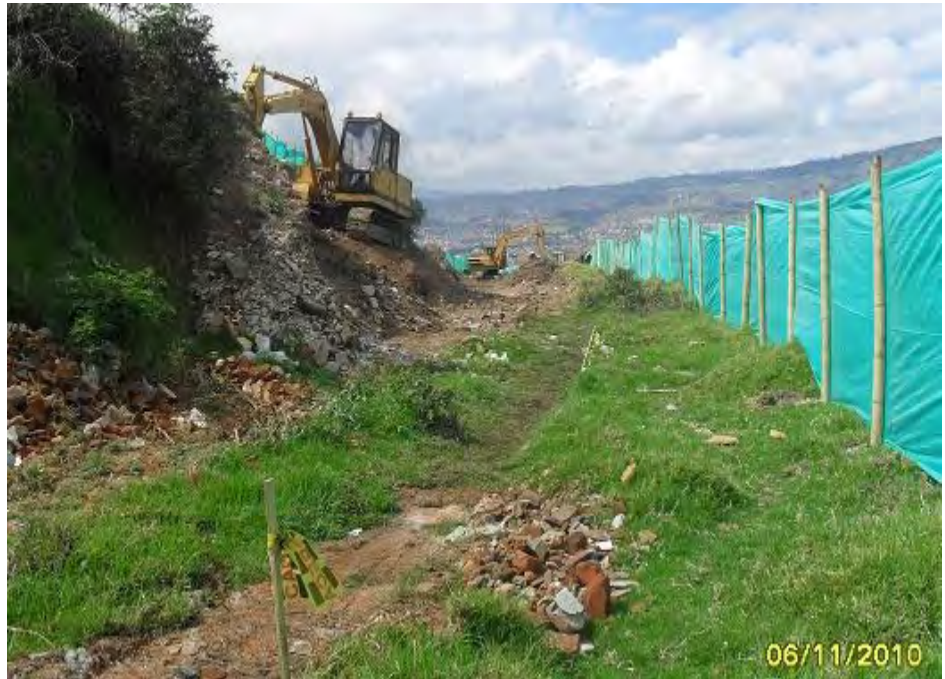
DOS (02) FRENTES DE TRABAJO PARA EXCAVACIÓN A MÁQUINA, 1º CORTE EN TALUD Y 2º CAJEO INICIAL / VISTA GENERAL DEL AISLAMIENTO CON TELA VERDE Y EN PROCESO DE EXCAVACIÓN A MÁQUINA CON 2 RETROEXCAVADORAS.
