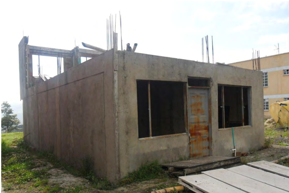
FIGURA No. 16. VISTA POSTERIOR DE LA VIVIENDA. CASA CHINA PANELES PREFABRICADOS.
