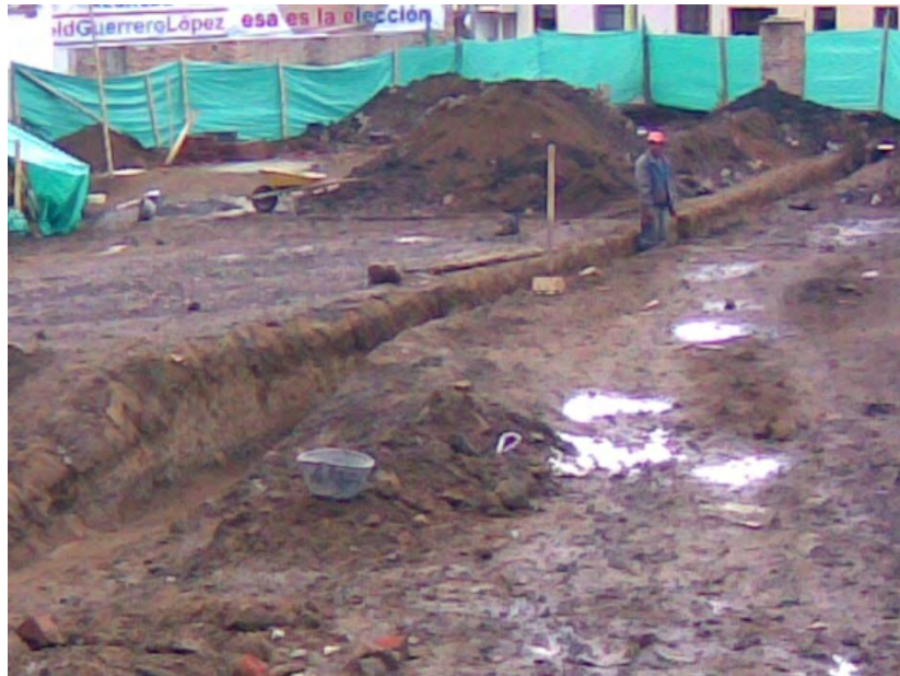
APERTURA RED DE ALCANTARILLADO.
