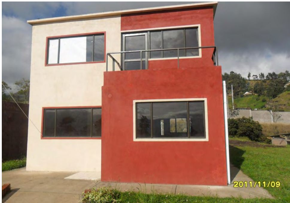
FIGURA No. 15. FACHADA DE LA VIVIENDA TERMINADA. DONACIÓN DEL INMUEBLE POR PARTE DE LA ONG CONSTRUIR VIDA A LA ALCALDÍA DE PASTO.
