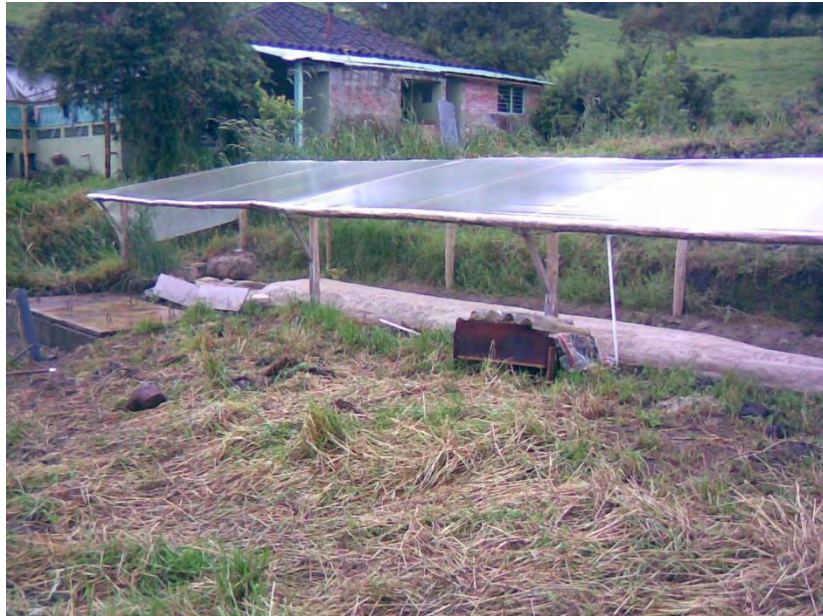
FIGURA No. 1 BIODIGESTOR VISTA LATERAL. SISTEMA DE TRATAMIENTO PARA LA DEPURACIÓN DE LAS AGUAS RESIDUALES DOMÉSTICAS Y PECUARIAS A TRAVÉS DE BIOFILTROS Y BIODIGESTORES
