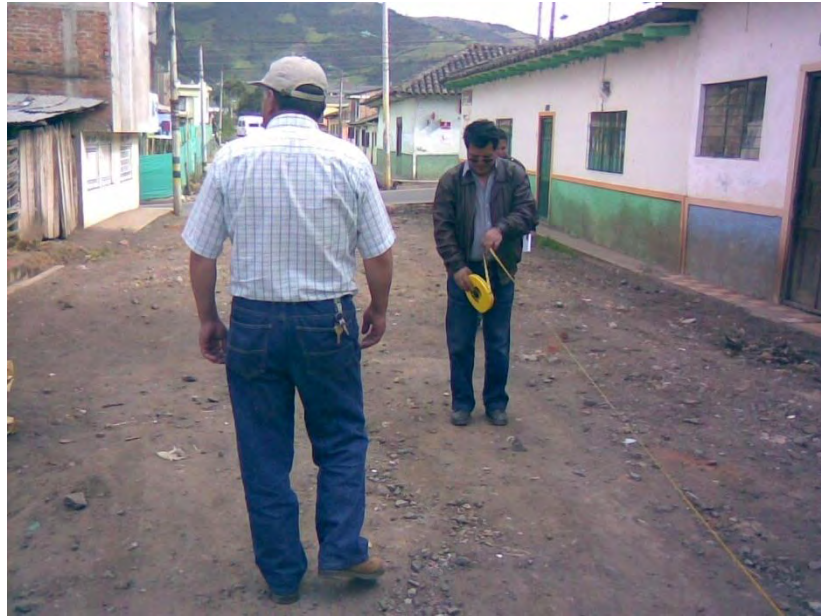
MEDICION DE LONGITUD TOTAL EMPALME CALLE PRINCIPAL
