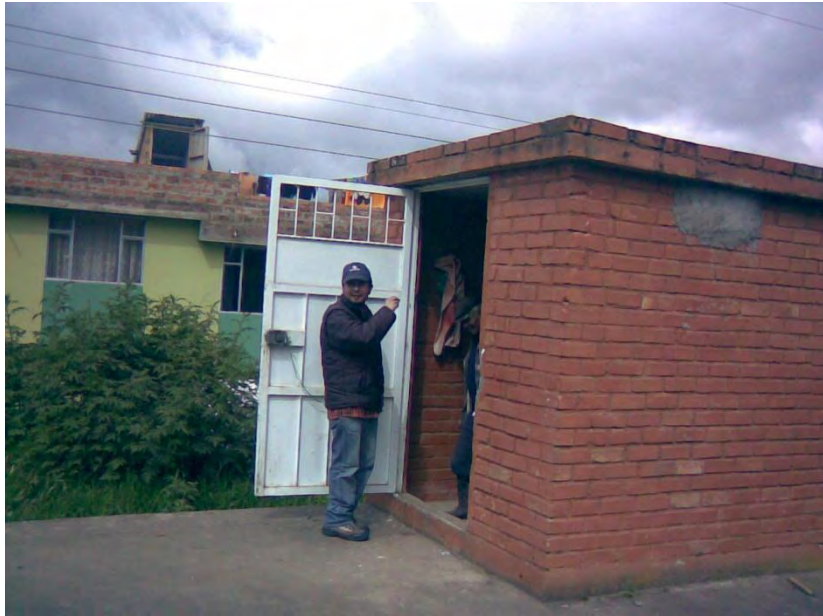
FIGURA No. 3. CASETA QUE CONTIENE AL SISTEMA DE DESINFECCION.
