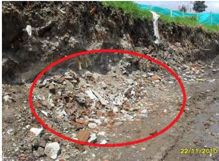
FIGURA No. 22. VISTA GENERAL DEL MATERIAL QUE CIMENTARÍA LA ESTRUCTURA DE PAVIMENTO Y LOS ANDENES ANTES DEL REDISEÑO.
