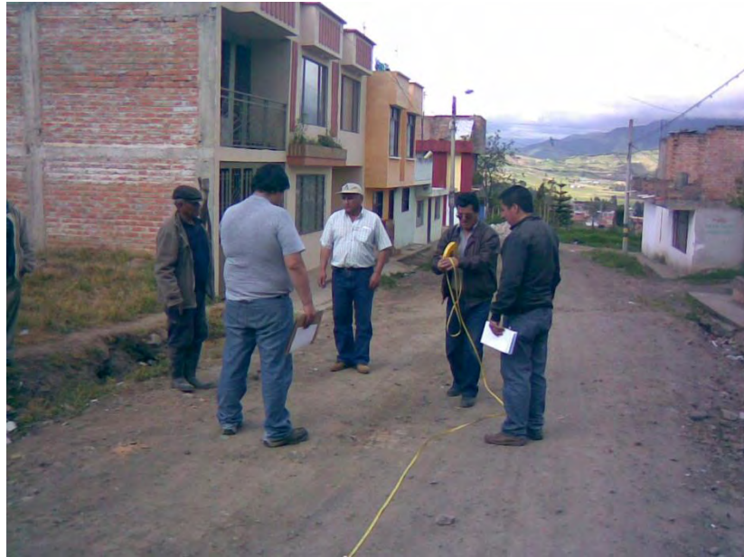
FIGURA No. 7. VERIFICACION DE MEDIDAS CONSTRUCCIÓN DE ALCANTARILLADO DE AGUAS NEGRAS VEREDA SAN MARTIN CORREGIMIENTO DE CATAMBUCO.
