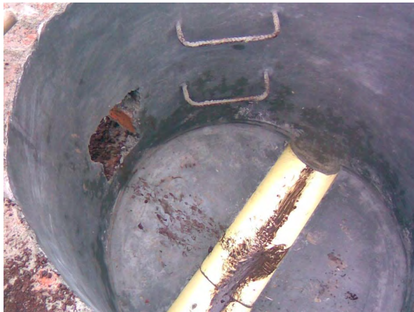
FIGURA No.25. CAMARA DE INSPECCIÓN. VÍA AQUINE-EMAS-CARRERA 24-BOMBEROS.
