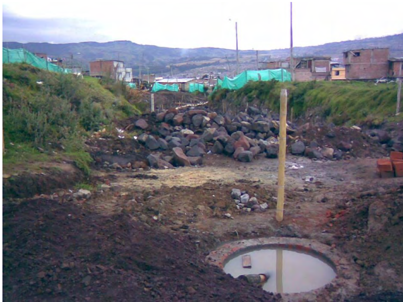
FIGURA No. 19. CONSTRUCCIÓN SISTEMA DE ALCANTARILLADO BARRIO CORAZÓN DE JESÚS.
