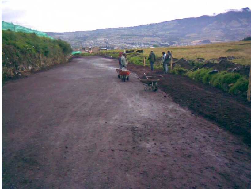
FIGURA No.20. COLOCACIÓN Y COMPACTACIÓN DE SUBBASE CON MATERIAL IMPORTADO, BARRIO CORAZÓN DE JESÚS.
