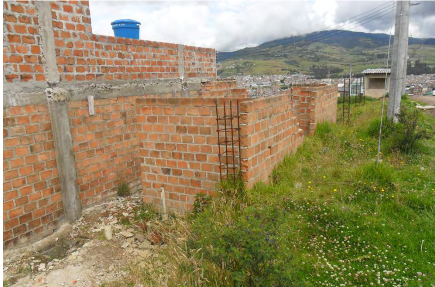
OTRA VISTA DE LA CONSTRUCCIÓN.
