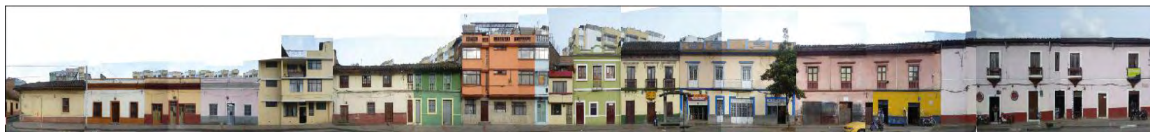
4. Recintos patrimoniales que aun conservan tipologías arquitectónicas con estilo republicano.- Desarrollo de nueva vivienda sin características tipológicas que respeten y valoren el patrimonio arquitectónico del recinto.
