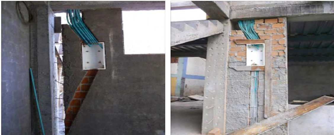
Imagen 40. Instalación tablero de distribución.
