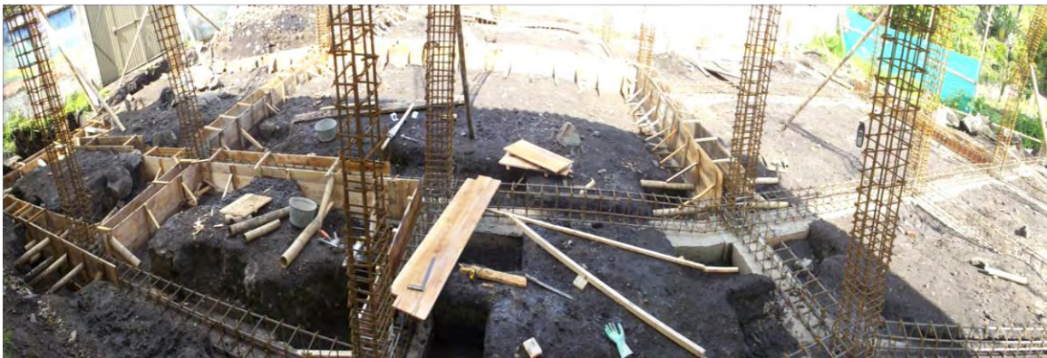
Imagen 10. Estructuras de cimentación.
