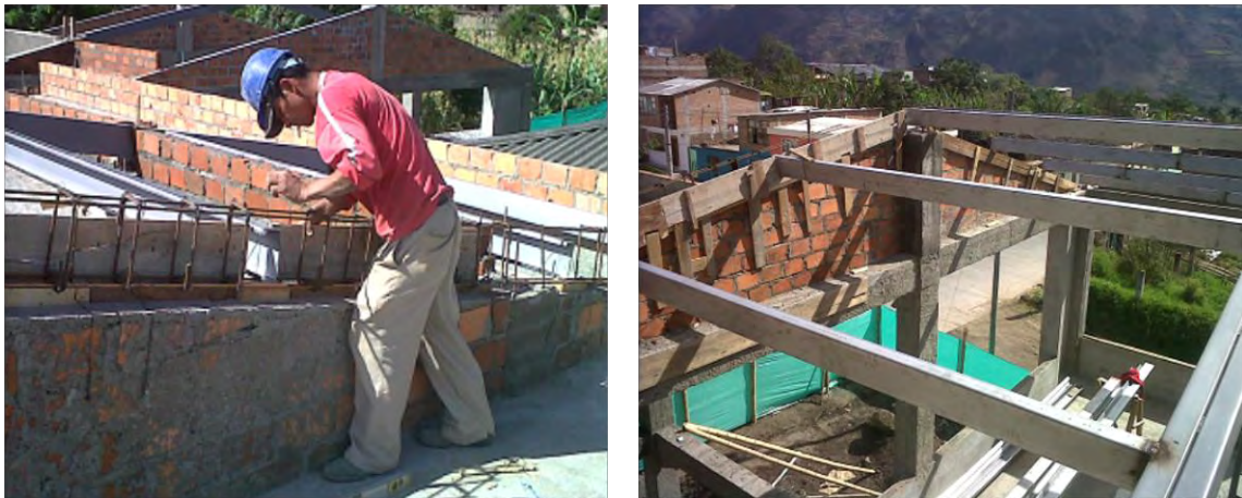
Imagen 17. Acero y vaciado de vigas cinta.
