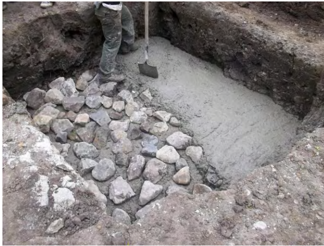
Imagen 9. Mejoramiento del terreno con concreto ciclópeo.
