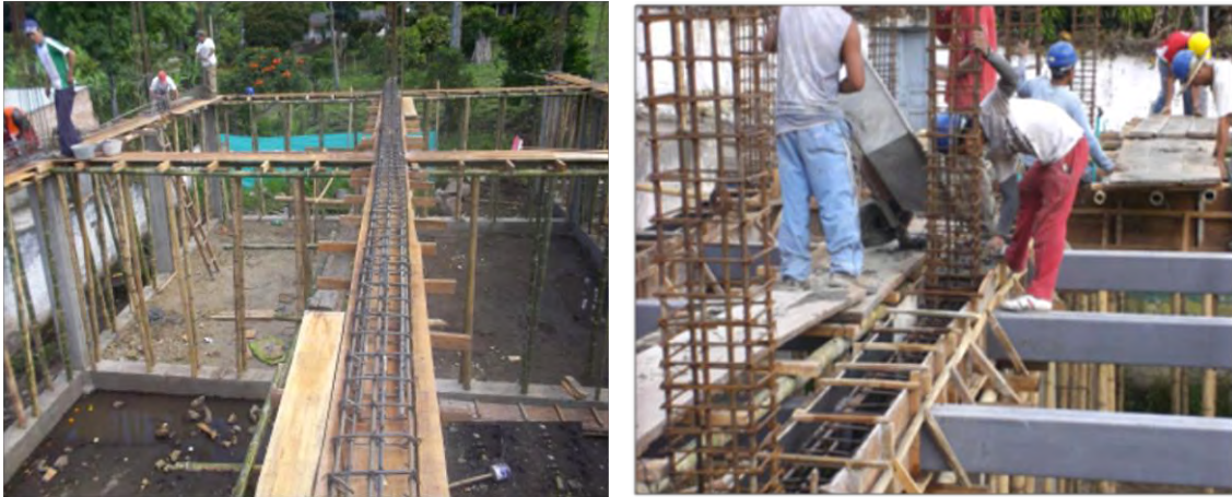
Imagen 16. Acero y vaciado de vigas aéreas.
