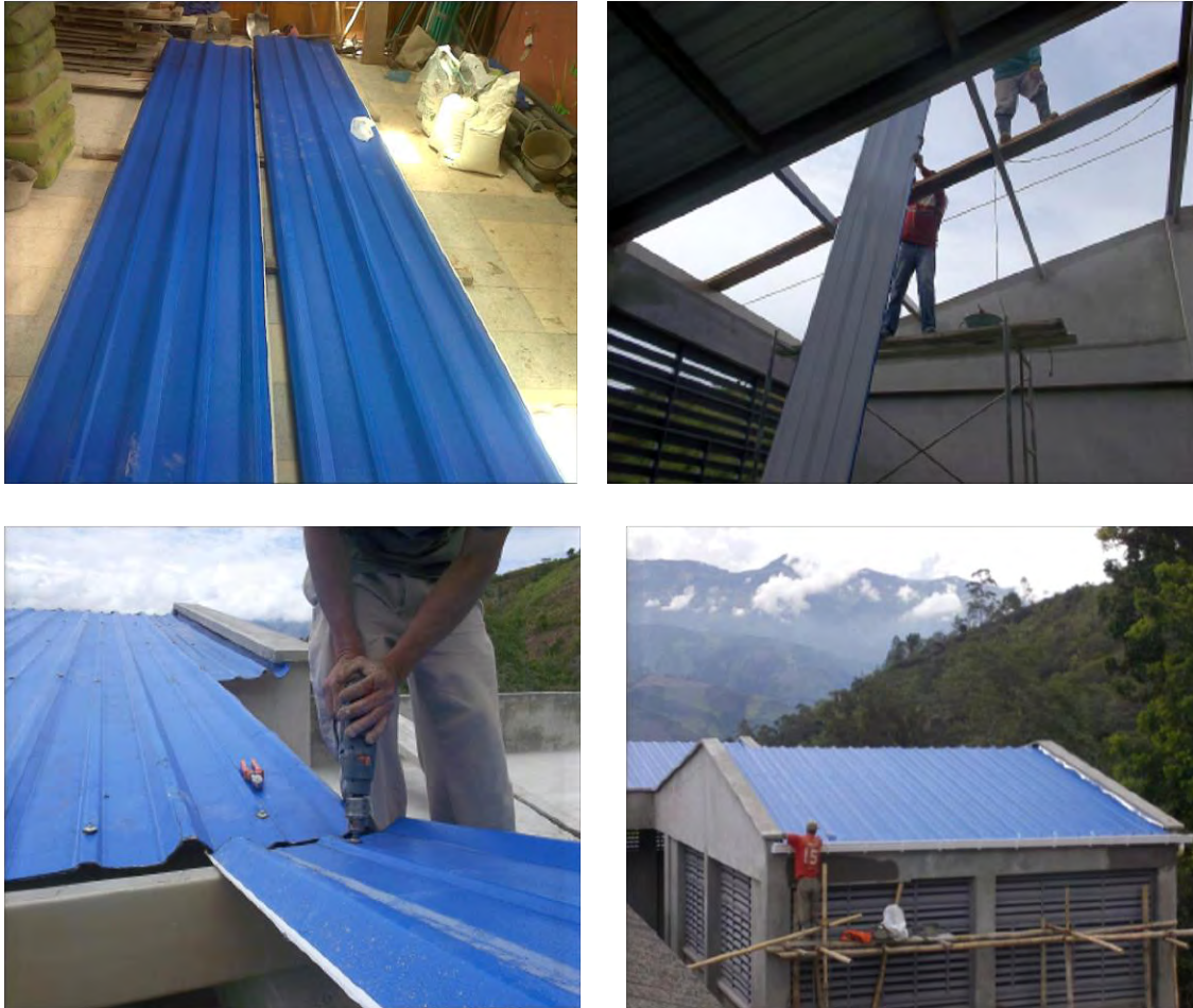
Imagen 48. Instalación teja termo-acústica
