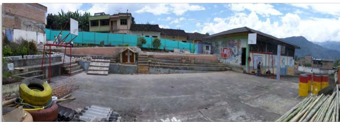
Imagen 2. Estado inicial de la obra
