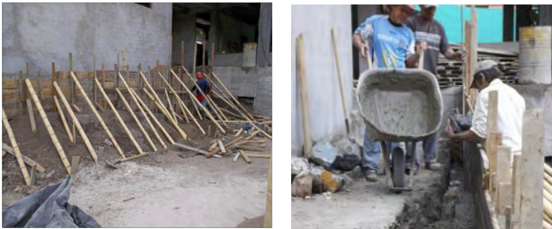
Imagen 24. Fundición concreto ciclópeo
