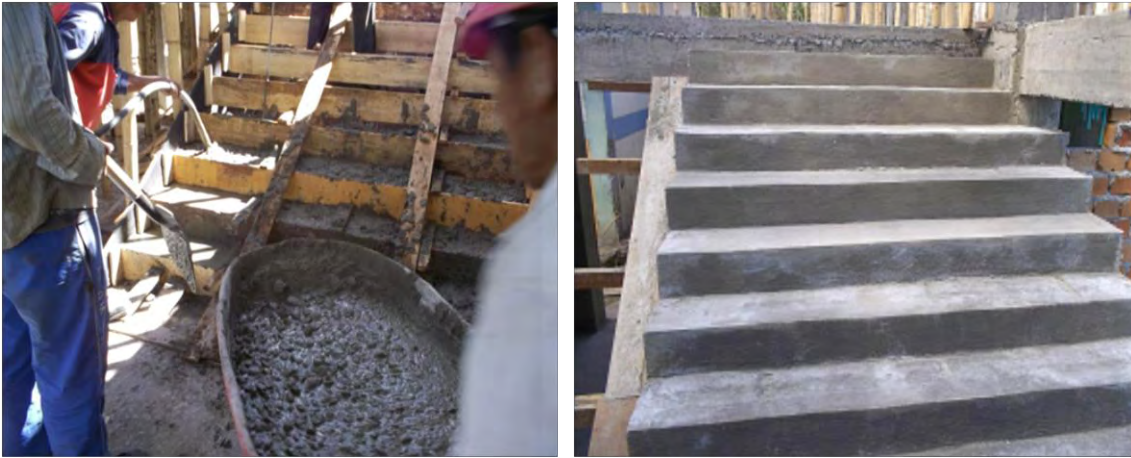
Imagen 20. Fundición de escaleras.
