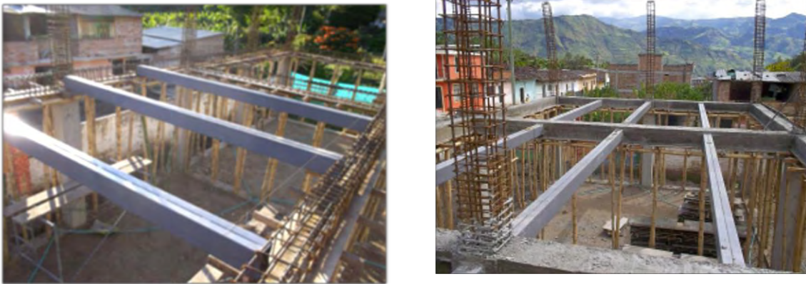
Imagen 26. Instalación de perfilera metálica.
