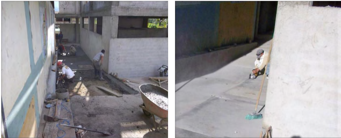
Imagen 23. Fundición placa de andenes
