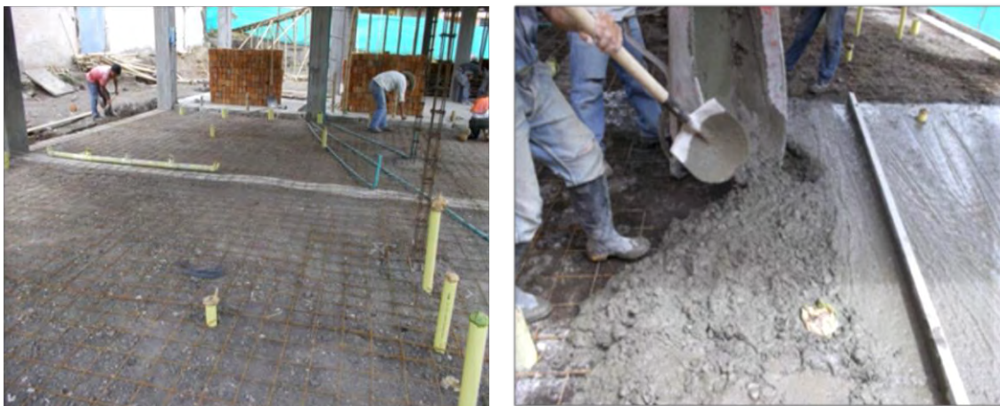
Imagen 21. Fundición placa de pisos
