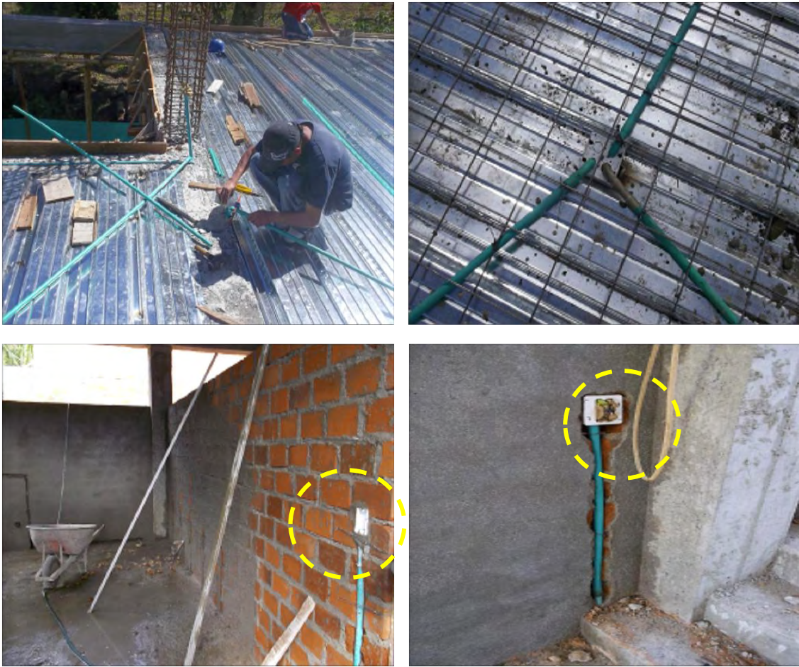
Imagen 41. Instalación tubería conduit
