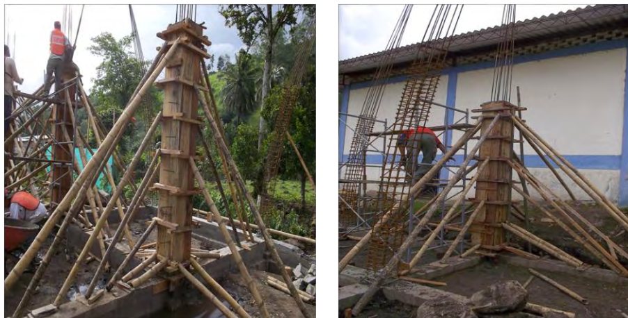
Imagen 13. Encofrado y apuntalamiento de columnas.
