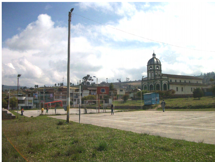
Figura 16. Arquitectura residencial en el centro de Obonuco.
