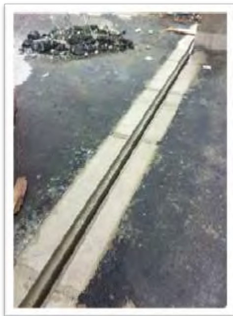
Figura 94: Fundición de concreto hidráulico
