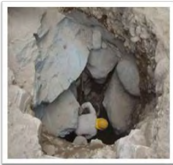
Figura 3: Excavación caissons Eje 1.
