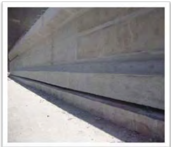
Figura 62: Despegue de la viga tensionada
