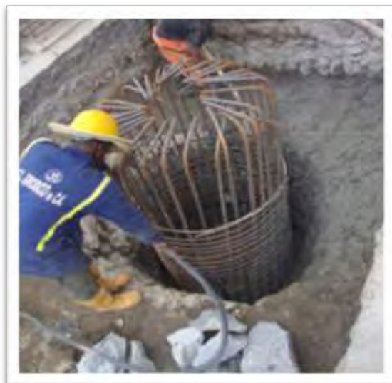
Figura 14: Amarre de acero caisson 3C.
