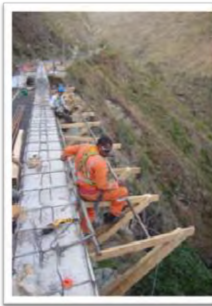
Figura 80: Instalación de palomeras
