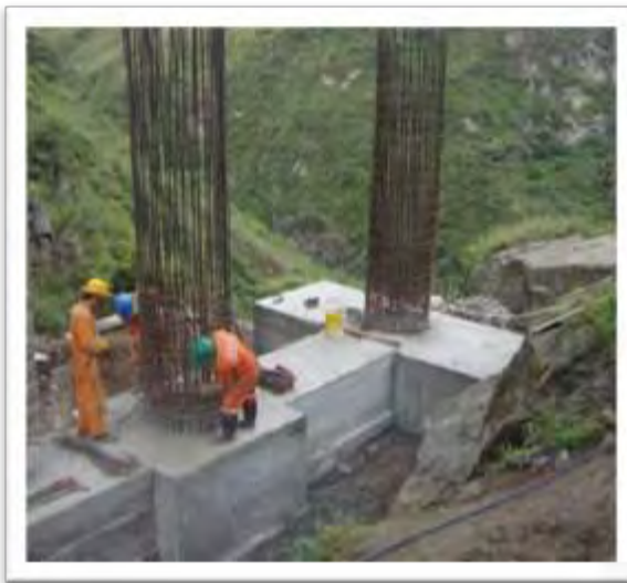
Figura 21: Amarre de acero para columnas
