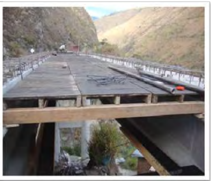
Figura 81: Formaleta entre vigas
