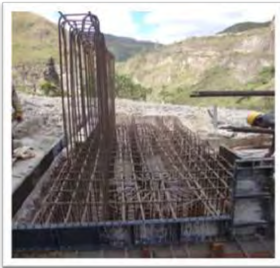
Figura 33: Amarre de acero estribo Eje 3
