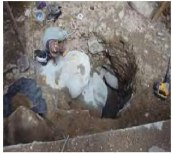
Figura 4: Preparación para la detonación de rocas.
