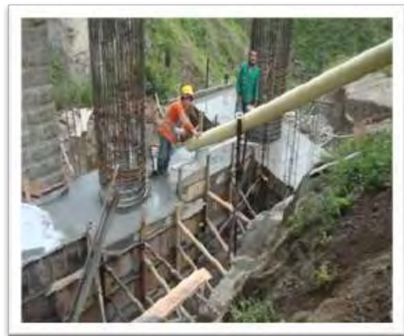
Figura 20: Vaciado de concreto dados y VC1.
