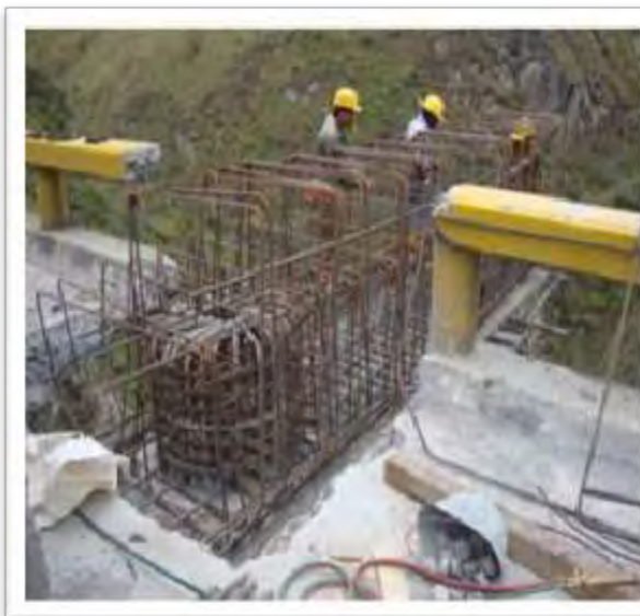
Figura 27: Amarre de acero viga cabezal
