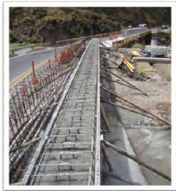
Figura 45: Vaciado de concreto viga 24 A
