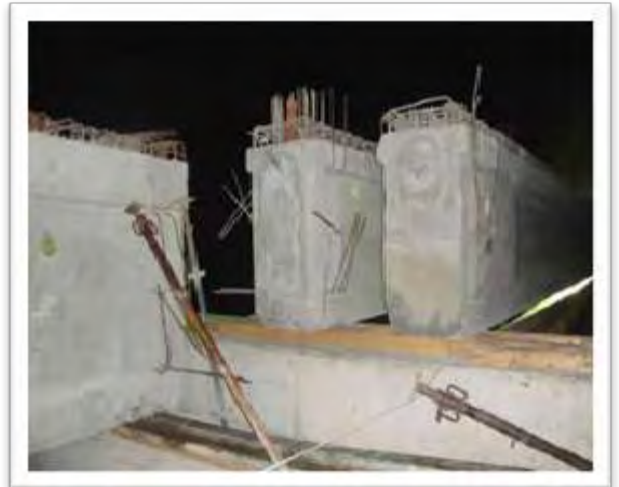
Figura 49: Vigas 24 m sobre viga cabezal.
