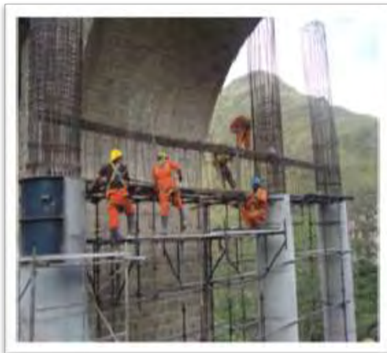
Figura 23: Amarre de acero viga de amarre V1.
