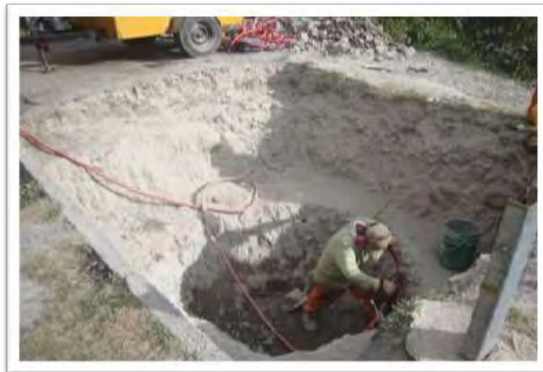
Figura 8: Excavación eje 3A.
