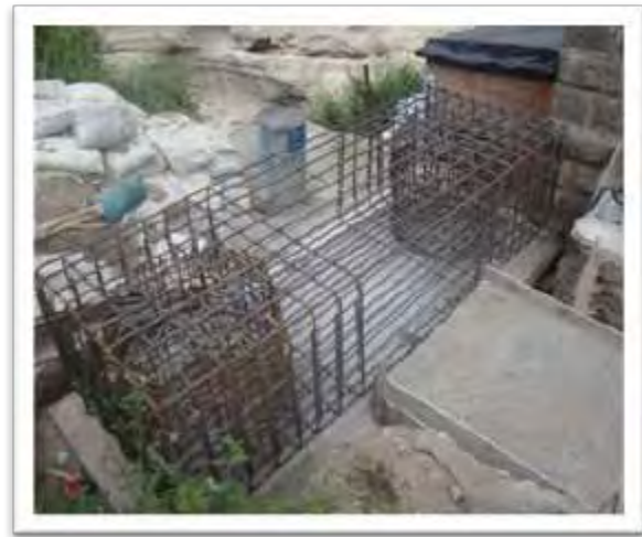
Figura 18: Armado de acero D1.
