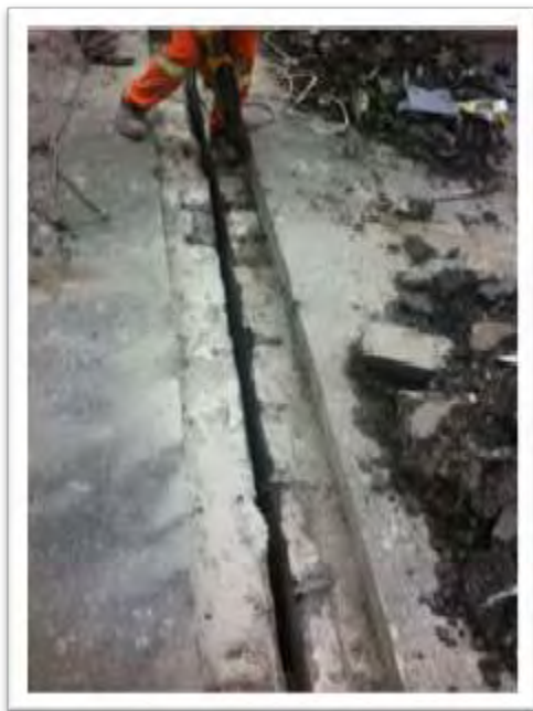
Figura 92: Corte de carpeta asfáltica
