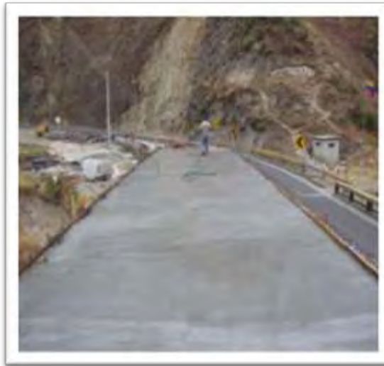
Figura 85: Curado del tablero
