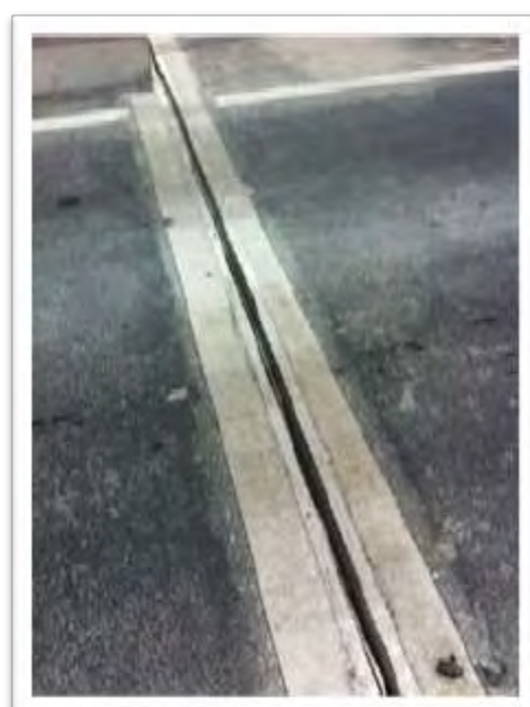
Figura 95: Fundición de concreto elastómero
