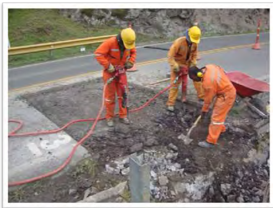
Figura 9: Excavación dado eje 3 en asfalto y roca.
