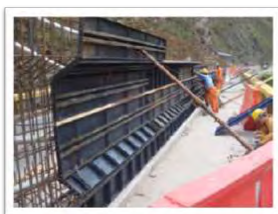
Figura 51: Formaleta lateral viga 39m
