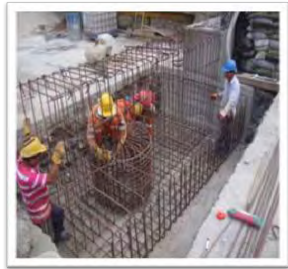
Figura 34: Amarre de acero estribo eje 1
