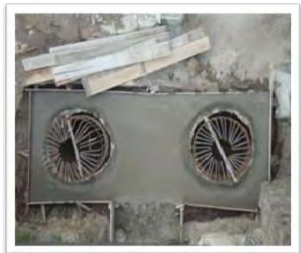
Figura 16: Vista aérea de caissons 2A.
