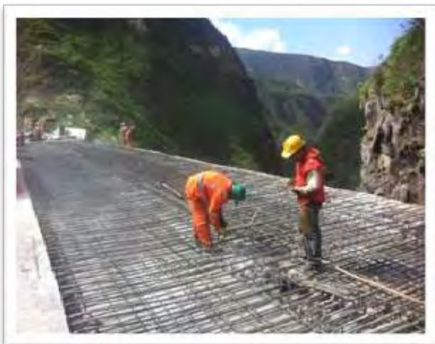
Figura 83: Amarre de acero tablero aguas abajo
