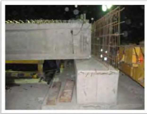
Figura 48: Viga 24 A sobre estribo.
