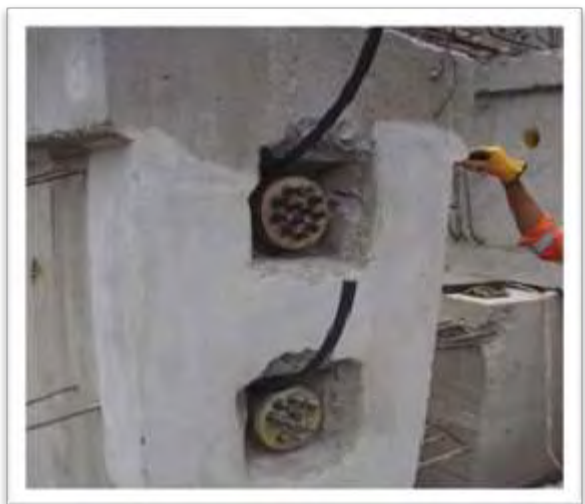
Figura 64: Corte de torones después de tensionados
