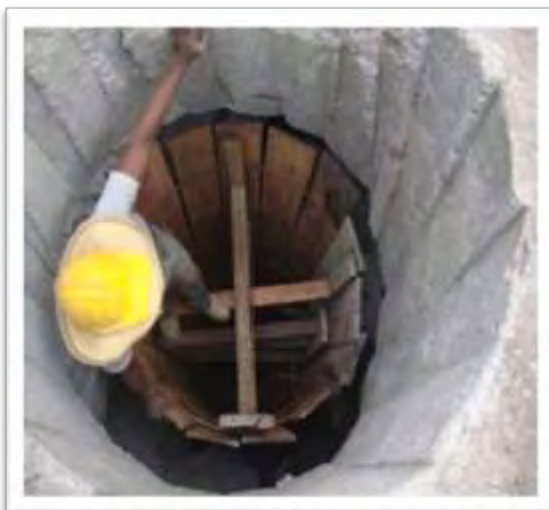
Figura 15: Formaleta de camisa de caisson 1A.
