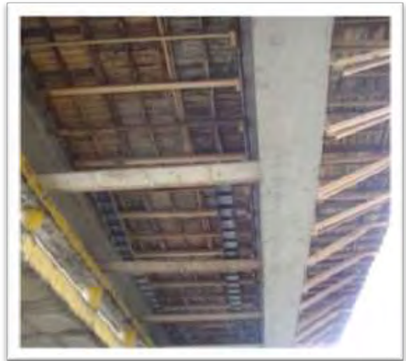
Figura 86: Vista inferior del tablero
