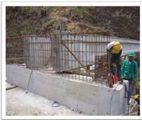
Figura 37: Amarre acero de pantalla espaldar
