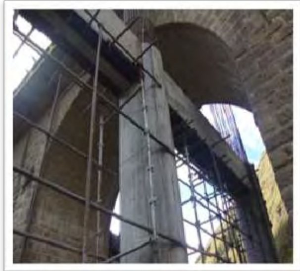
Figura 26: Intersección de nueva con vieja estructura.
