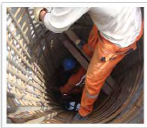
Figura 11: Amarre de acero caisson 1A.
