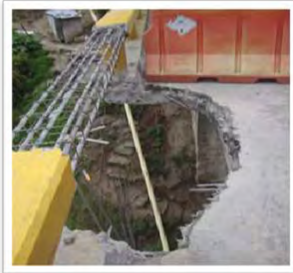
Figura 25: Demolición parcial de tablero y barrera
