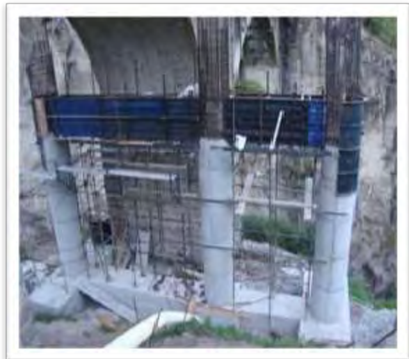
Figura 24: Formaleta de viga V1.
