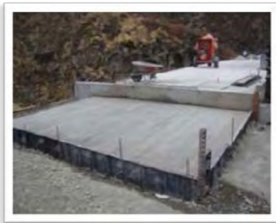
Figura 79: Fundición placa de aproximación
