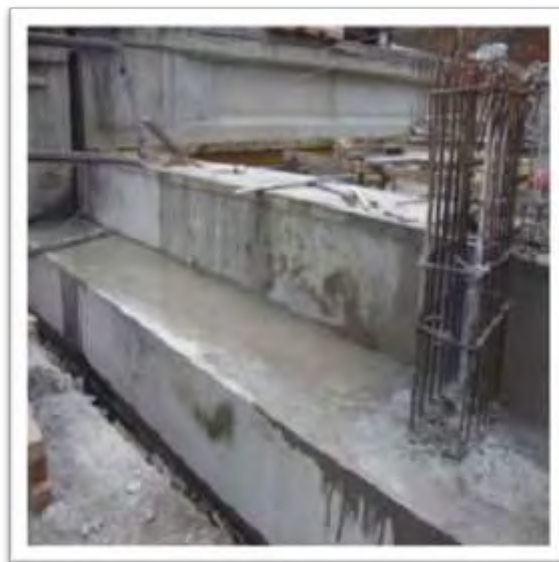
Figura 32: Curado de viga cabezal
