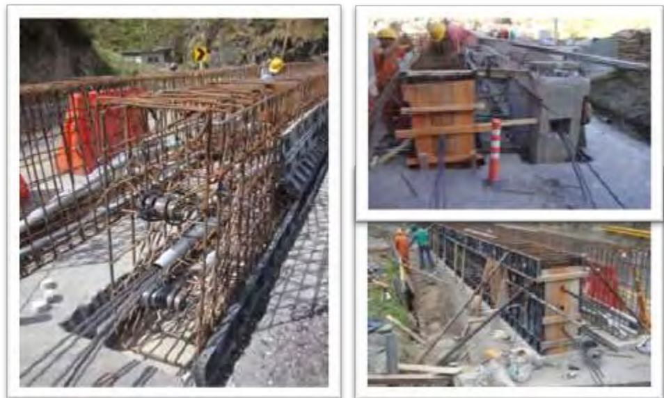
Figura 43: Formaleta vigas 24m ejes A y B
