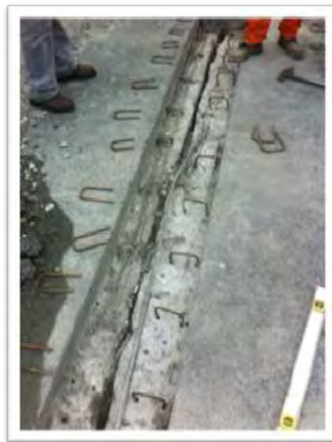
Figura 93: Instalación de ganchos
