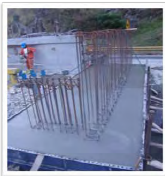
Figura 67: Refuerzo para tope sísmico.
