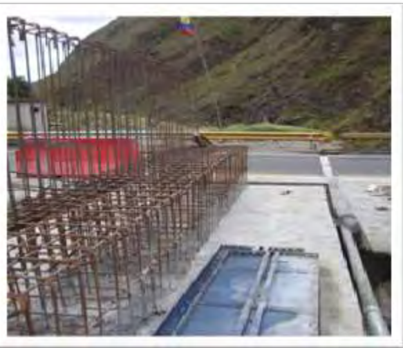
Figura 36: Amarre de acero silleta estribo eje 1
