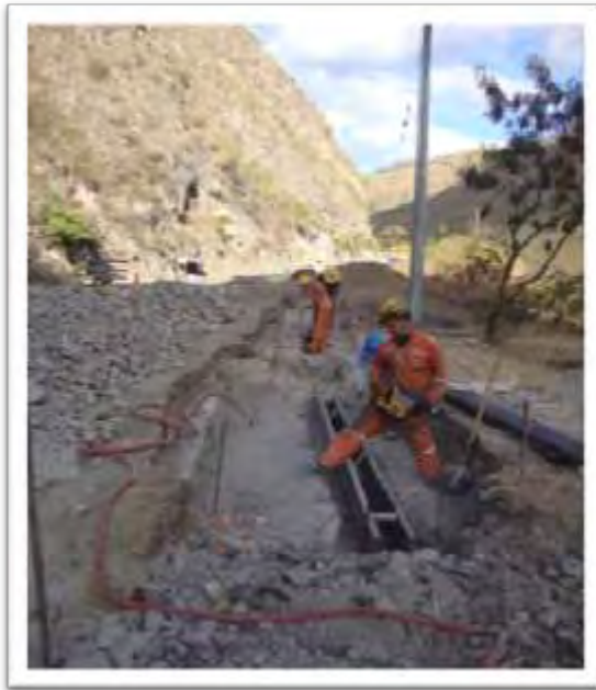
Figura 68: Excavacion para muros de contencion
