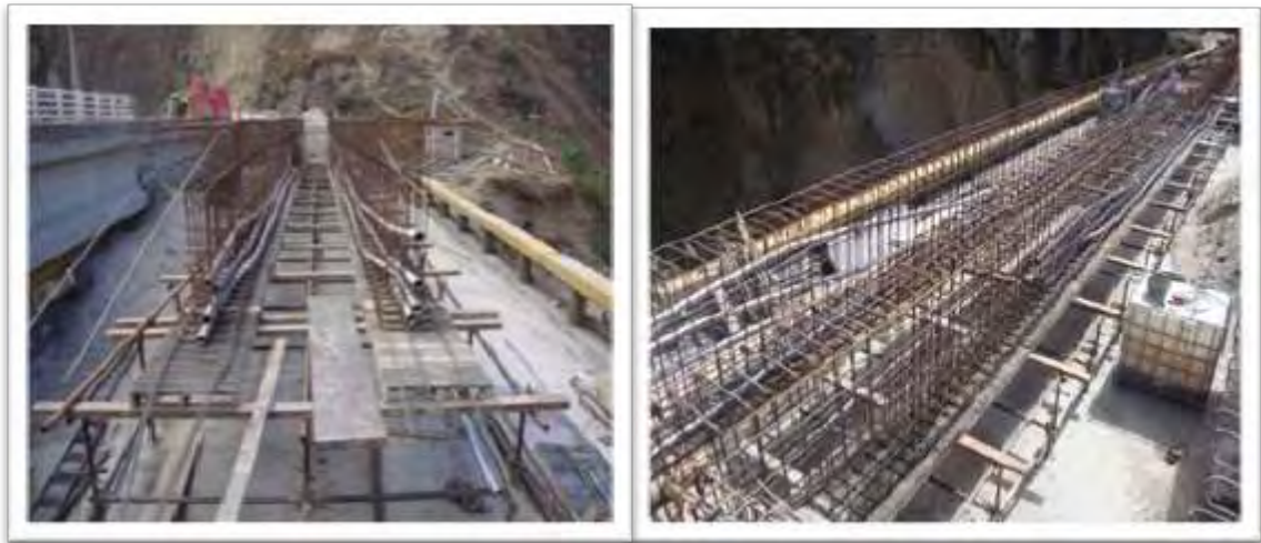
Figura 58: Amarre de acero e instalación de ductos vigas 24m ejes C y D.
