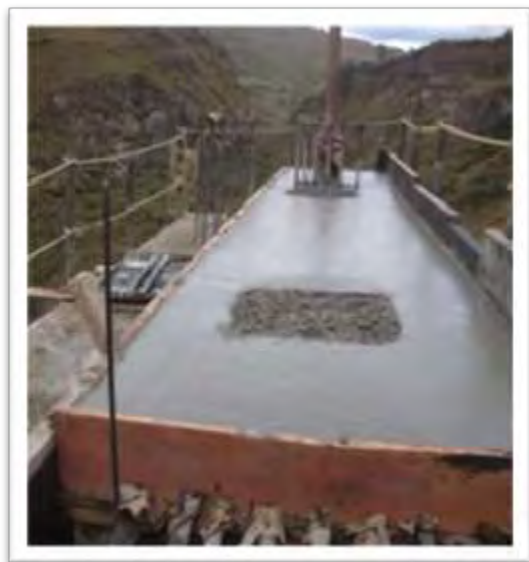
Figura 31: Fundición viga cabezal
