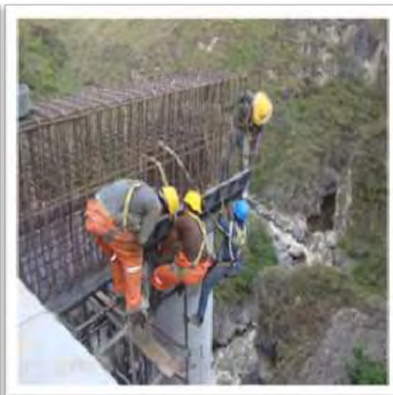
Figura 28: Formaleta viga cabezal
