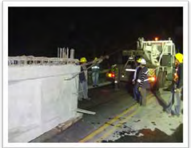
Figura 47: Grúa macho trasladando viga de 24 m.
