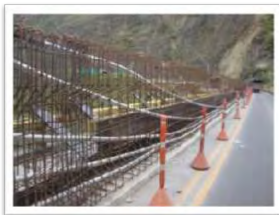
Figura 50: Instalación de ductos viga 39m
