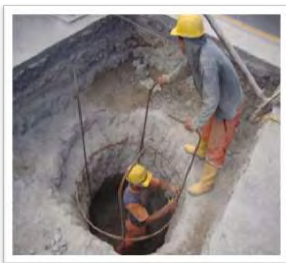
Figura 13: Amarre de acero caisson 3B.
