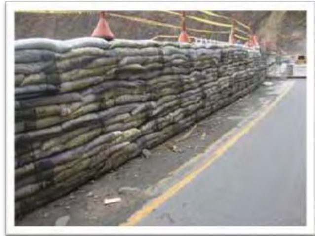
Figura 77: Terminado en geomalla.
