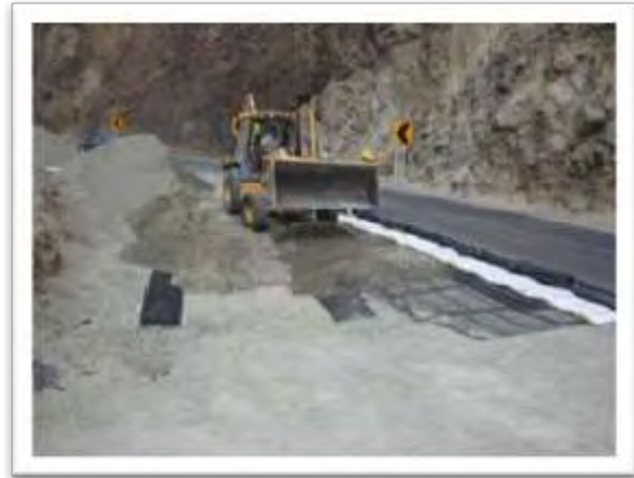
Figura 75: Riego de material
