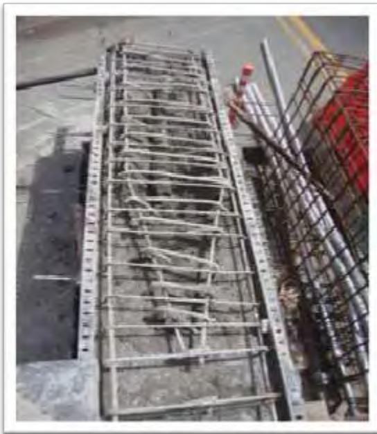
Figura 44: Vaciado de concreto extremo de viga
