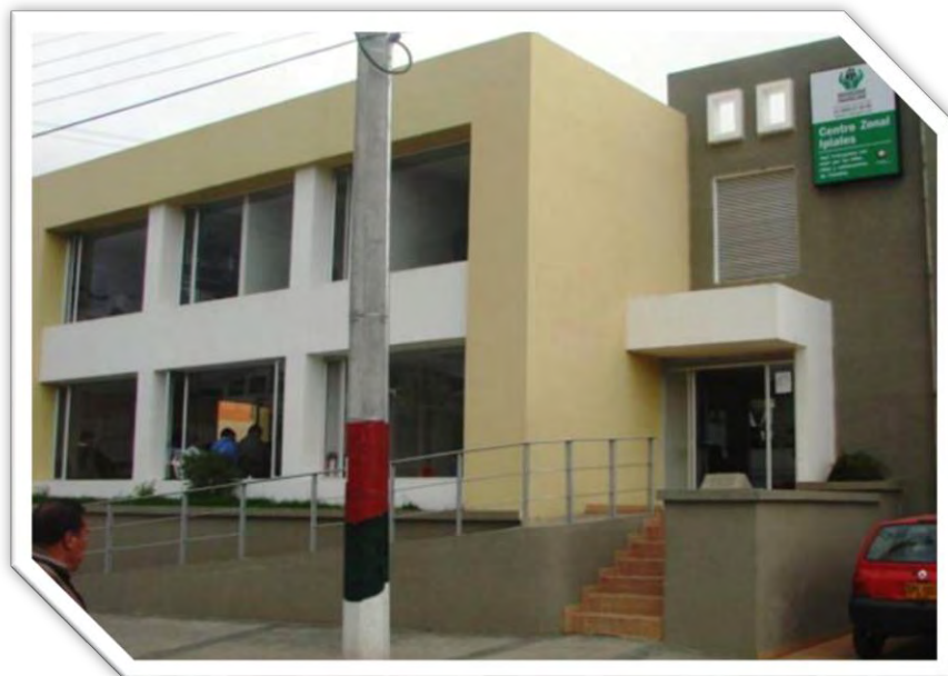
Figura 1. Instalaciones ICBF Centro Zonal Ipiales
