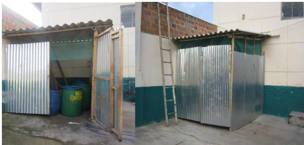
Imagen 3. Sala de almacenamiento de residuos
