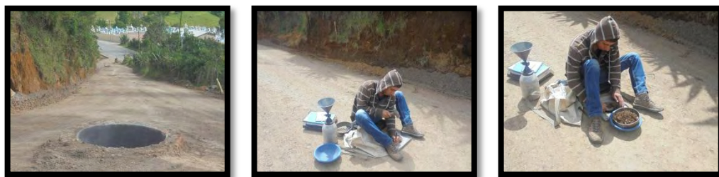
Figura 62. Toma de densidades después de la compactación.
