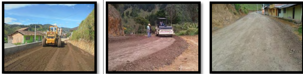
Figura 60. Extensión y compactación del material de base granular
