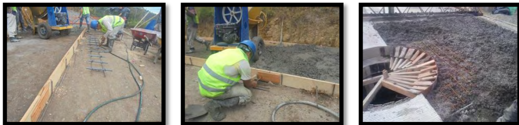
Figura 66. Dovelas, barras de anclaje y mallas electrosoldadas.
