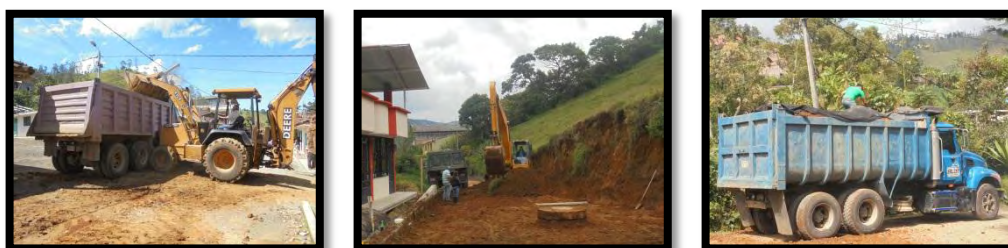
Figura 54. Desalojo del material de excavación.
