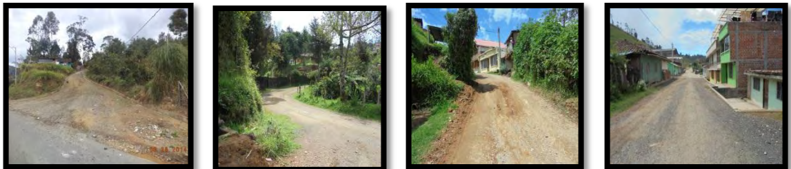
Figura 46. Tramo 1- calle 2da antes de la intervención.
