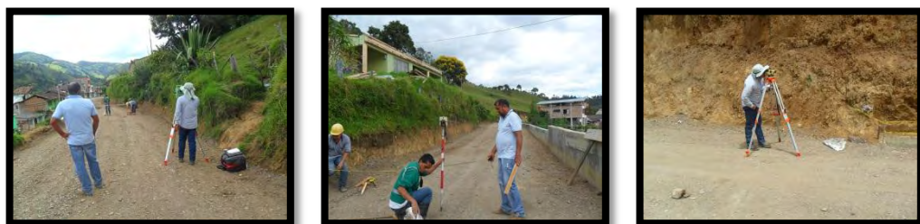
Figura 50. Localización y replanteo de la vía.
