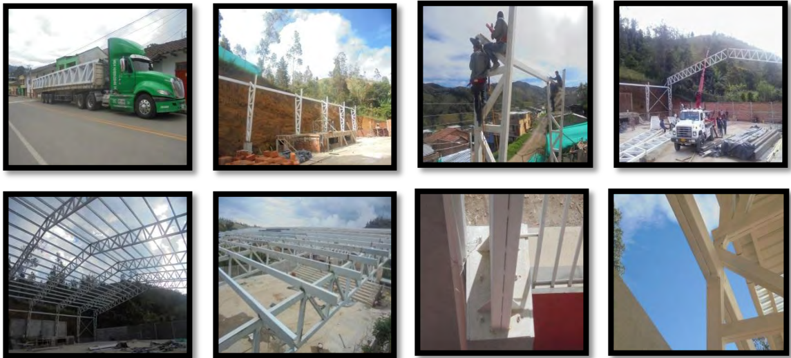
Figura 30. Instalación de la estructura de cubierta - CIC.
