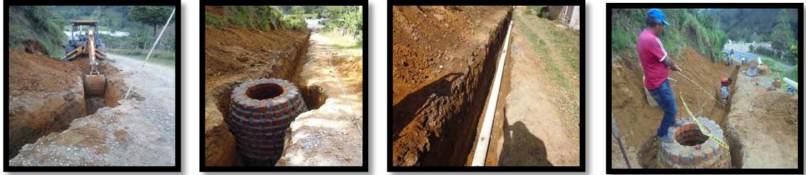
Figura 57. Construcción de un tramo de alcantarillado.
