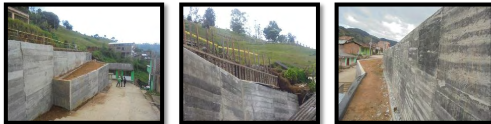
Figura 56. Muros de contención escalonados.
