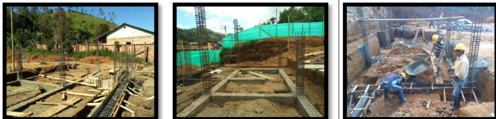
Figura 17. Vigas de cimentación en camerinos y tarima - CIC.
