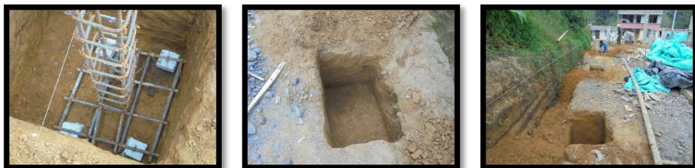
Figura 15. Zapatas para las columnas del muro de cerramiento - CIC.
