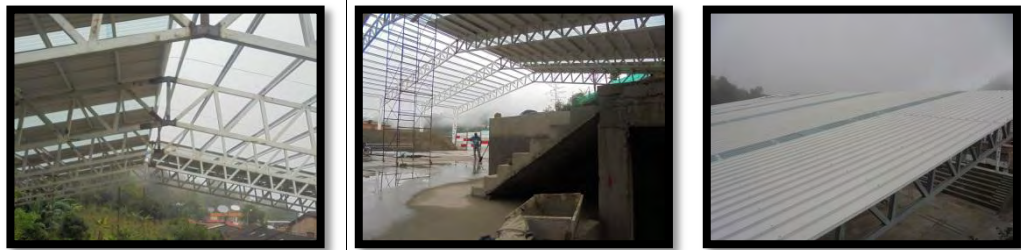
Figura 31. Cubierta en teja de PVC.
