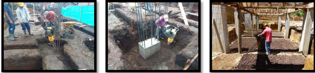
Figura 10. Relleno de cimientos con material seleccionado - CIC.
