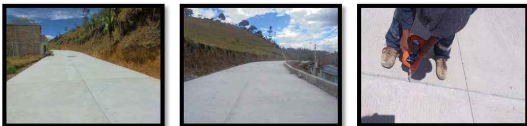
Figura 72. Junta longitudinal y adición de vulken.
