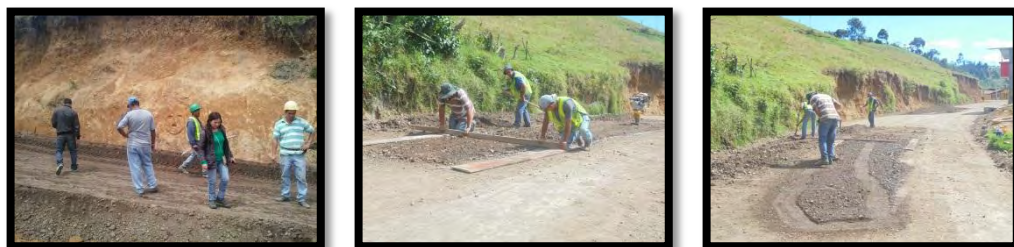
Figura 63. Inspección y corrección de los tramos acolchonados.
