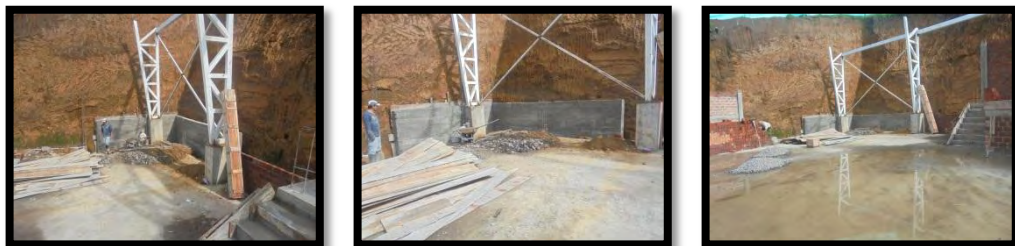
Figura 18. Muro de contención - CIC.
