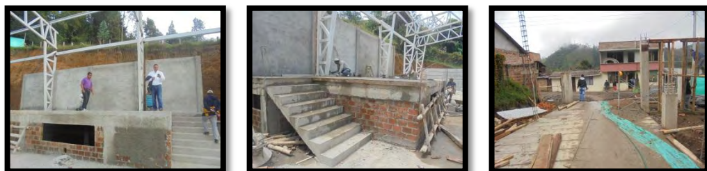
Figura 27. Escalones aislados y rampas de acceso – CIC.
