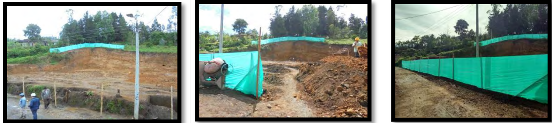
Figura 7. Polisombra instalada en la obra del CIC.
