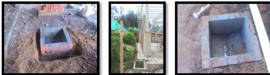
Figura 38. Cajas de inspección.
