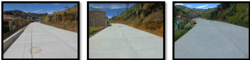
Figura 80. Estado actual: tramo 2.
