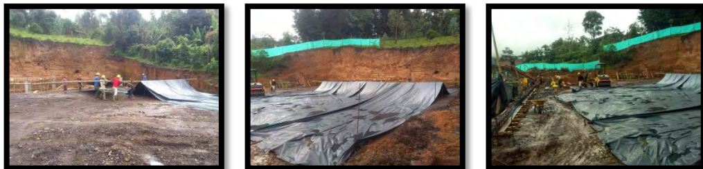
Figura 12. Protección de la base granular – CIC.
