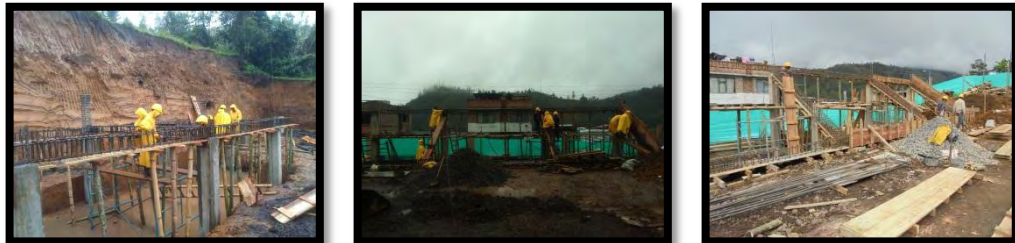
Figura 23. Vigas aéreas e inclinadas - CIC.
