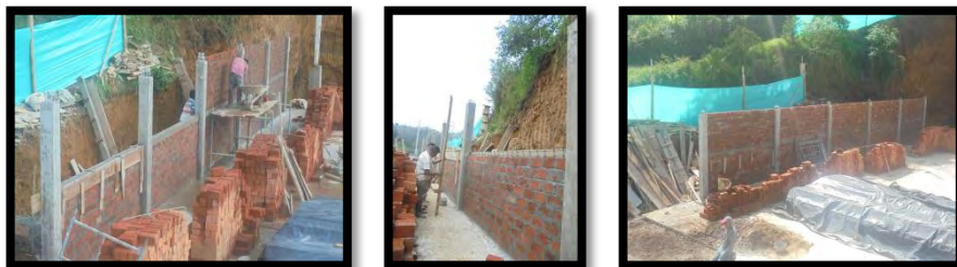
Figura 24. Viguetas de confinamiento en muros – CIC.
