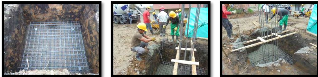
Figura 14. Zapatas pedestales en concreto - CIC.
