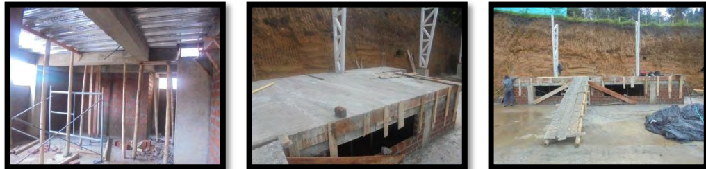
Figura 25. Losa de tarima y lámina de acero preformada - CIC.
