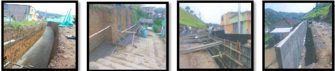
Figura 55. Proceso de construcción de muros de contención.
