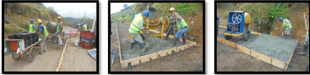
Figura 67. Concreto elaborado en la obra y vibración del mismo.
