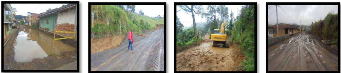
Figura 58. Inconvenientes generados por la lluvia.
