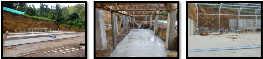
Figura 22. Placas en concreto del polideportivo, oficina y pisos – CIC.
