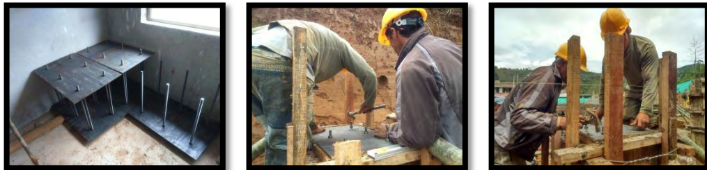
Figura 20. Instalación de platinas en columnas pedestales – CIC.
