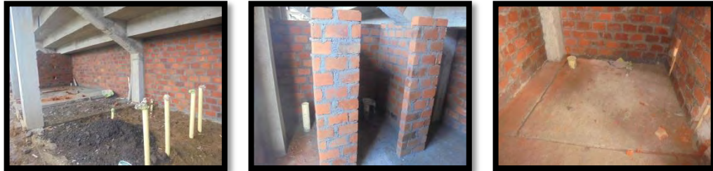
Figura 36. Puntos sanitarios de 2" y 4" PVC.
