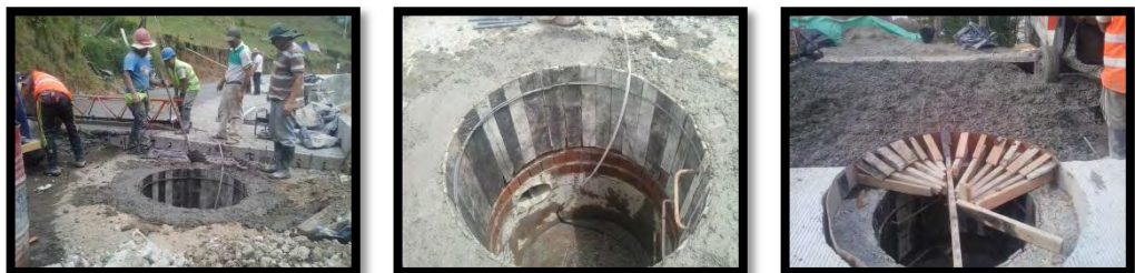
Figura 75. Terminación de cámaras.
