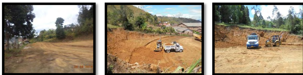
Figura 6. Terreno antes y después de la adecuación.
