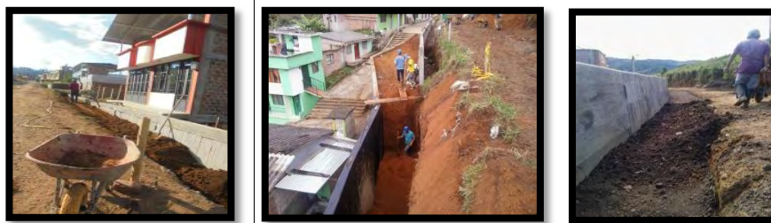
Figura 53. Rellenos realizados con material seleccionado.
