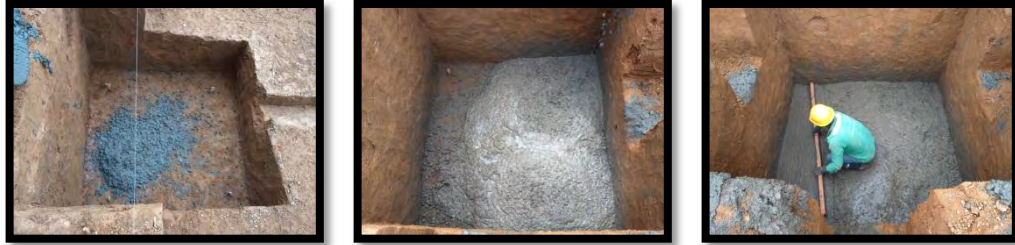
Figura 13. Solado de limpieza - CIC.
