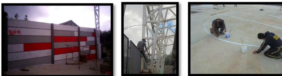
Figura 43. Pintura de muros, estructura metálica y polideportivo.
