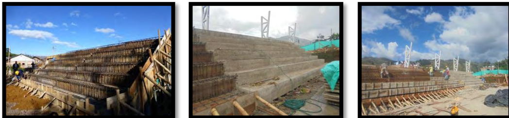
Figura 26. Graderías construidas en el CIC.
