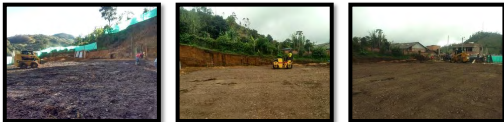
Figura 11. Proceso de instalación de la base granular - CIC
