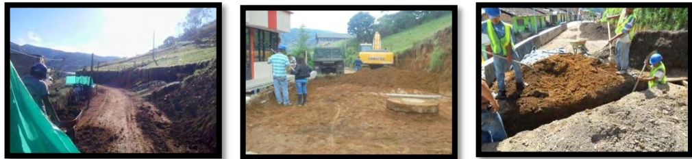
Figura 51. Excavaciones varias realizadas.
