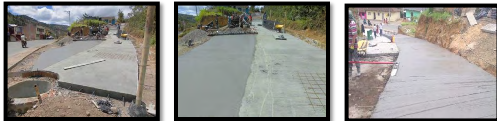
Figura 79. Estado actual: tramo 1.
