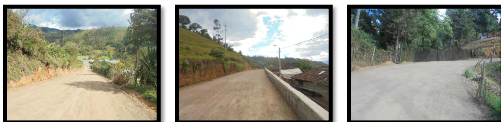
Figura 64. Tramos compactados y sellados, listos para toma de densidades.
