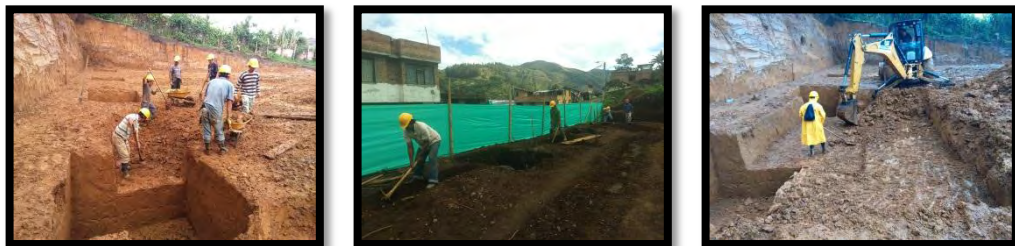
Figura 8. Excavación manual y con maquinaria pesada realizada en el CIC.
