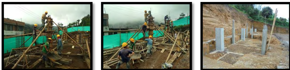
Figura 21. Columnas en concreto - CIC.
