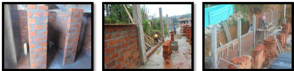
Figura 32. Muro en saga ladrillo común - CIC.
