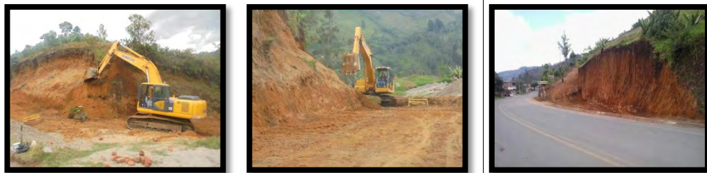
Figura 52. Maquinaria realizando el corte del talud.
