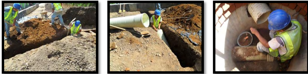
Figura 76. Excavación e instalación de tubería para sumideros.
