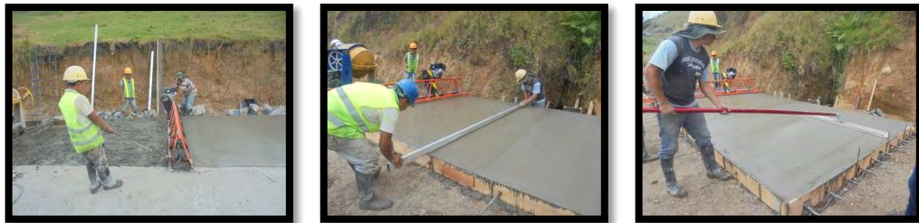
Figura 69. Enrasado con regla vibratoria y acabado con codal metálico y flotador.
