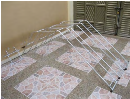
Fotografía 33. Cuatro secciones de la estructura
