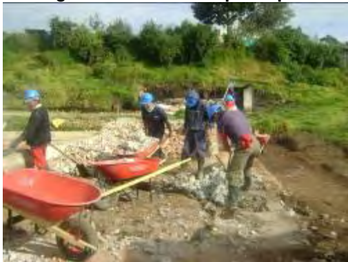
Figura 5. Demolición placa piso
