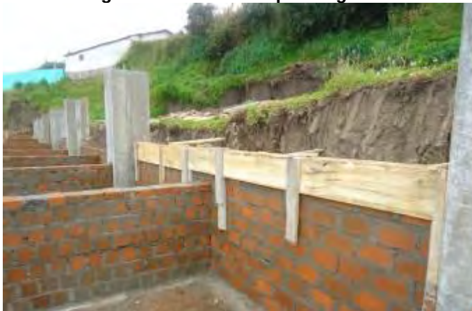
Figura 43. Formaleta para viguetas
