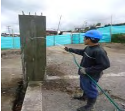
Figura 21. Curado pedestal polideportivo
