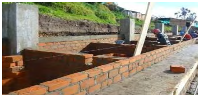
Figura 42. Muro en soga contrahuella graderías
