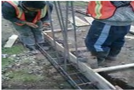
Figura 56. Amarrado del hierro para las vigas de cimentación y columnas
