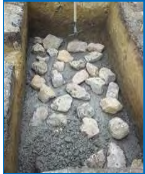
Figura 8. Mejoramiento ccto ciclópeo
