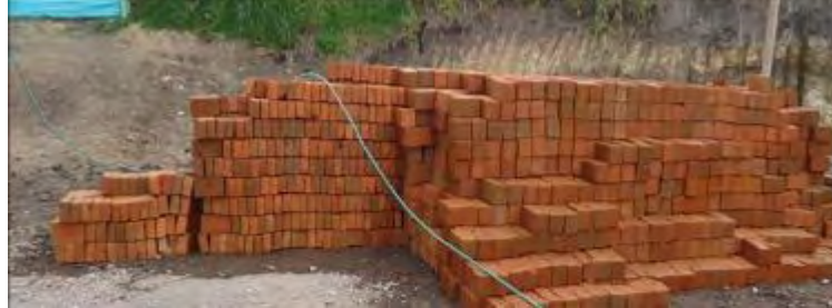
Figura 40. Humedecimiento de ladrillo para la pega de mampostería
