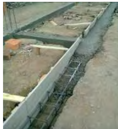
Figura 53. Viga de cimentación fundida
