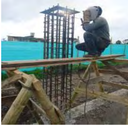
Figura 36. Soldada de pernos al refuerzo de pedestales
