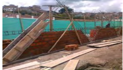
Figura 57. Pega de mampostería como base para armado y fundición de viga cerramiento
