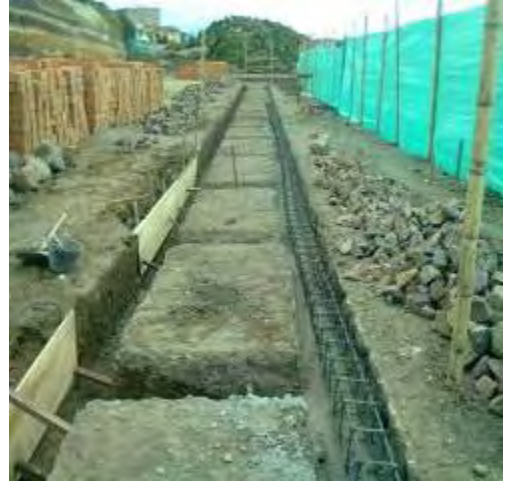
Figura 14. Armado del hierro vigas de cimentación graderías
