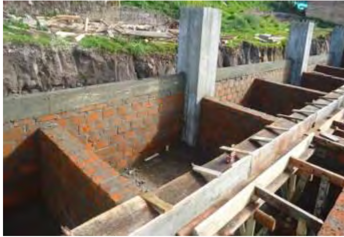
Figura 45. Detalle vigueta terminada, muro en tizón y formaleta para viga de apoyo para contrahuella
