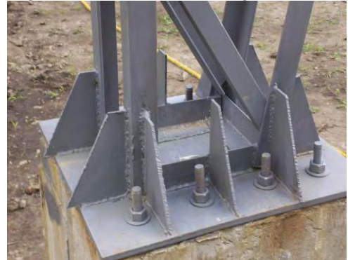
Figura 39. Platina de anclaje instalada
