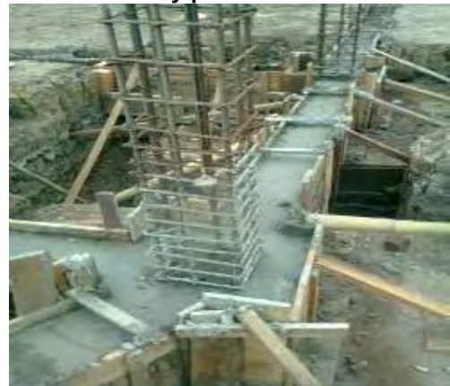
Figura 12. Fundición vigas de cimentación y pedestal
