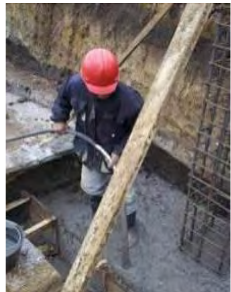
Figura 10. Mejoramiento ccto ciclópeo
