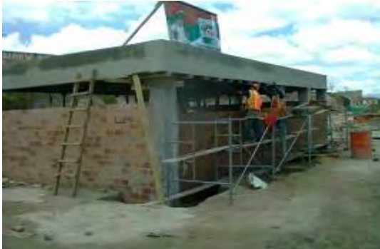
Figura 54. Pega mampostería bloque de batería sanitaria
