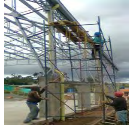
Figura 62. Instalación canal y bajantes cubierta
