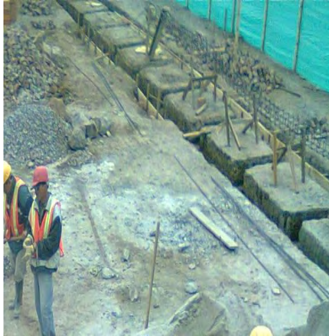
Figura 13. Excavación para cimiento en ccto ciclópeo
