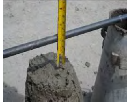
Figura 25. Medida del asentamiento
