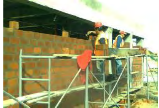
Figura 55. Pega mampostería bloque de batería sanitaria
