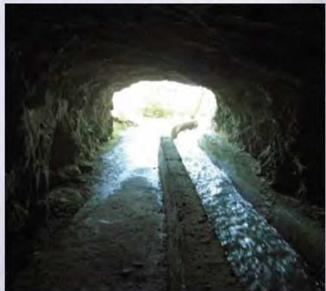
Foto 16: Sistema de canalización corrientes subterráneas mina la Esperanza foto: John Zambrano - A.R.M. Proyecto comercio justo.
