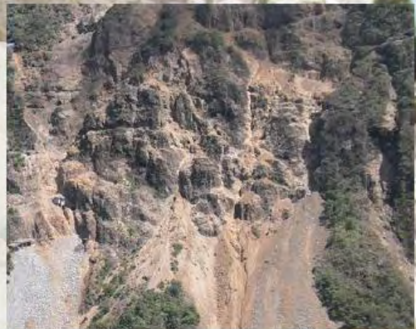
Foto 19: Erosión por descargues mina El Canada.. foto: Arturo Yela - Esta investigación.
