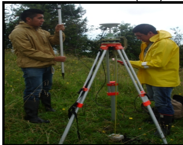
Fotografía 2.11. Instalación GPS RTK (Base) en PL.-3.
