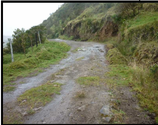
Fotografía 2.14. Vía Dolores – Peña Blanca (subrasante)
