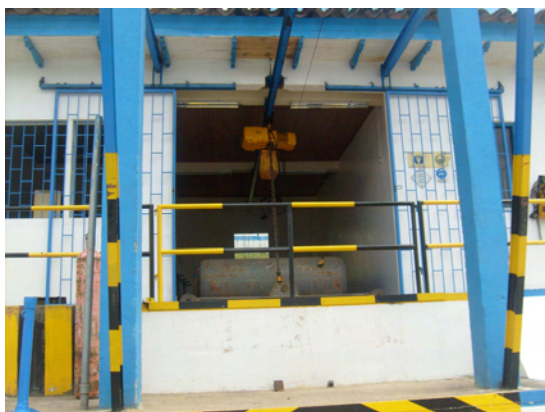
Grafica 17. Plataforma de cargue y descargue de cilindros de cloro gas
