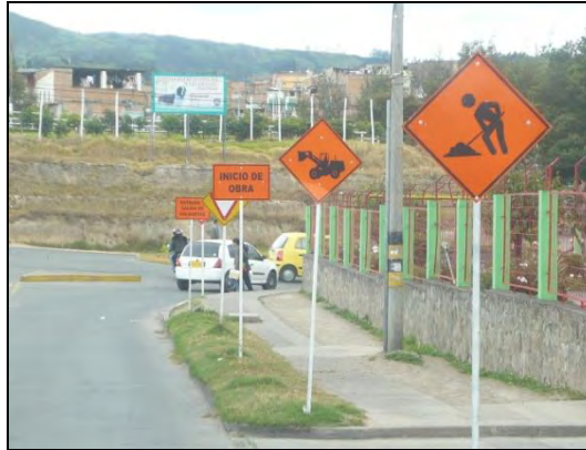
Obra. Construcción del Colector Sur Oriental Fase 2 (Avenida Idema desde la KR. 4
