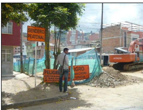
Obra. Construcción Colector Separado Pinos del Norte. KR 44 entre Calles 10 B y 10 C
