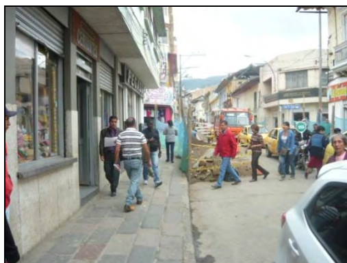
Obra. Reposición de Redes de Acueducto-Alcantarillado y Pavimentación Calle 16 entre KR 21 A y 24
