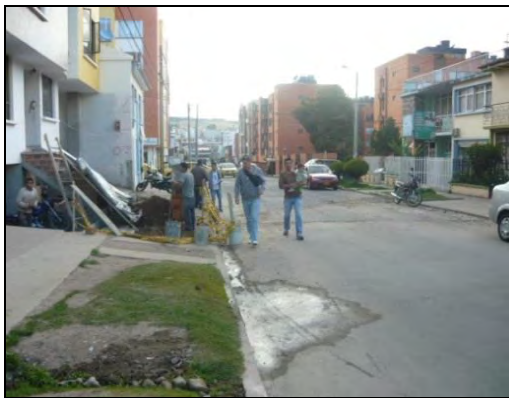
Figura 65. Cierre de andenes sin señalización
