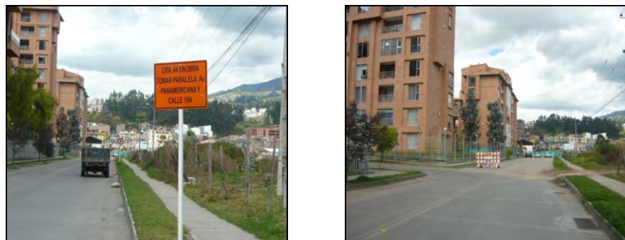
Obra. Construcción Colector Separado Pinos del Norte. KR 44 entre Calles 10 B y 10 C
