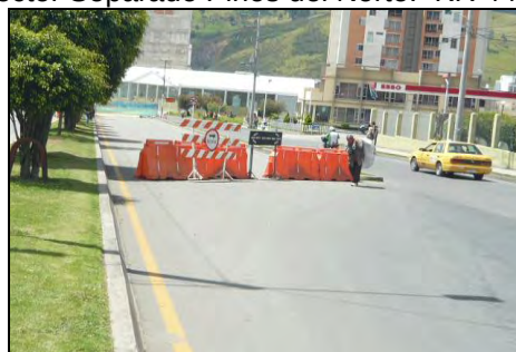
Obra. Intersección Vial Banderas.
