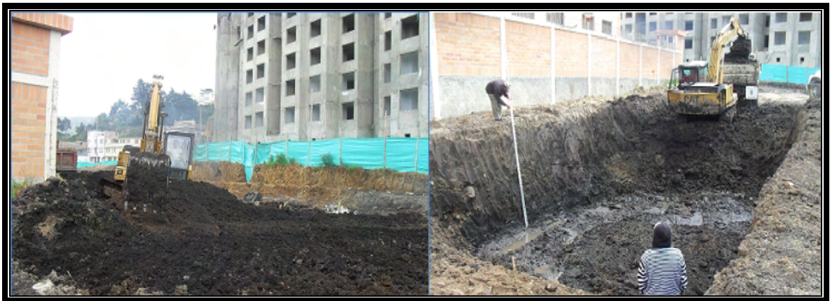
Figura 5 Cajeo intersección ejes 1-2-3, chequeo de cortes eje 3
