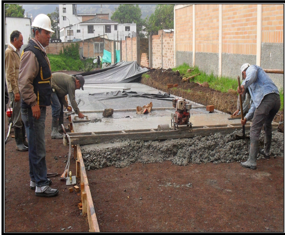
Figura 41 Vaciado de la mezcla de concreto eje 3
