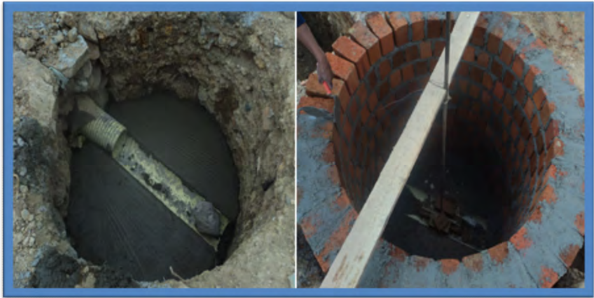
Figura 13 Fundición de solado / mampostería en cámara 2 mortero 1:3
