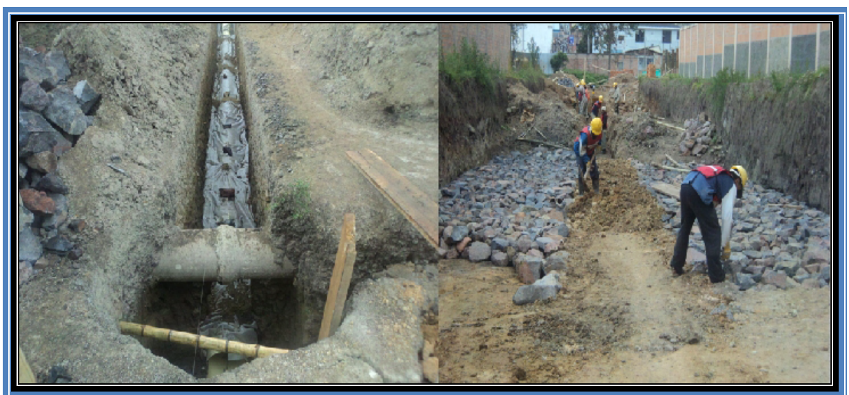
Figura 20 Geotextil y relleno cámaras pluviales P7 – P8
