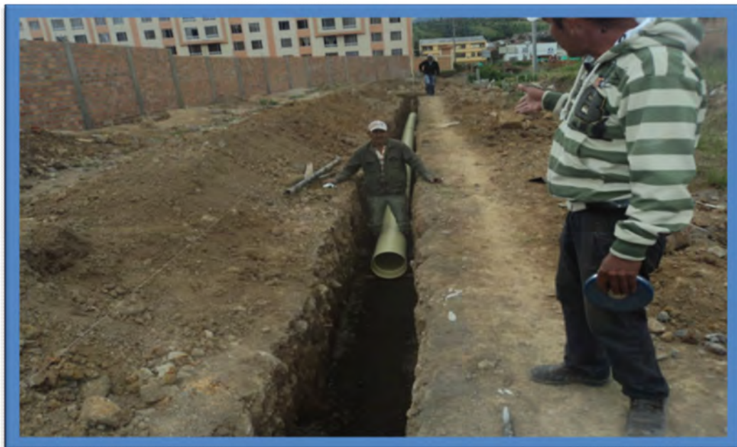
Figura 12 Tendido de tubería de P1-P2
