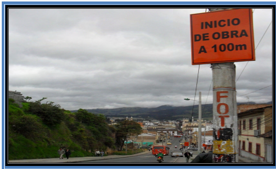
Figura 2 Señalización sobre la vía – carrera 24
