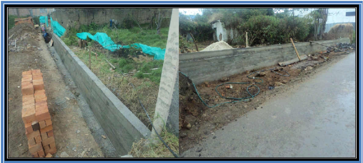
Figura 30 Acabados finales muro en concreto ciclópeo
