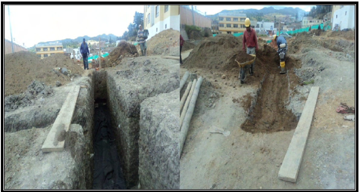
Figura 24 Geotextil y material de relleno cámaras sanitarias S1 – S2
