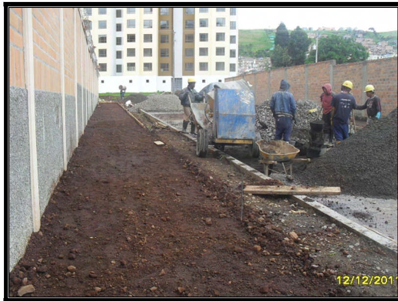
Figura 45 Conformación de base para andenes eje 3 margen derecho.
