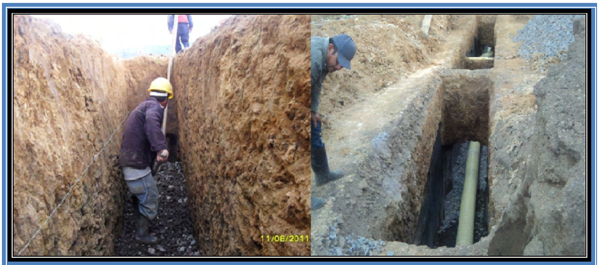
Figura 18 Tendido de geotextil y alineamiento de tubería P6-P7
