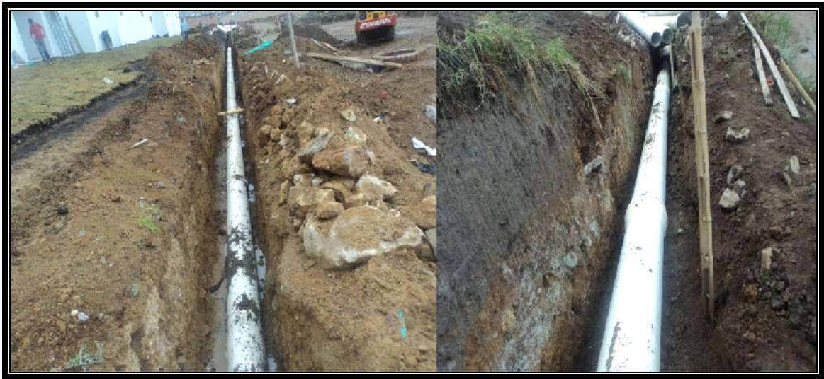
Figura 49 Alineamiento de tubería de 16" en PVC
