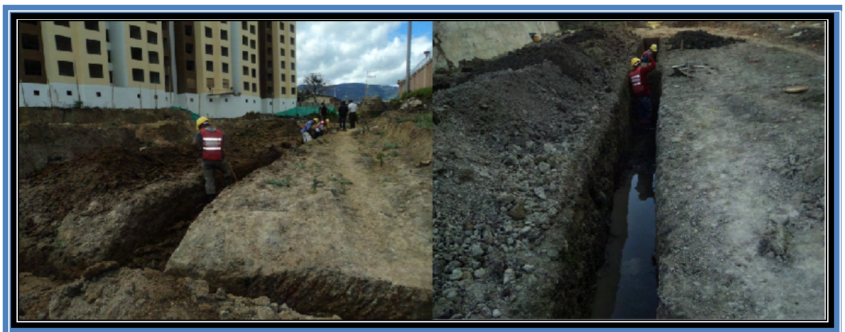
Figura 17 Excavación P6 – P7 / presencia de nivel freático
