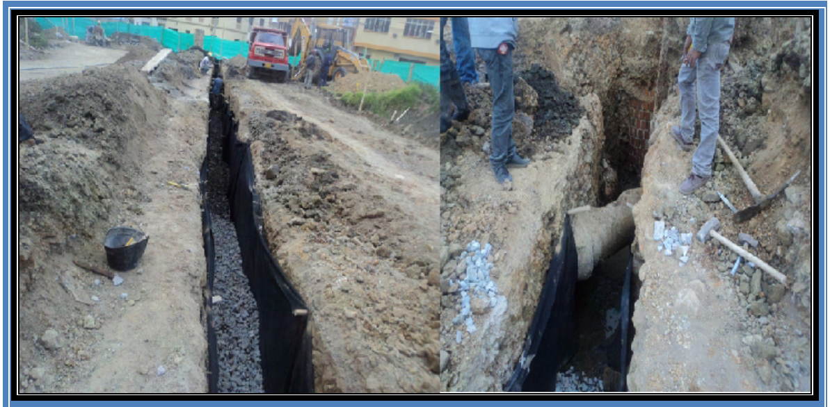
Figura 26 Tendido de geotextil y encamado en triturado
