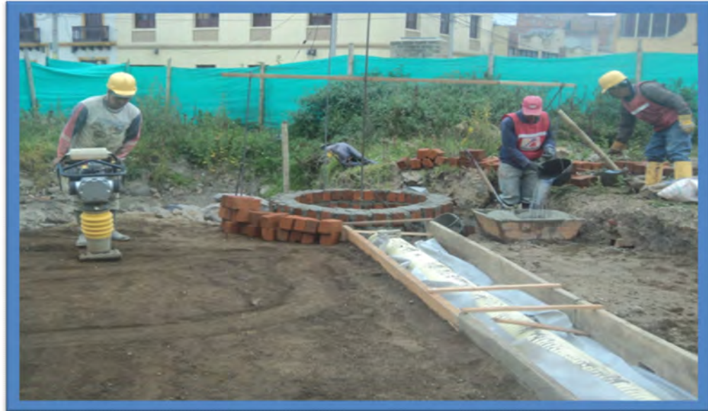
Figura 16 Mejoramiento y compactación al lado de formaleta P5-P6
