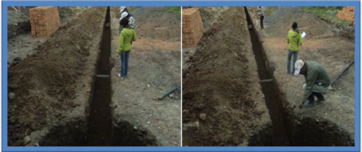
Figura 11 Excavación P1 – P2 / medidas excavación
