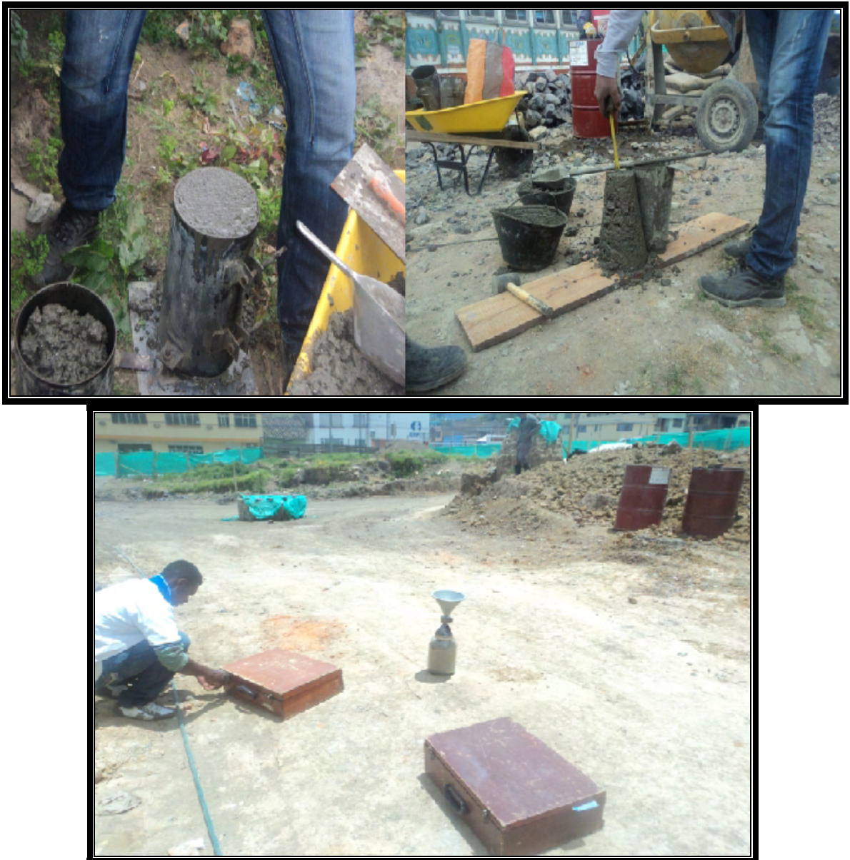
Figura 31 Ensayos efectuados en campo
