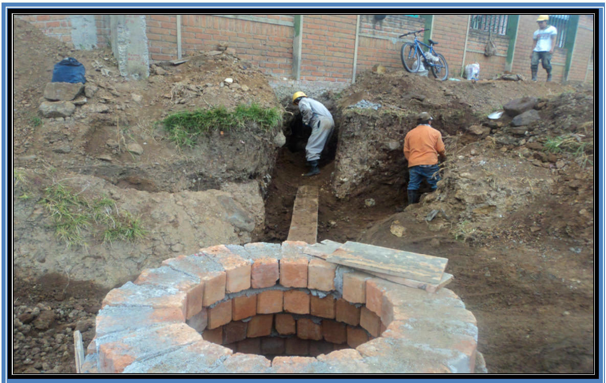
Figura 25 Relleno cámaras S1 y S existente Aquine
