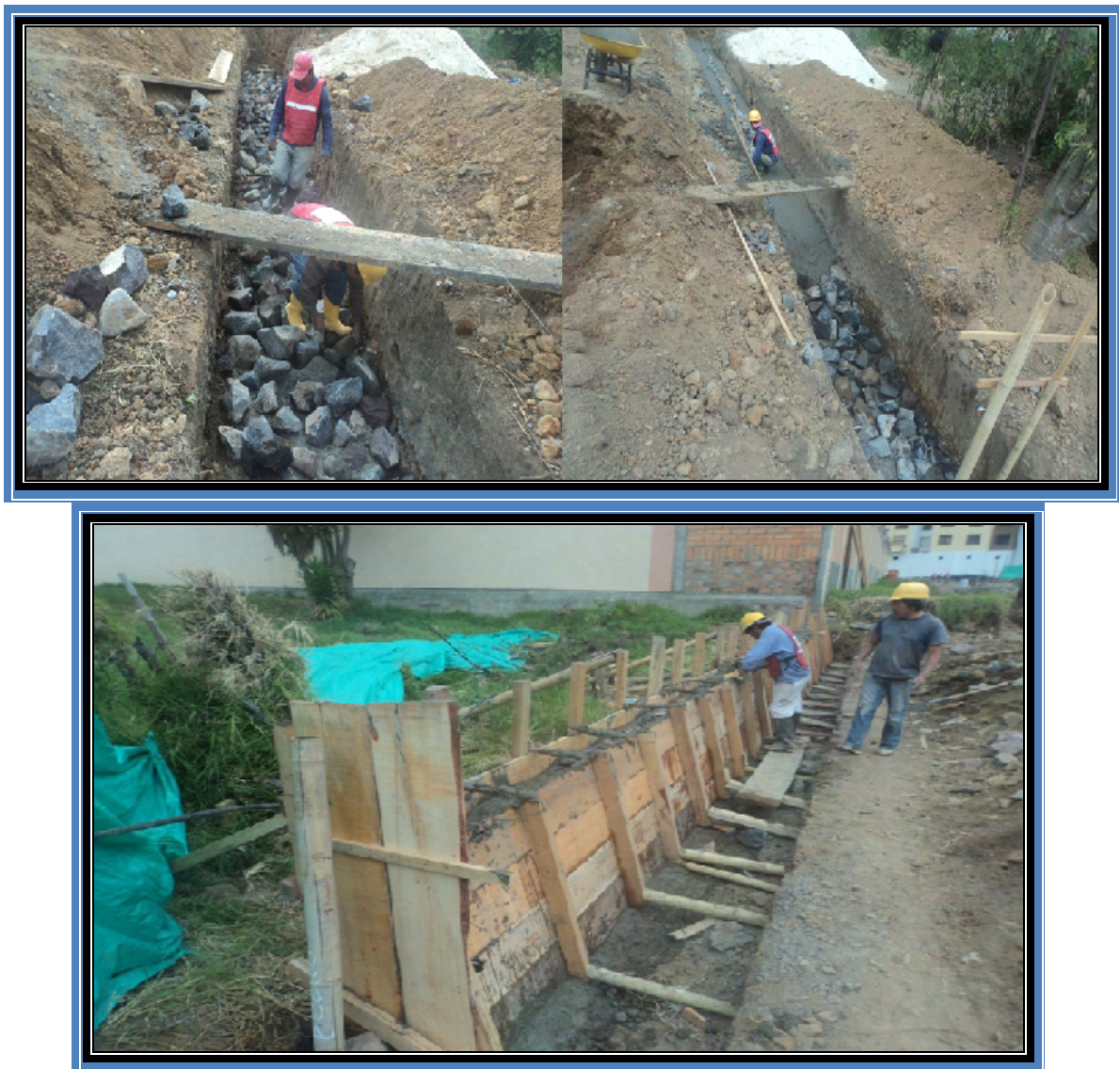
Figura 29 Fundición de zarpa, encofrado y fundición de cuerpo
