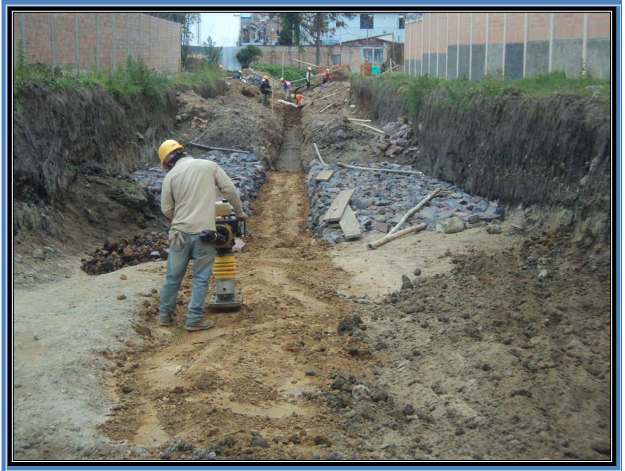
Figura 21 Compactación cámaras pluviales P7 – P8
