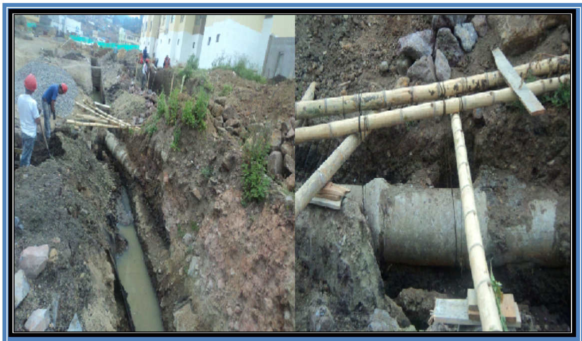
Figura 23 Protección a tubería de alcantarillado sanitario existente 14"
