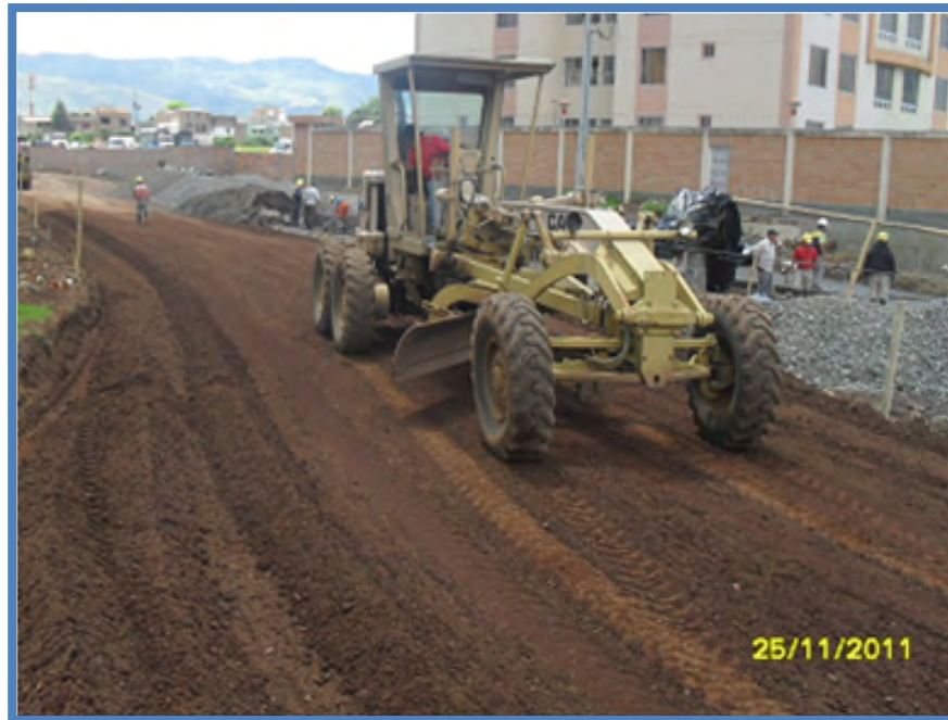
Figura 40 Conformación de base granular eje 2
