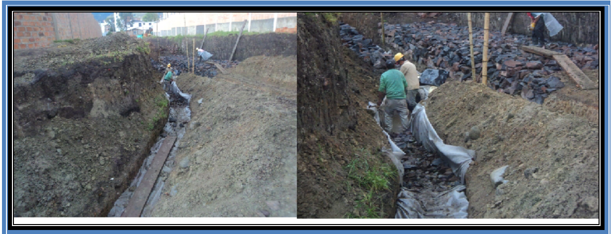
Figura 19 Cerramiento de geotextil sobre filtro 0,60*0,90
