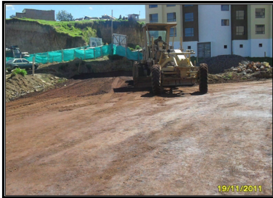
Figura 39 Base granular intersección ejes 1- 2 y 4.
