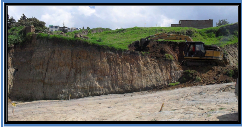
Figura 4 Inicio de excavación a máquina/corte talud
