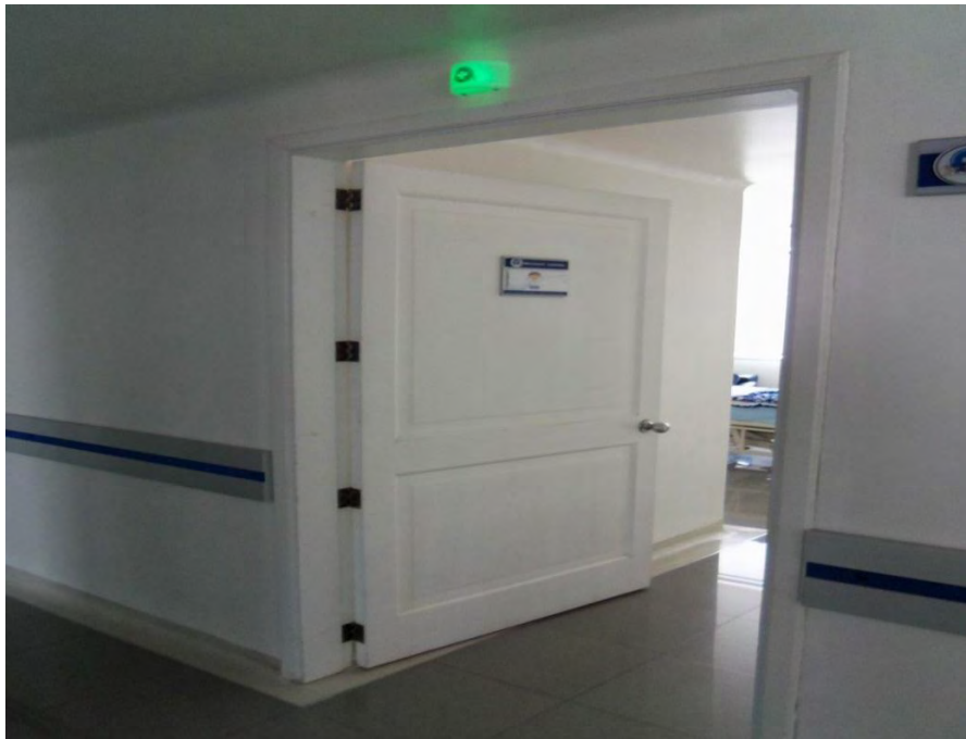
Figura 25. Luz dintel - Hospitalización
