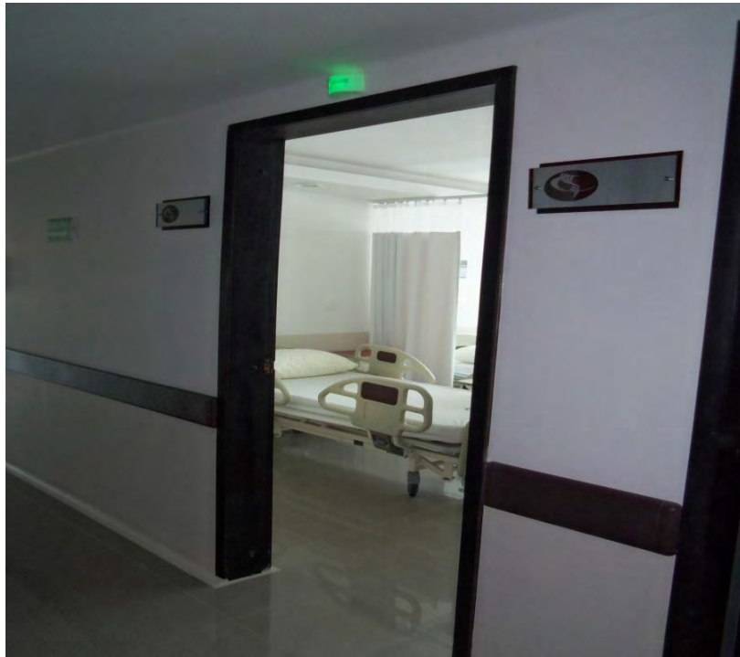
Figura 20. Luz dintel - Urgencias
