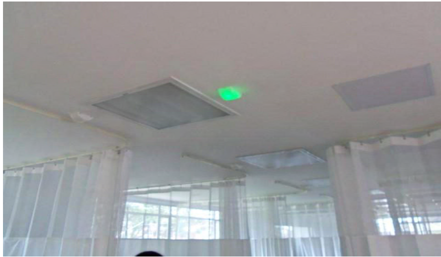
Figura 18. Luz Dintel - Urgencias
