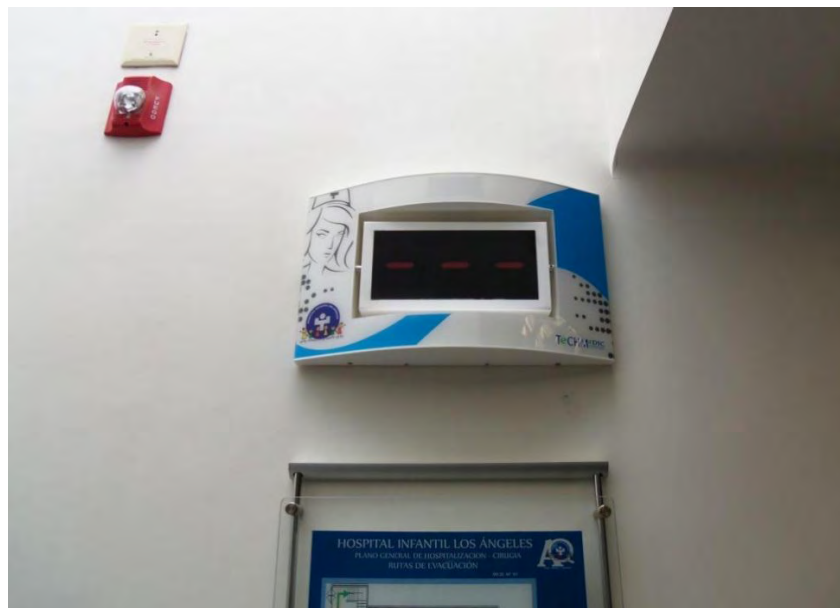
Figura 23. Estación de enfermería - Quirúrgicas
