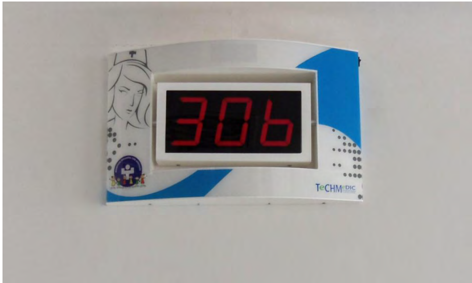
Figura 24. Módulo central llamado de enfermería - Quirúrgicas
