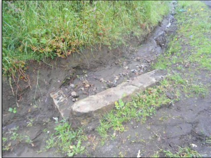
Fotografía 4.2. Alcantarilla de concreto ubicada en la vereda Huertecillas.
