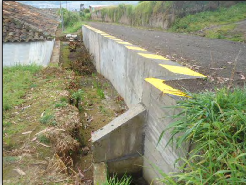
Fotografía 4.4. Muro de contención ubicado en la vereda Fátima.
