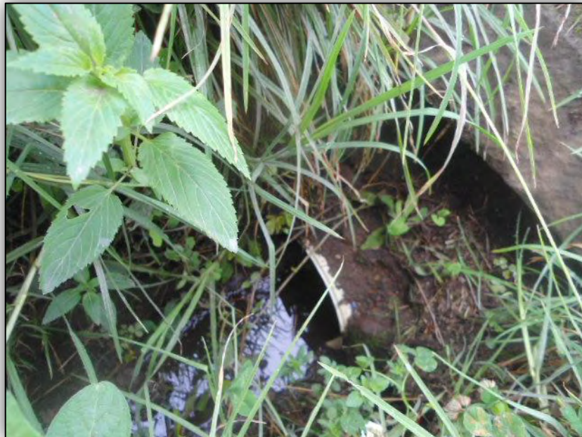
Fotografía 4.3. Alcantarilla artesanal ubicada en la vereda Huertecillas.
