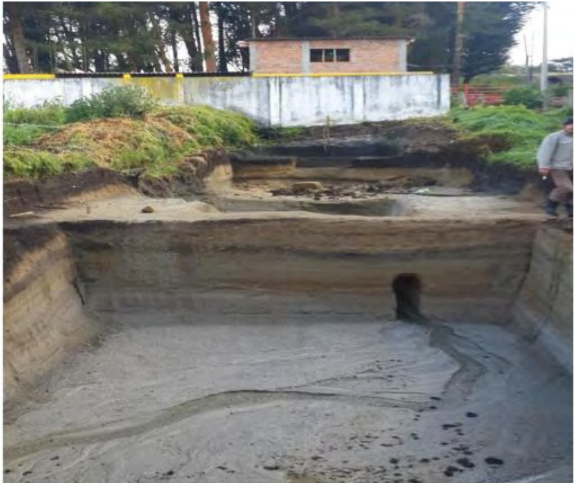
Figura 21. Estado actual de la zona de construcción para PTAR Y PTAP.
