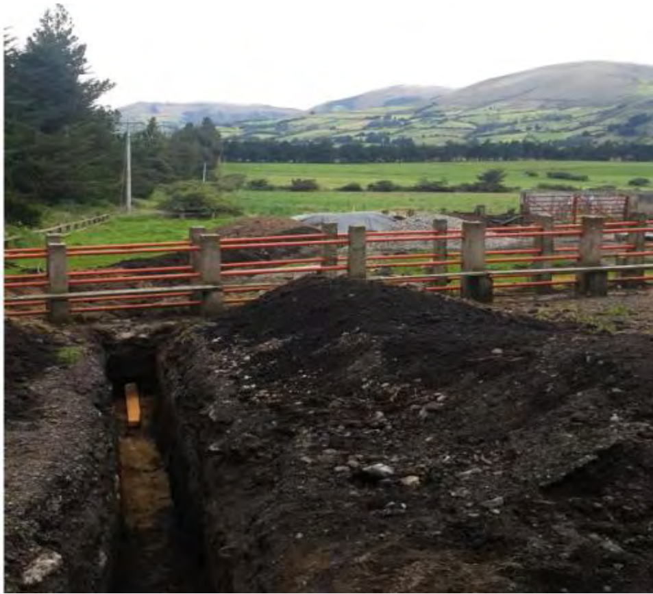
Figura 25. Estado actual de la zona de construcción de la primera etapa de la PTAP y la PTAR.
