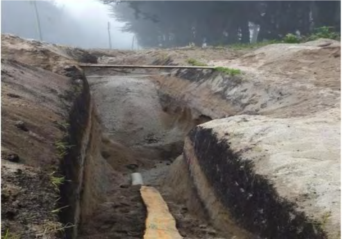
Figura 24. Instalación de tubería sanitaria.
