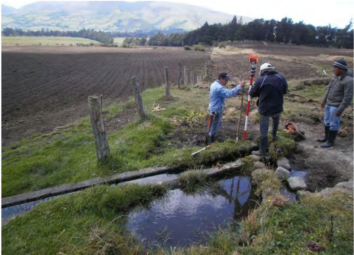
Figura 22. Replanteo topográfico de las estructuras.
