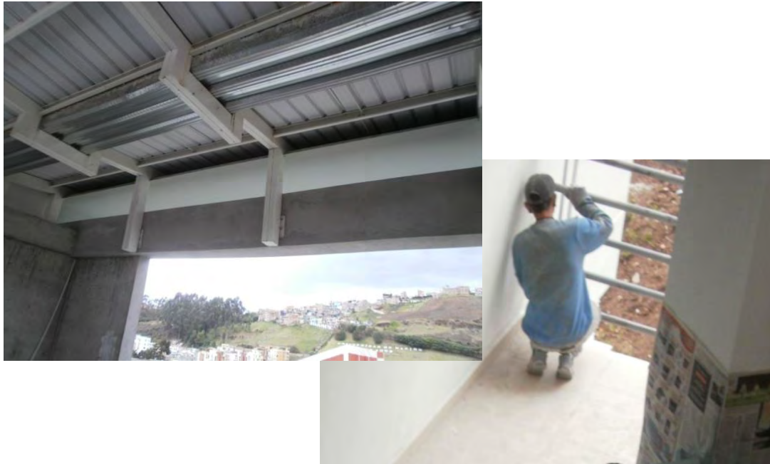
Figura 09. Seguimiento en la aplicación de estucos y pinturas.
