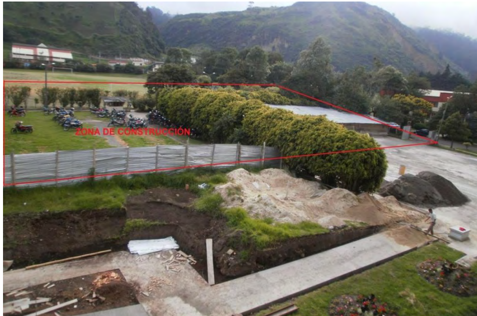
Figura 03. Estado inicial de la zona de construcción.
