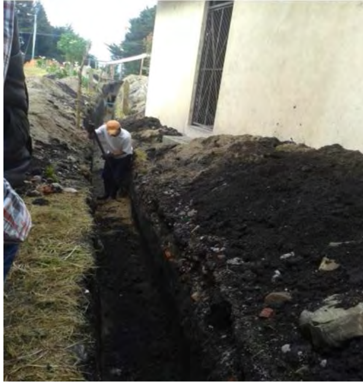
Figura 23. Excavación manual para instalación de tubería.
