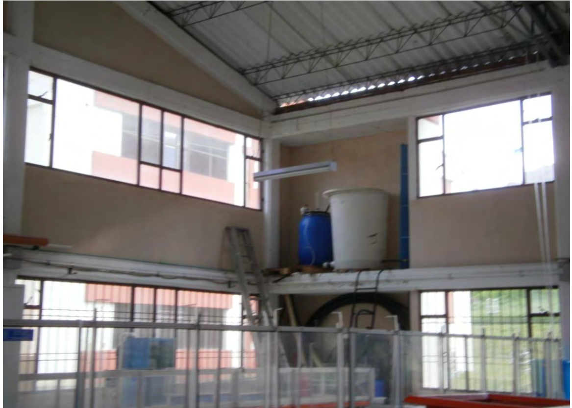
Figura 28. Estado actual del laboratorio de Hidráulica en la Facultad de Ingeniería.
