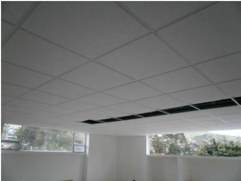
Figura 12. Seguimiento en la instalación de sistemas livianos.
