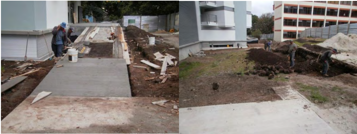
Figura 05. Registro fotográfico en la construcción de rampa de acceso sur.
