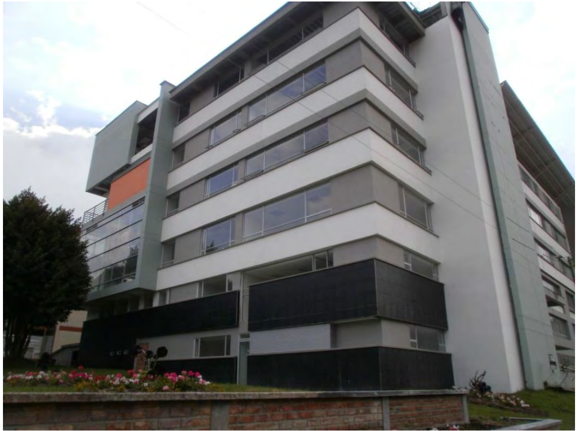
Figura 18. Fachada sur del edificio tecnológico.
