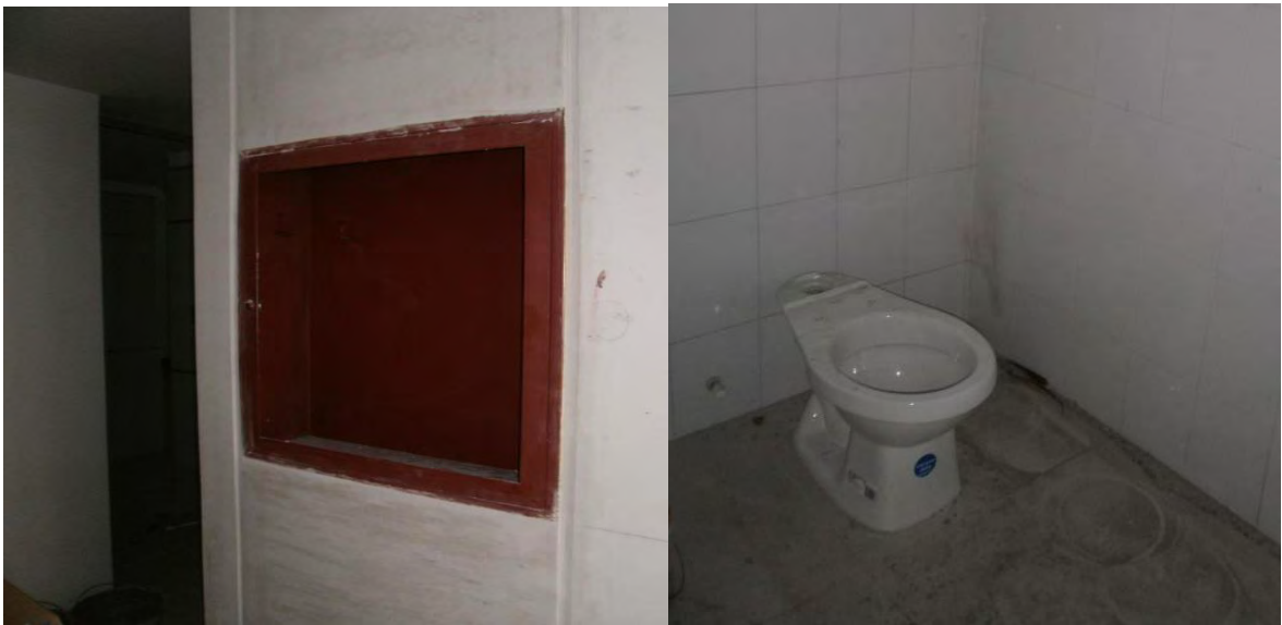
Figura 08. Instalación de aparatos y baterías sanitarias.
