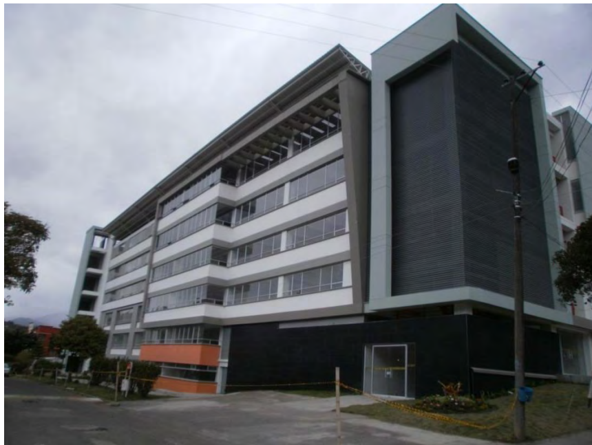
Figura 17. Fachada nororiental del edificio tecnológico.
