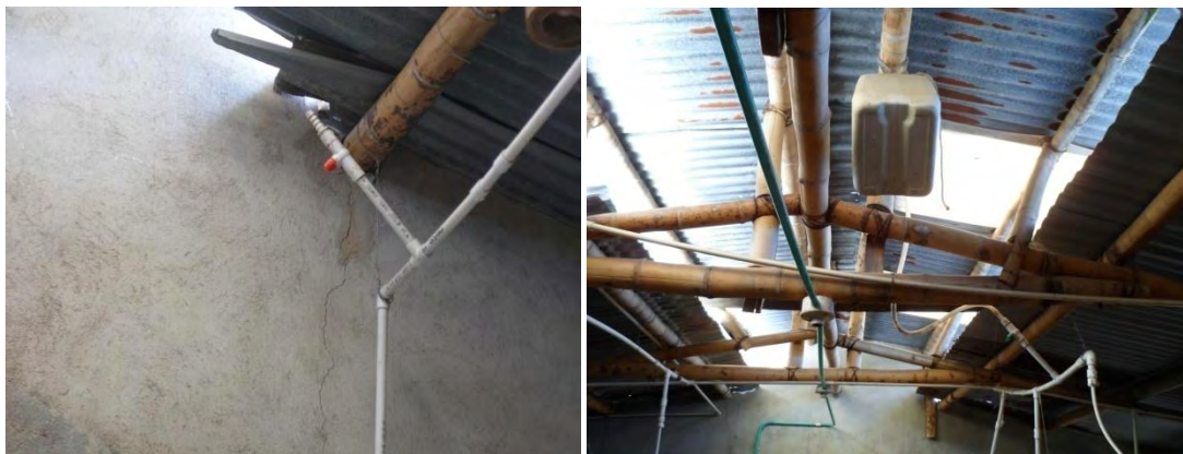
Figura 13. Modificación tubería de agua
