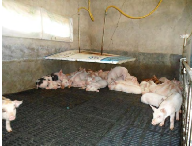
Figura 16. Placa metálica sobre los calefactores
