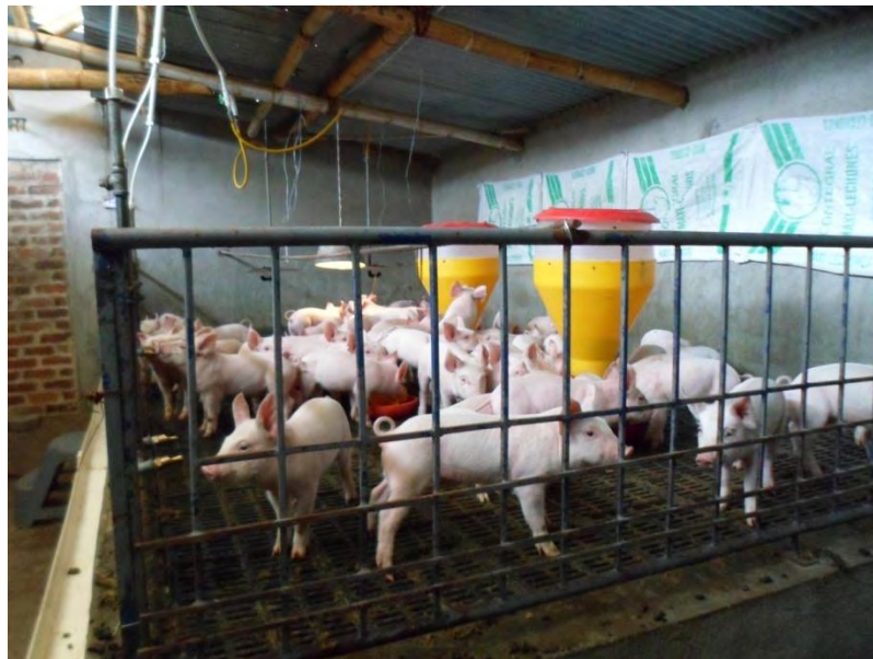
Figura 17. Calefacción eléctrica precebo
