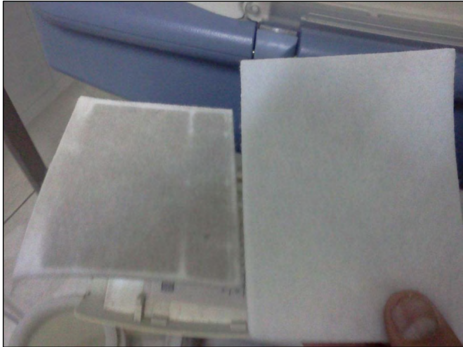
Figura 31. Verificación cambio de filtros.
