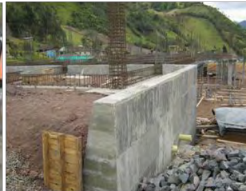
Muro de contención
