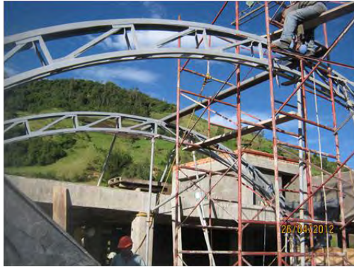
Instalación de cerchas metálicas
