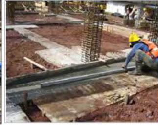
Solado de vigas
