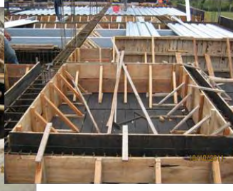
Formaleta de vigas
