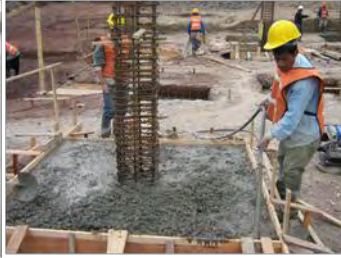
Fundición de zapatas
