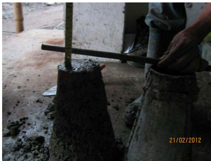
Ilustración 18. Prueba de slump en obra
