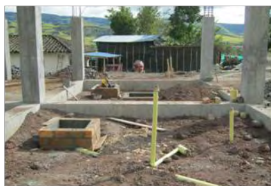
Cajas de inspección
