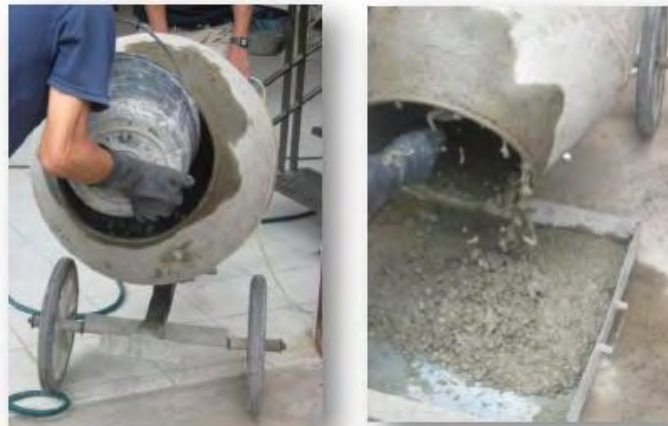
Ilustración 24. Preparación de la mezcla
