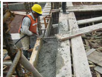
Fundición de vigas
