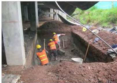
Excavación a mano
