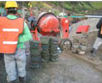
Preparacion del concreto
