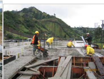
Fundición placa de contrapiso
