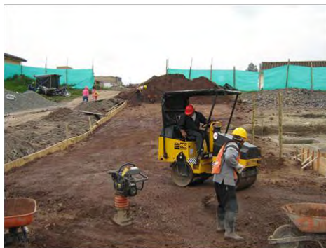
Compactación en obra
