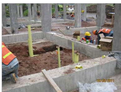
Instalacion de tubería sanitaria
